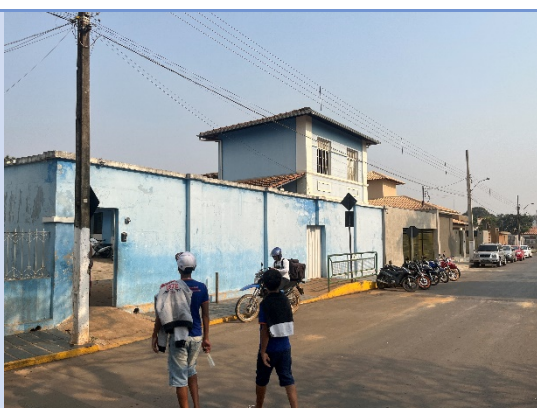
Foto 5: Vista para o terceiro volume edificado. Edilson Borges, 6 set. 2024.
