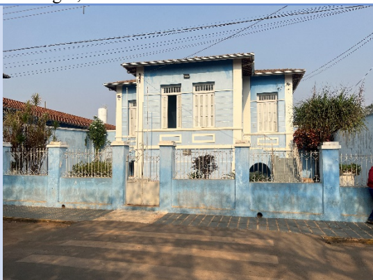
Foto 3: Detalhe do primeiro volume construído no edifício. Edilson Borges, 6 set. 2024.
