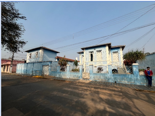
Foto 1: Vista geral da Escola Estadual Diogo de Castro. Edilson Borges, 6 set. 2024.
