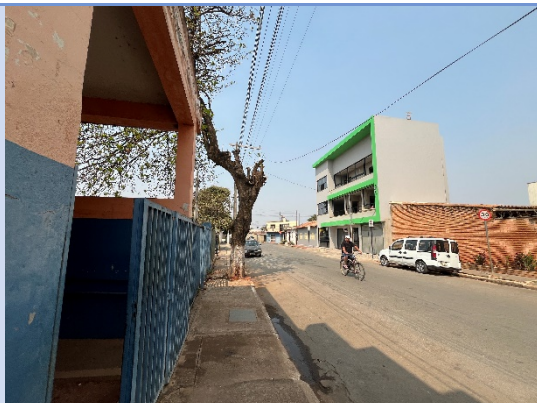
Foto 2: Entorno imediato do edifício. Edilson Borges, 6 set. 2024.
