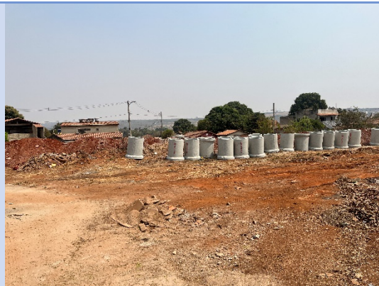
Foto 2: Obra de saneamento para instalação de manilhas, nas imediações. Edilson Borges, 6 set. 2024.
