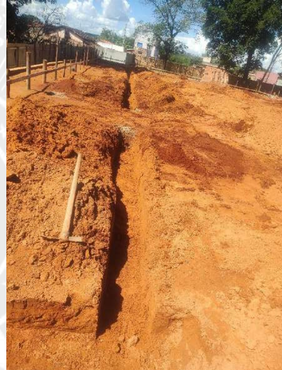
Foto 32 – Escavação de valas das cintas de fundação
