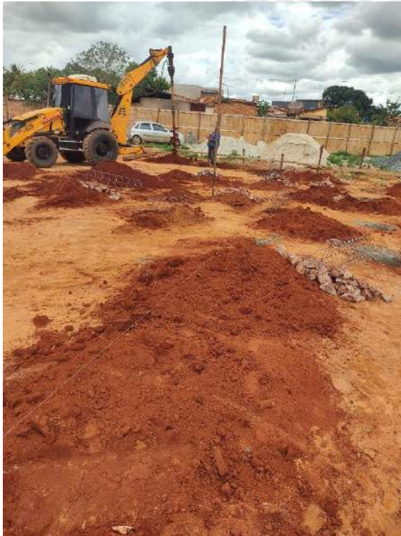
Foto 23 - Execução de estacas de fundação
