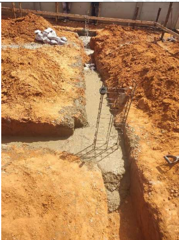
Foto 67 – Concretagem de fundo de vala das cintas de fundação
