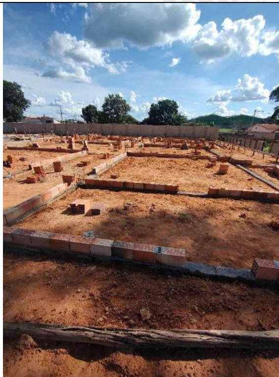
Foto 177 – impermeabilização das cintas e assentamento de alvenaria
