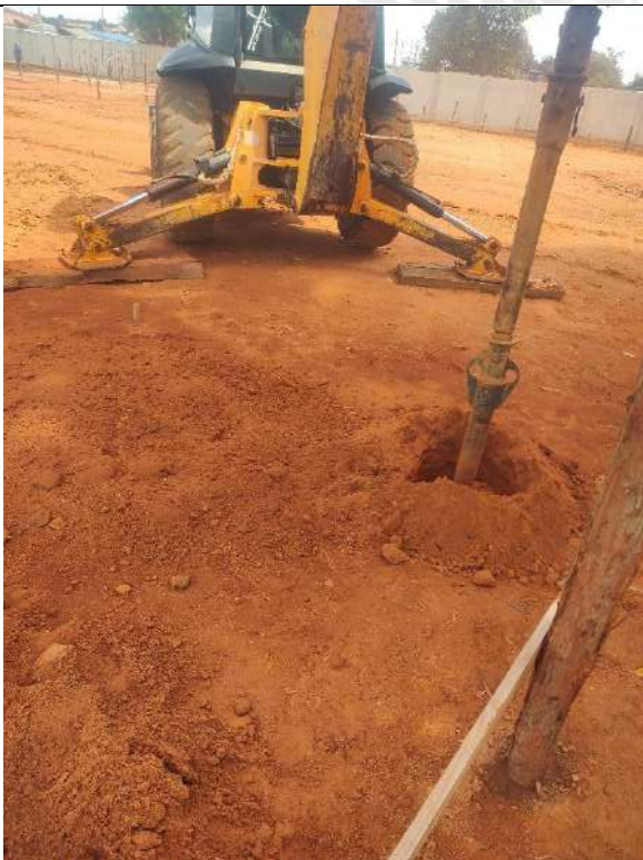
Foto 9 – Perfuração de estacas de fundação
