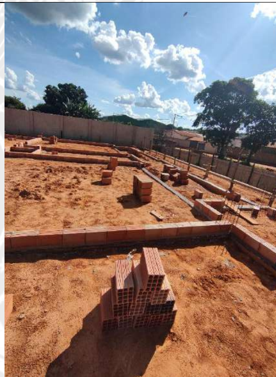
Foto 188 – impermeabilização das cintas e assentamento de alvenaria
