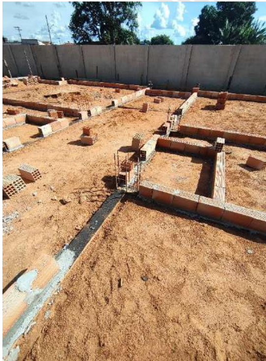
Foto 193 – impermeabilização das cintas e assentamento de alvenaria
