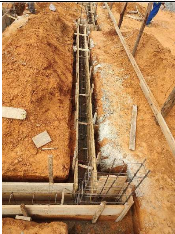
Foto 69 – Execução de forma das cintas de fundação
