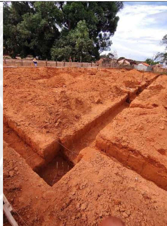
Foto 46 - Escavação de valas das cintas e dos blocos de fundação
