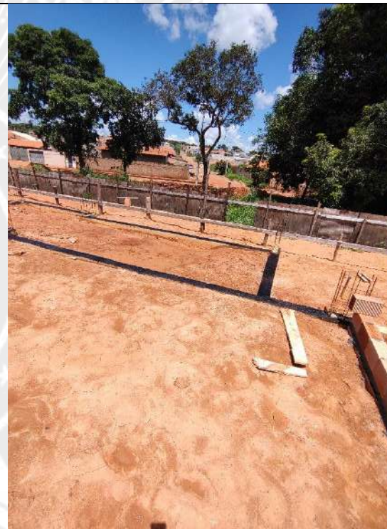
Foto 168 – impermeabilização das cintas e assentamento de alvenaria
