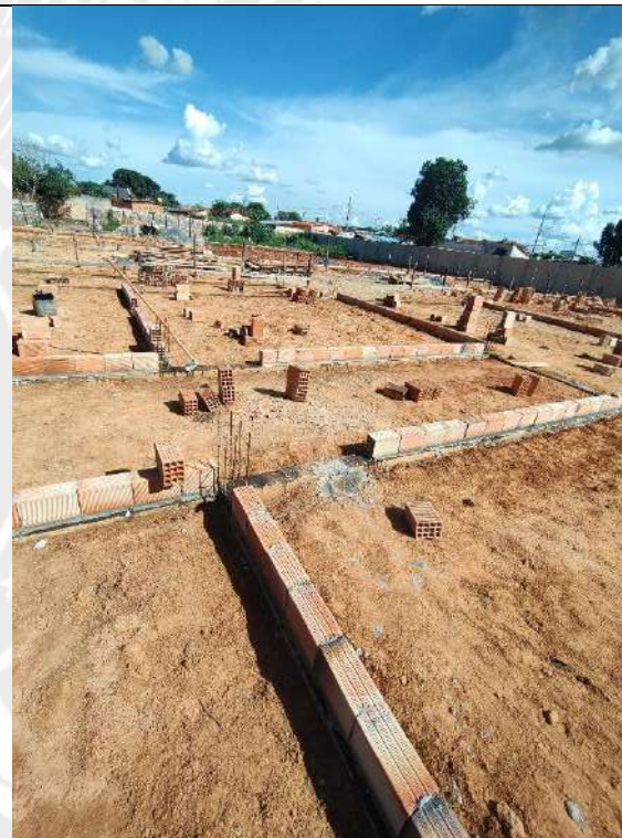
Foto 184 – impermeabilização das cintas e assentamento de alvenaria
