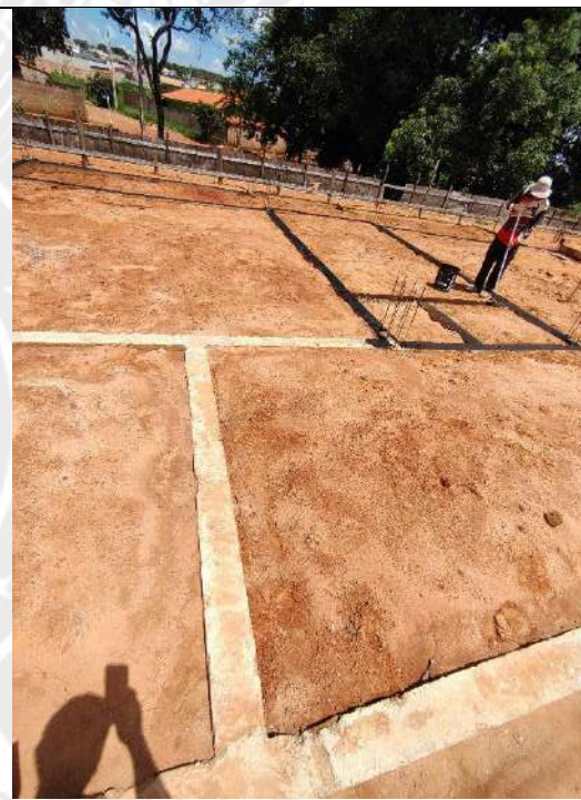
Foto 160 – impermeabilização das cintas e acerto compactado de terreno
