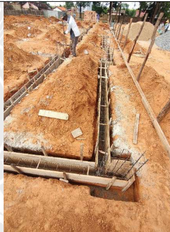
Foto 70 – Execução de forma das cintas de fundação
