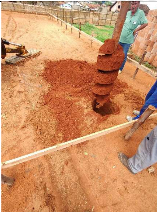
Foto 7 - Perfuração de estacas de fundação
