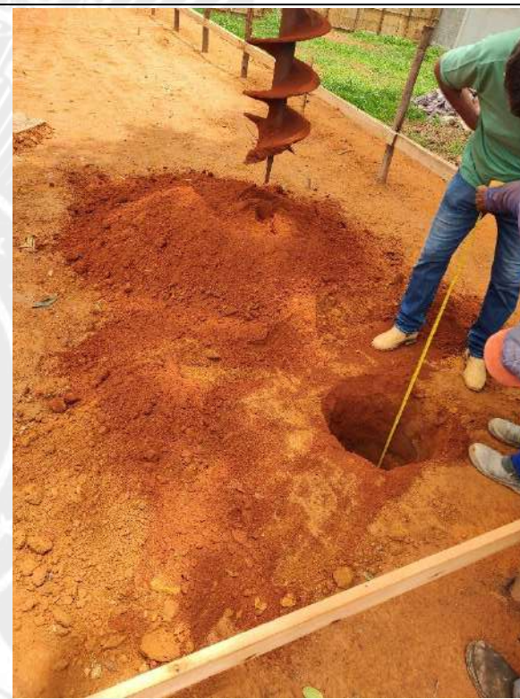
Foto 4 – Execução de estacas de fundação
