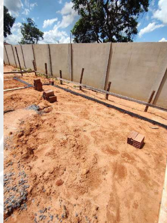
Foto 162 – impermeabilização das cintas e acerto compactado de terreno
