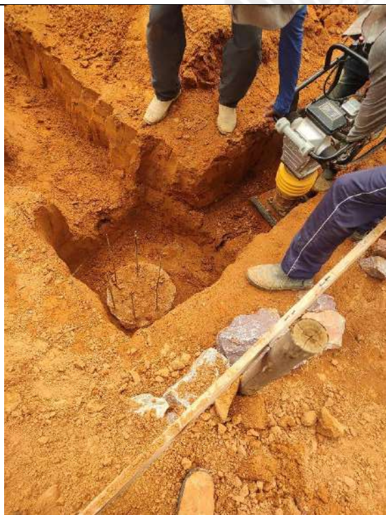
Foto 89 – Compactação de fundo de vala das cintas de fundação
