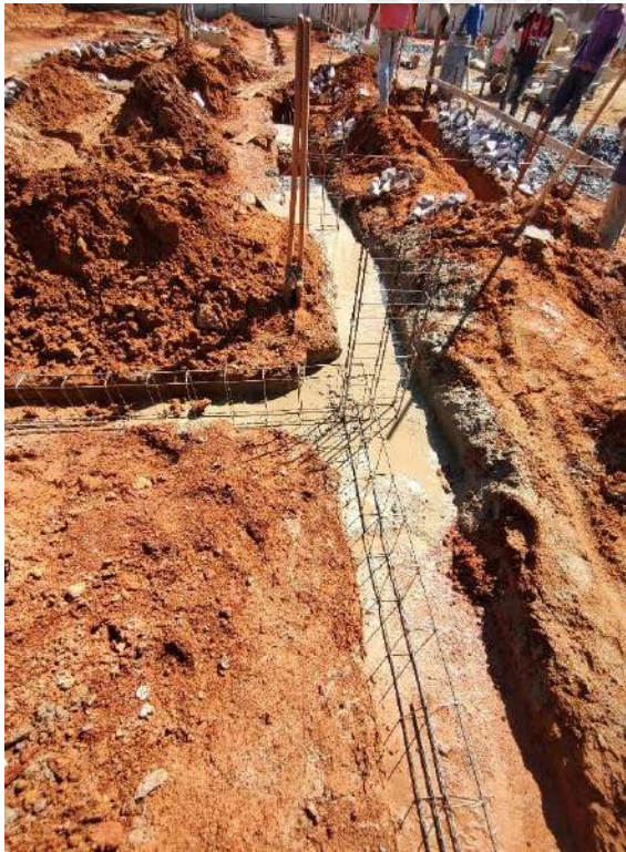
Foto 119 – Forma e concretagem das cintas de fundação
