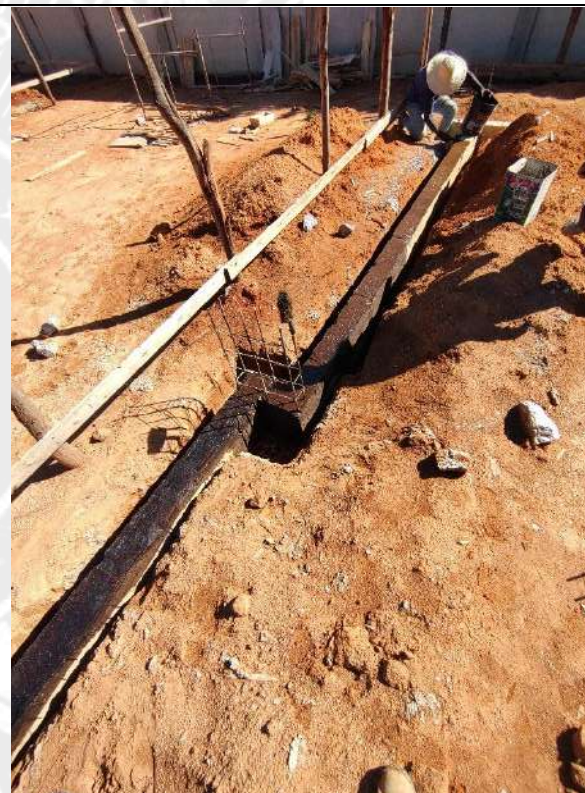
Foto 110 – Impermeabilização das cintas de fundação
