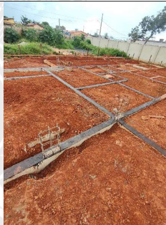
Foto 208 – impermeabilização das cintas e acerto compactado de terreno
