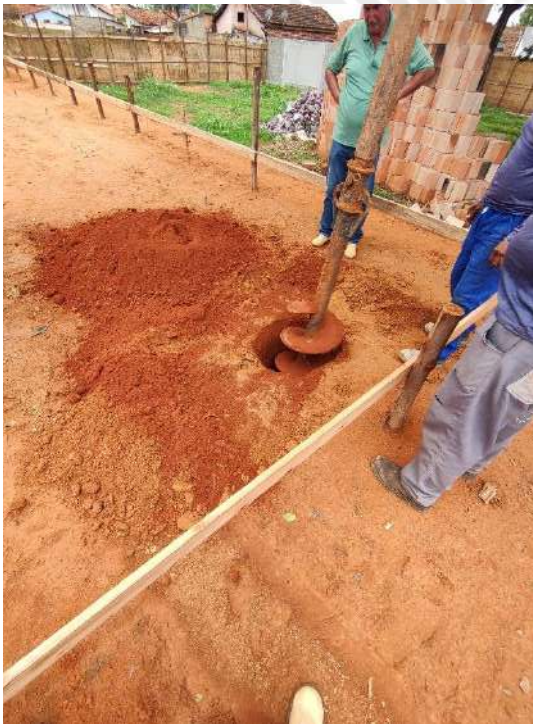
Foto 5 - Perfuração de estacas de fundação
