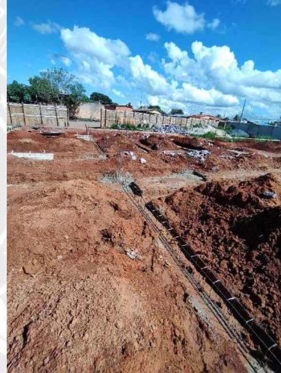
Foto 120 – Forma e concretagem das cintas de fundação
