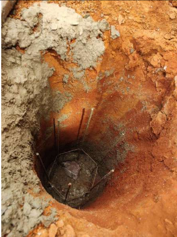
Foto 15 - Execução de estacas de fundação
