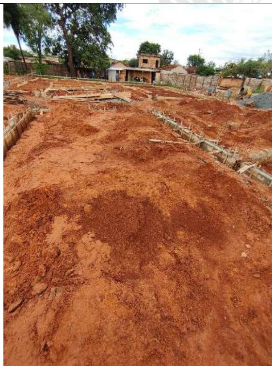
Foto 127 – Forma e concretagem das cintas de fundação
