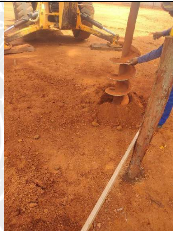
Foto 8 – Perfuração de estacas de fundação
