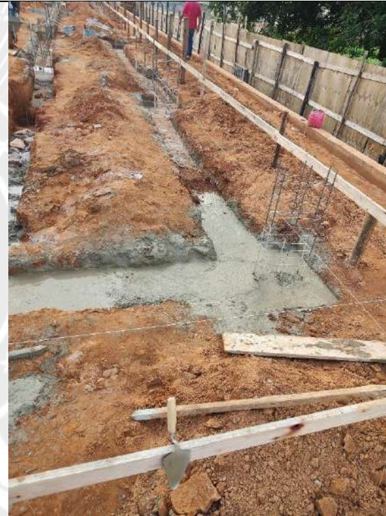
Foto 92 – Concretagem de blocos, pilares e fundo de vala das cintas de fundação
