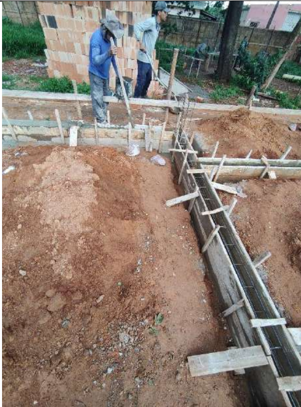
Foto 107 – Forma e concretagem das cintas de fundação
