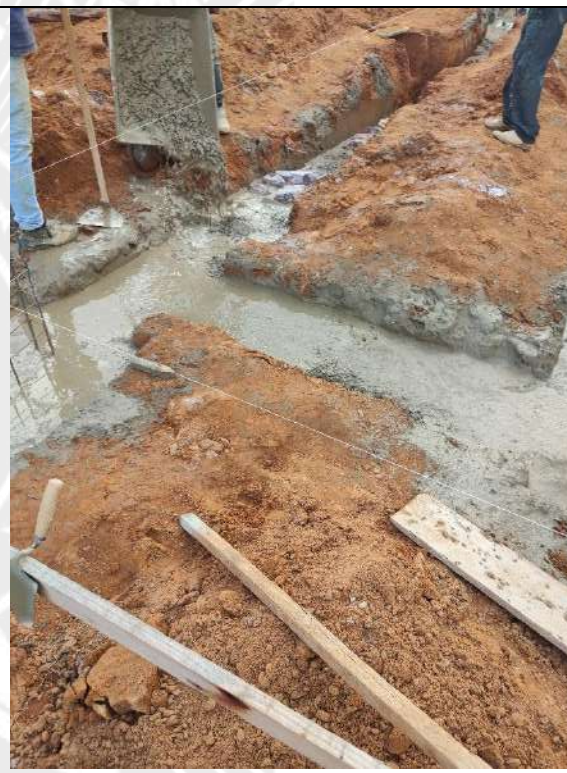
Foto 94 – Concretagem de blocos, pilares e fundo de vala das cintas de fundação
