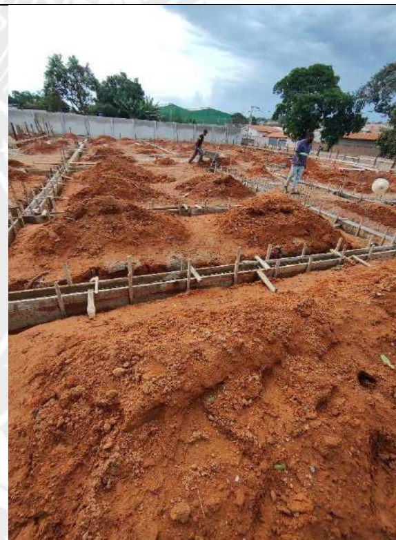
Foto 106 – Forma e concretagem das cintas de fundação
