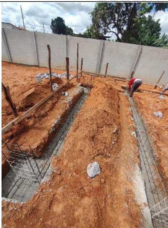
Foto 65 – Instalação das armaduras das cintas de fundação
