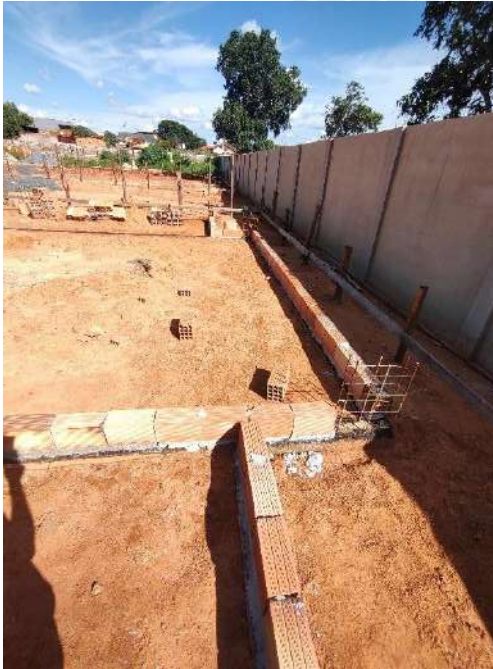
Foto 197 – impermeabilização das cintas e acerto compactado de terreno
