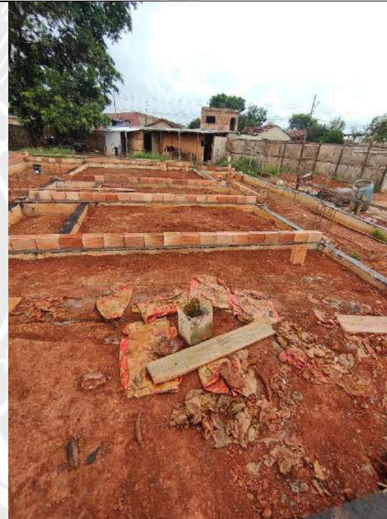
Foto 212 – impermeabilização das cintas e assentamento de alvenaria
