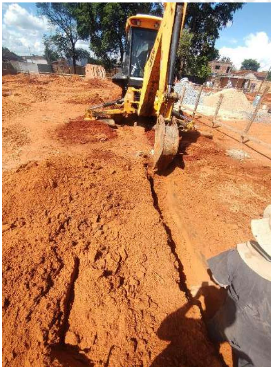
Foto 35 - Escavação de valas das cintas de fundação
