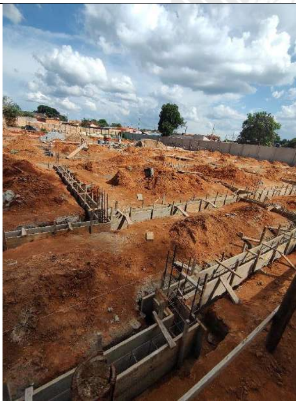
Foto 105 – Forma e concretagem das cintas de fundação
