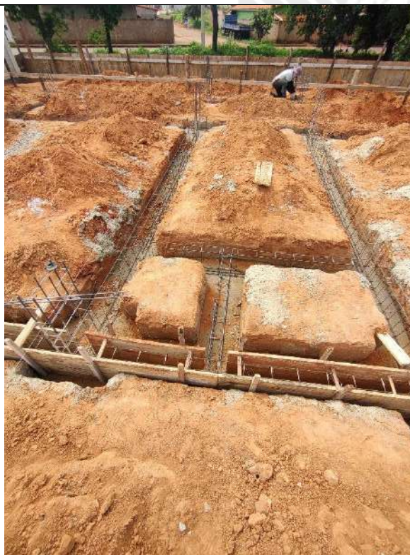
Foto 77 – Execução de forma das cintas de fundação
