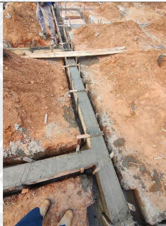
Foto 80 – Execução de forma e concretagem das cintas de fundação
