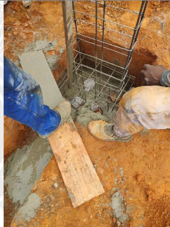
Foto 50 – Concretagem de blocos, pilares e fundo de vala das cintas de fundação
