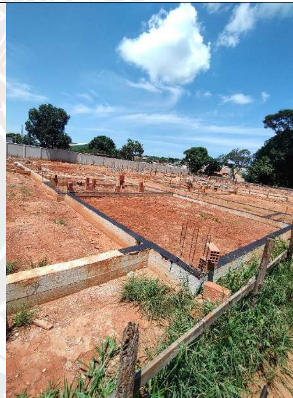
Foto 200 – impermeabilização das cintas e acerto compactado de terreno
