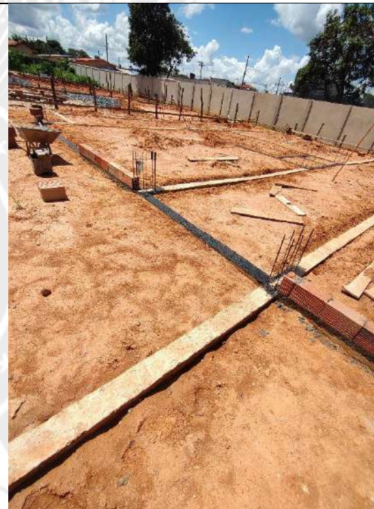
Foto 174 – impermeabilização das cintas e assentamento de alvenaria
