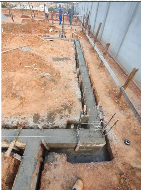
Foto 79 – Execução de forma e concretagem das cintas de fundação
