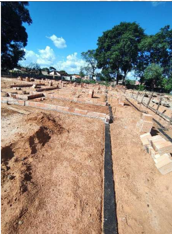
Foto 199 – impermeabilização das cintas e acerto compactado de terreno
