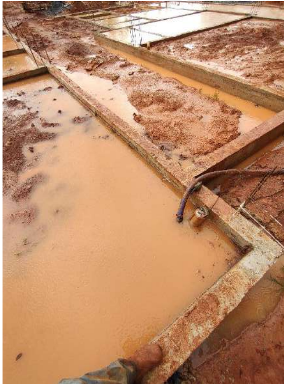
Foto 151 – Bombeamento de água de chuva
