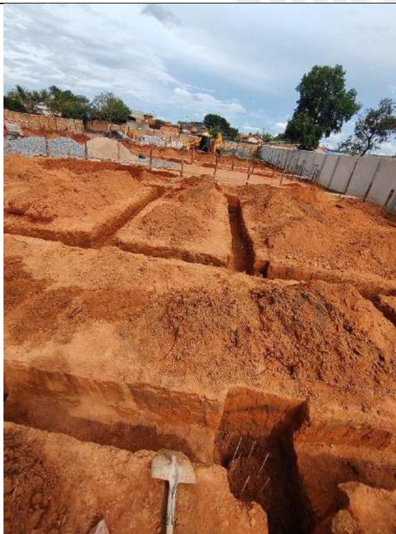
Foto 41 – Escavação de valas das cintas e dos blocos de fundação
