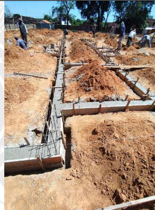
Foto 86 – Execução de forma e concretagem das cintas de fundação
