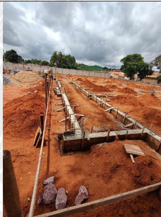
Foto 116 – Forma e concretagem das cintas de fundação
