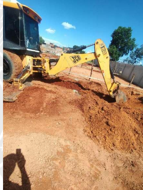
Foto 34 – Escavação de valas das cintas de fundação
