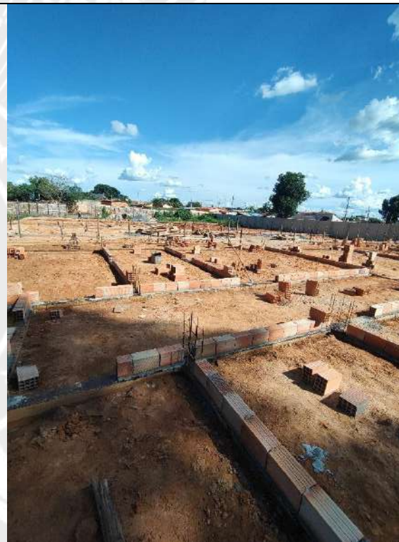
Foto 178 – impermeabilização das cintas e assentamento de alvenaria
