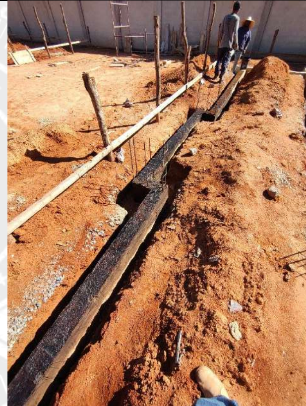
Foto 112 – Impermeabilização das cintas de fundação
