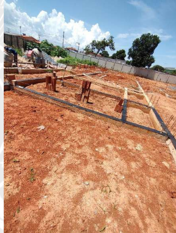
Foto 202 – impermeabilização das cintas e acerto compactado de terreno
