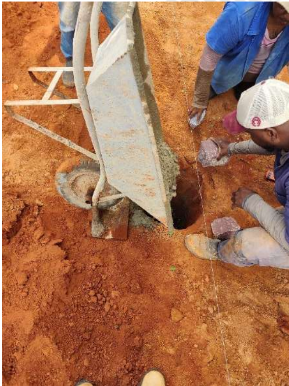
Foto 13 – Concretagem das estacas de fundação
