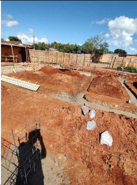
Foto 121 – Forma e concretagem das cintas de fundação
