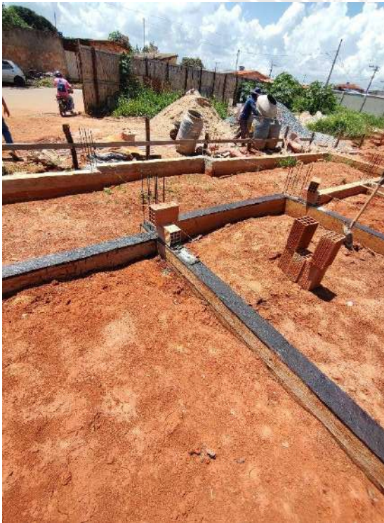
Foto 205 – impermeabilização das cintas e acerto compactado de terreno
