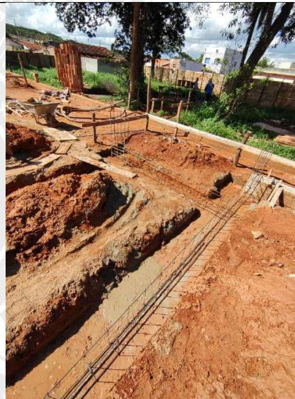
Foto 118 – Forma e concretagem das cintas de fundação
