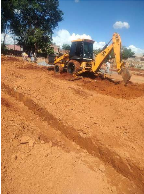
Foto 31 - Escavação de valas das cintas de fundação
