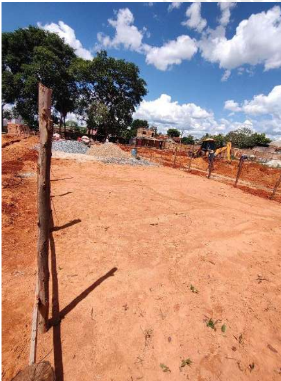
Foto 37 – Escavação de valas das cintas de fundação
