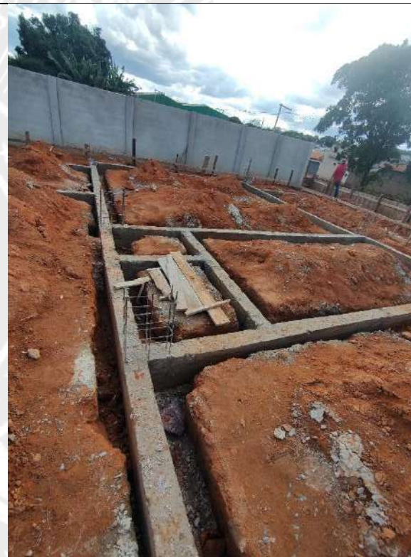
Foto 98 – Desforma das cintas de fundação
