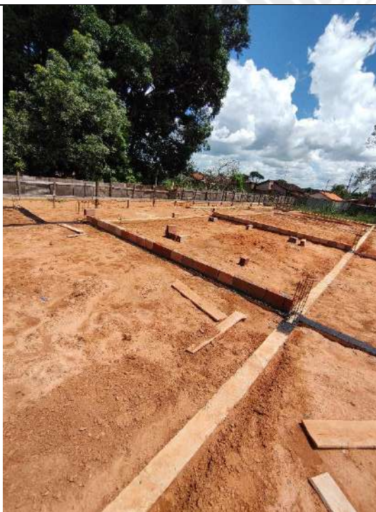
Foto 165 – impermeabilização das cintas e acerto compactado de terreno
