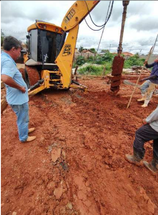
Foto 157 – Perfuração de estacas de fundação
