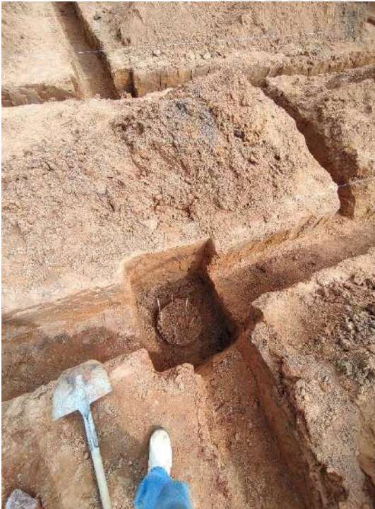
Foto 43 - Escavação de valas das cintas e dos blocos de fundação
