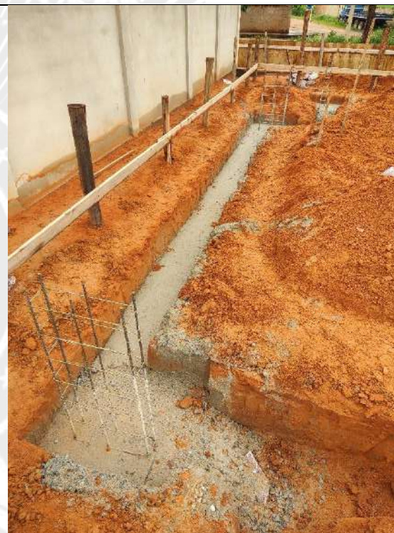
Foto 56 – Concretagem de blocos, pilares e fundo de vala das cintas de fundação
