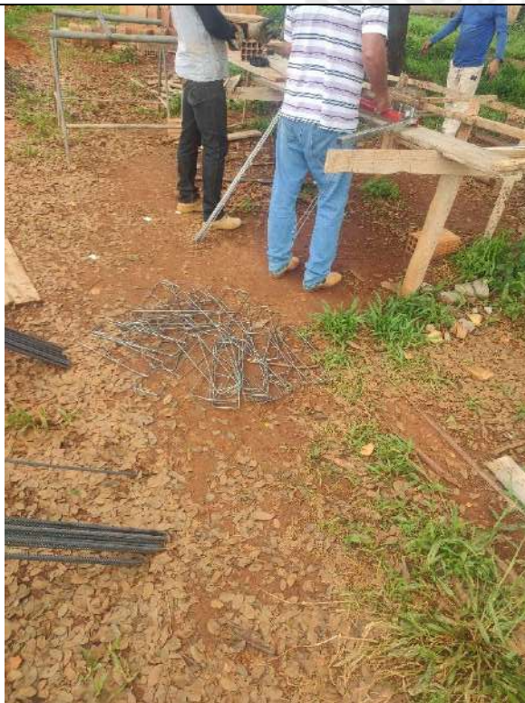
Foto 27 – Armação de ferragens
