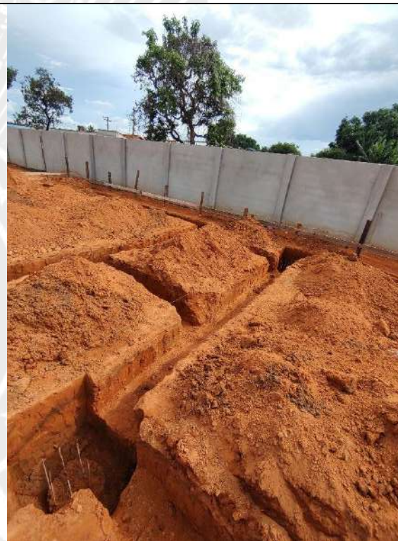
Foto 42 - Escavação de valas das cintas e dos blocos de fundação
