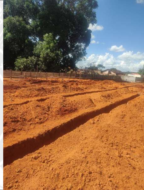
Foto 30 - Escavação de valas das cintas de fundação
