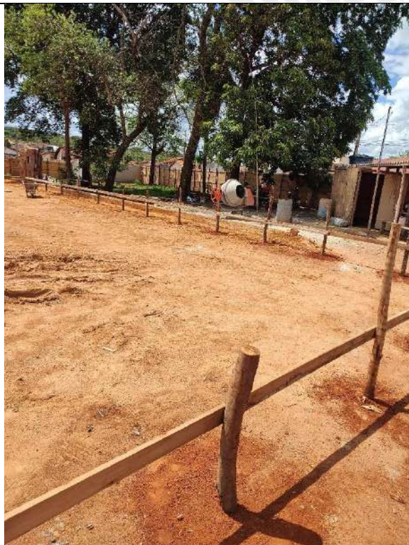
Foto 3 - Execução de gabarito para locação de obra
