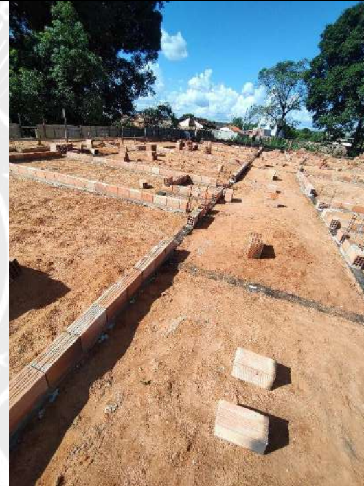
Foto 198 – impermeabilização das cintas e acerto compactado de terreno
