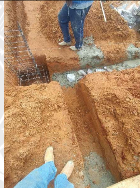
Foto 102 – Concretagem de pilares blocos e fundo de vala das cintas
