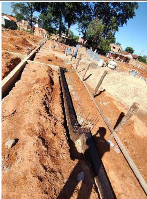
Foto 109 – Impermeabilização das cintas de fundação
