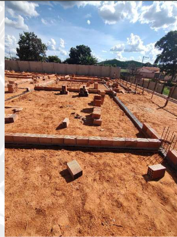
Foto 186 – impermeabilização das cintas e assentamento de alvenaria
