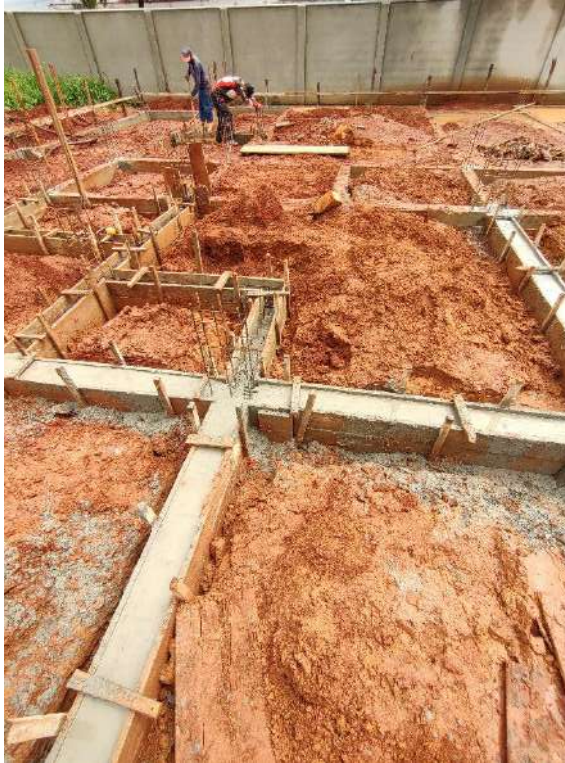
Foto 149 – Forma e concretagem de cintas de fundação
