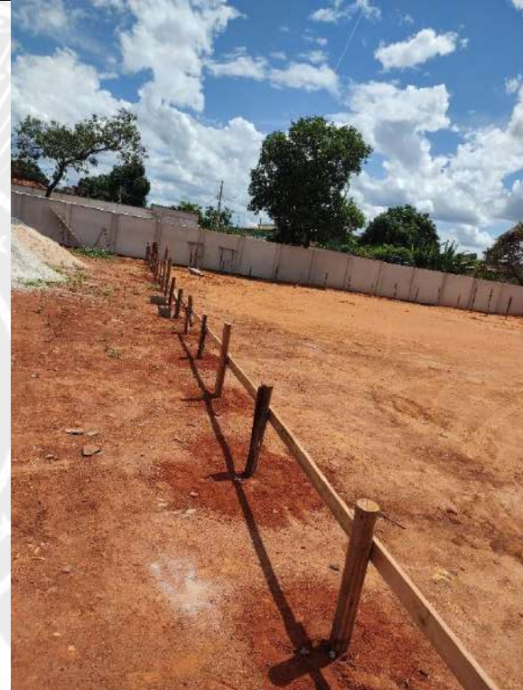
Foto 2 – Execução de gabarito para locação de obra
