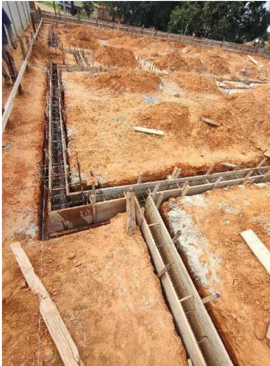
Foto 71 – Execução de forma das cintas de fundação
