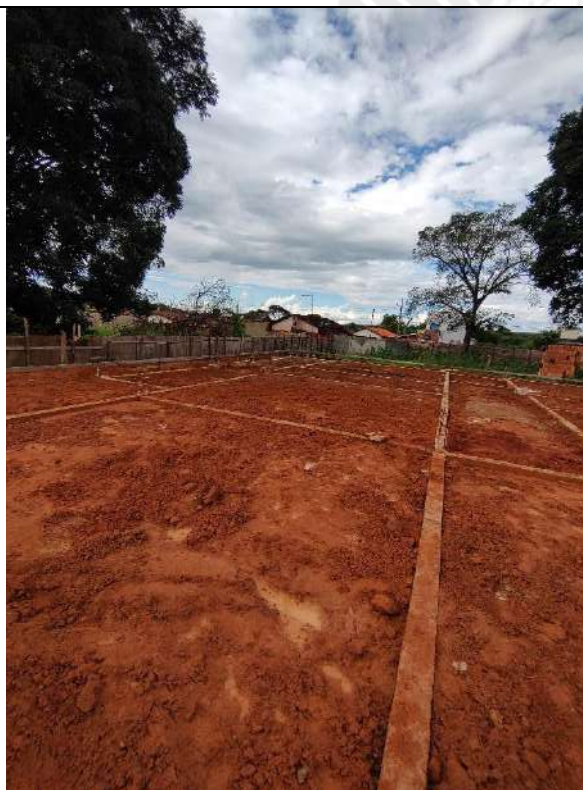
Foto 137 – Acerto compactado de terreno
