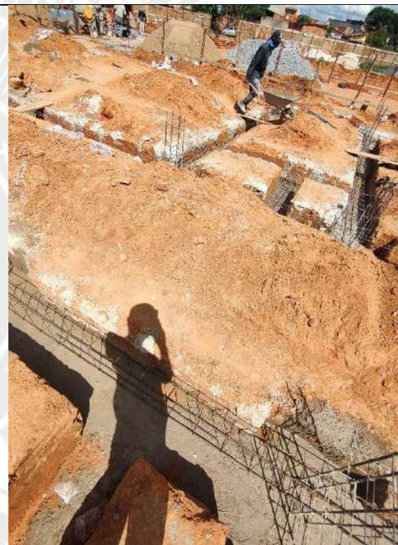
Foto 68 – Instalação das armaduras das cintas de fundação
