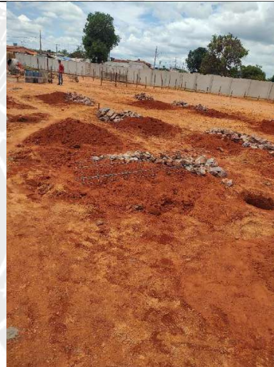
Foto 18 – Execução de estacas de fundação
