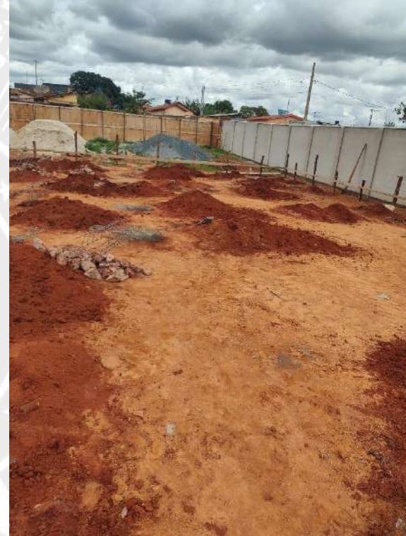
Foto 24 - Execução de estacas de fundação
