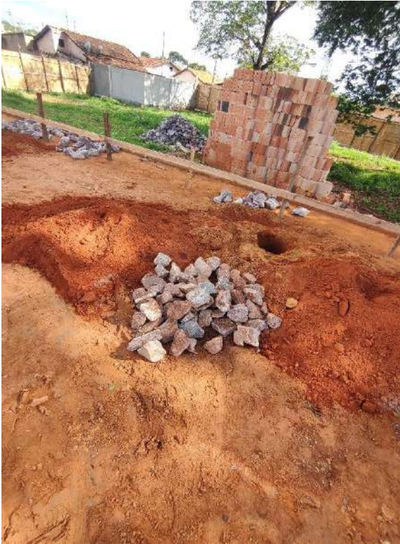
Foto 11 – Perfuração de estacas de fundação
