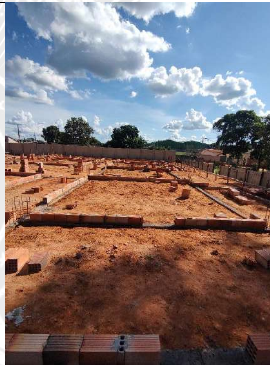
Foto 180 – impermeabilização das cintas e assentamento de alvenaria
