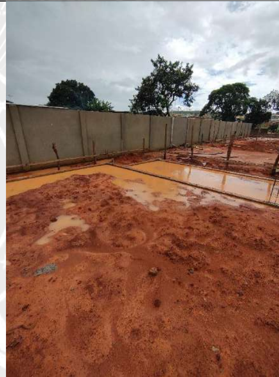
Foto 142 – Bombeamento de água de chuva
