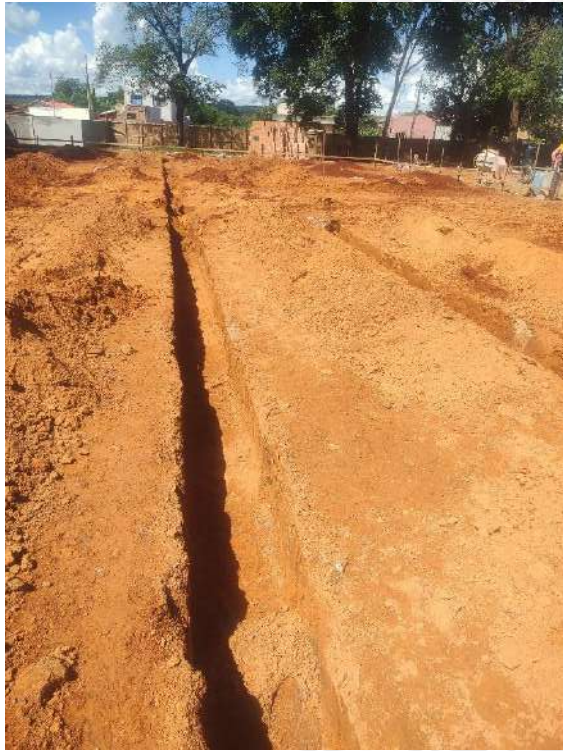
Foto 33 – Escavação de valas das cintas de fundação
