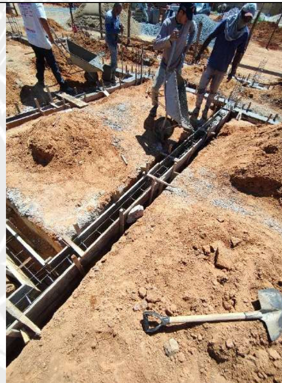
Foto 88 – Execução de forma e concretagem das cintas de fundação
