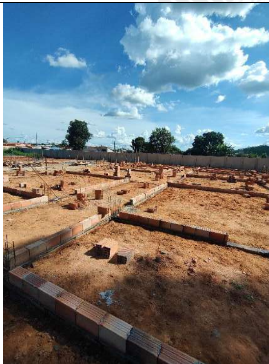
Foto 179 – impermeabilização das cintas e assentamento de alvenaria
