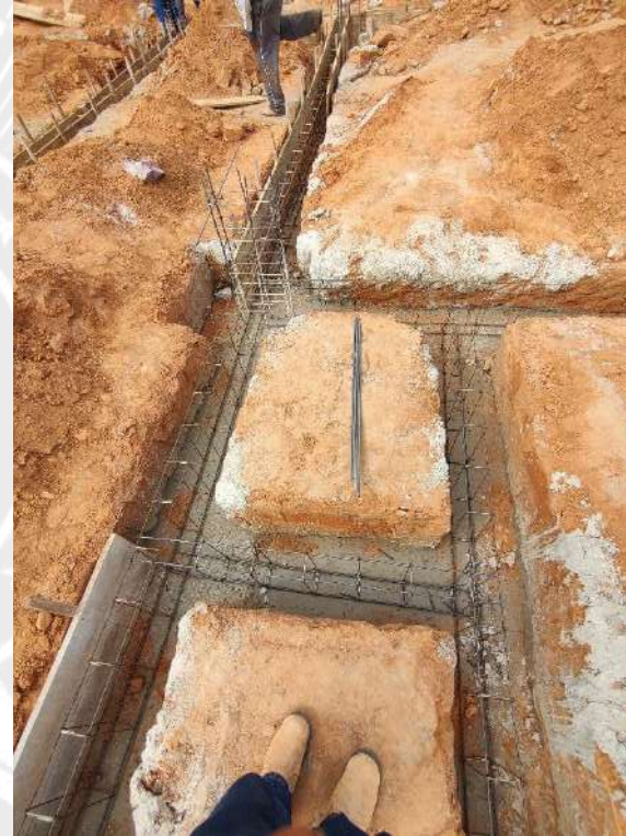
Foto 76 – Execução de forma das cintas de fundação
