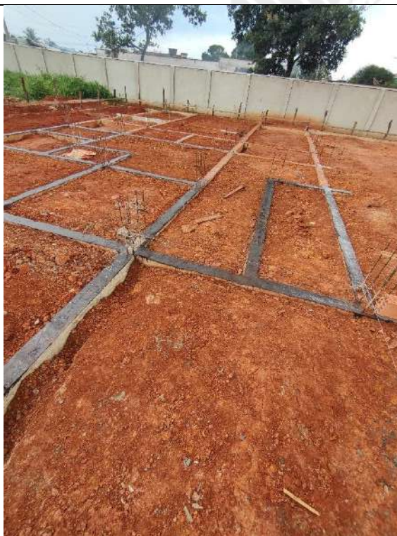
Foto 209 – impermeabilização das cintas e acerto compactado de terreno
