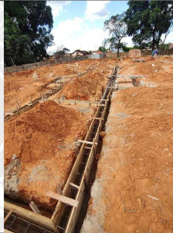
Foto 74 – Execução de forma das cintas de fundação
