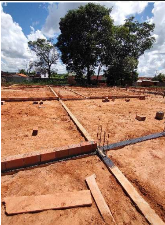
Foto 167 – impermeabilização das cintas e assentamento de alvenaria
