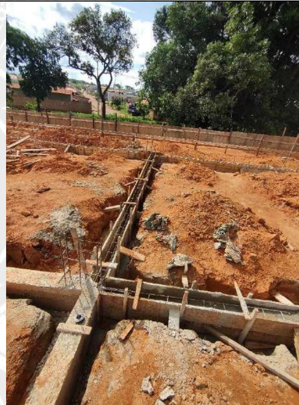
Foto 104 – Forma e concretagem das cintas de fundação
