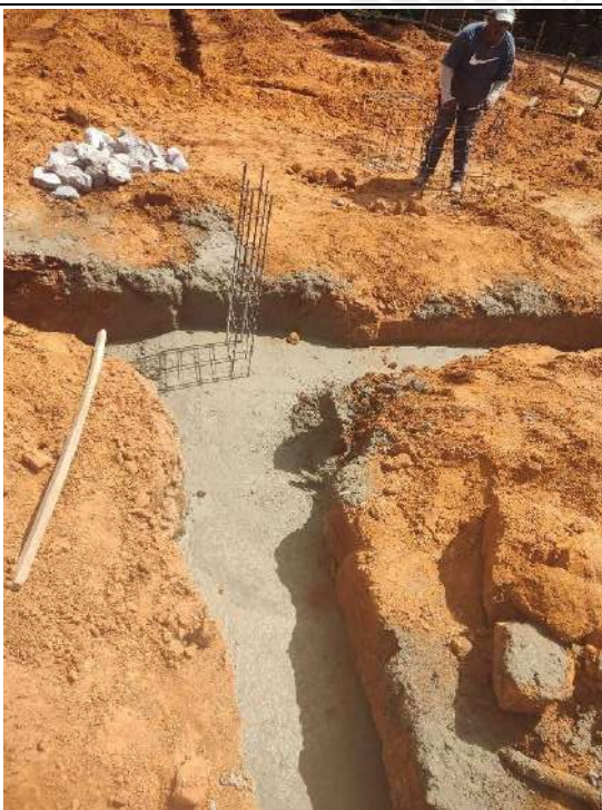
Foto 59 – Concretagem de blocos, pilares e fundo de vala das cintas de fundação
