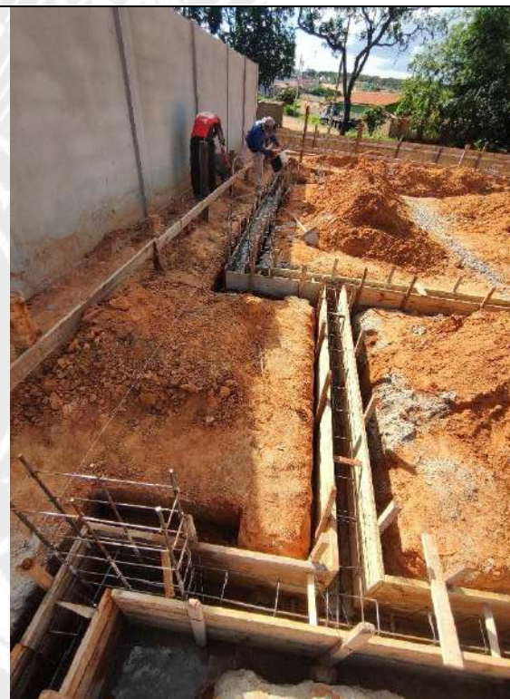
Foto 78 – Execução de forma e concretagem das cintas de fundação
