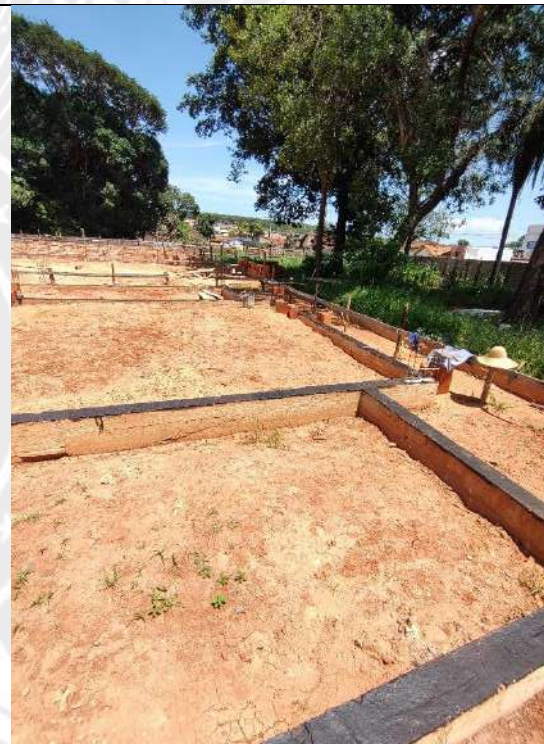
Foto 204 – impermeabilização das cintas e acerto compactado de terreno
