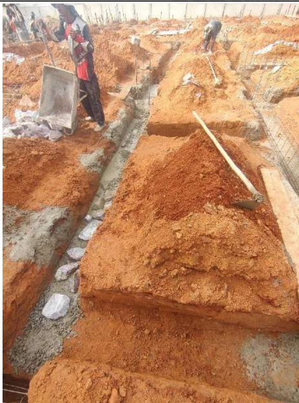
Foto 103 – Concretagem de pilares blocos e fundo de vala das cintas
