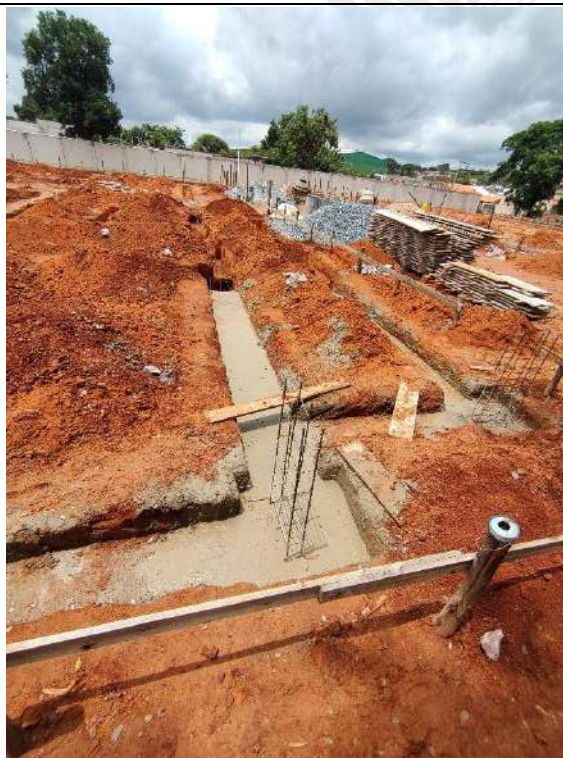
Foto 115 – Concretagem de pilares, blocos e fundo de vala das cintas
