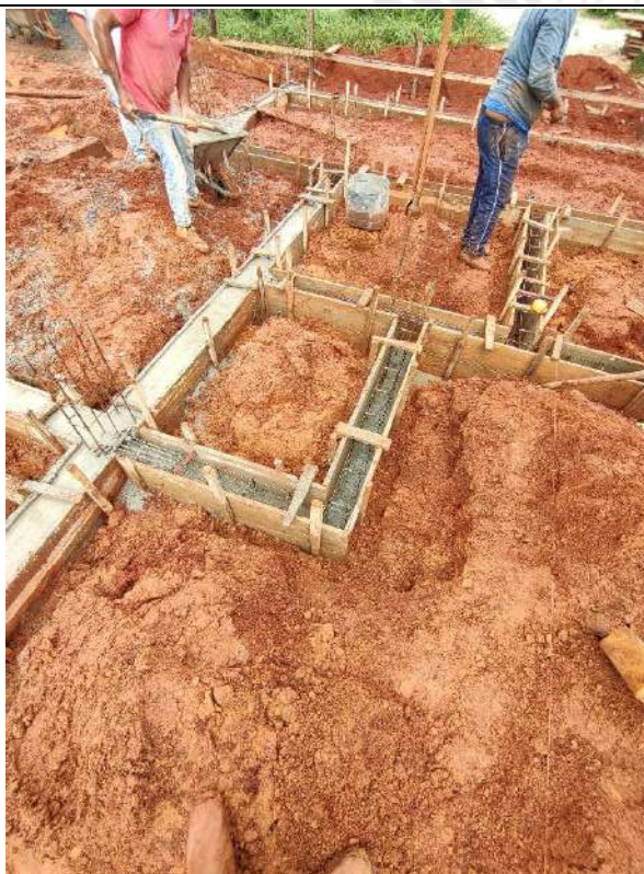
Foto 139 – Forma e concretagem das cintas de fundação
