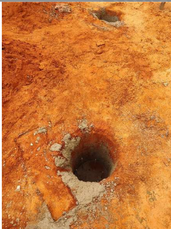
Foto 21 – Execução de estacas de fundação
