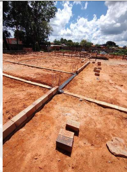
Foto 172 – impermeabilização das cintas e assentamento de alvenaria
