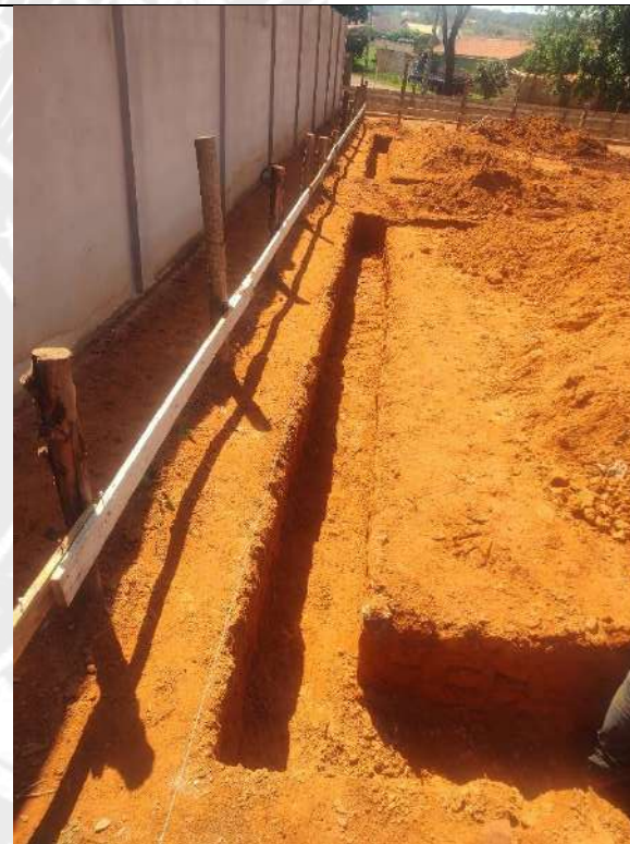
Foto 28 – Escavação de valas das cintas de fundação
