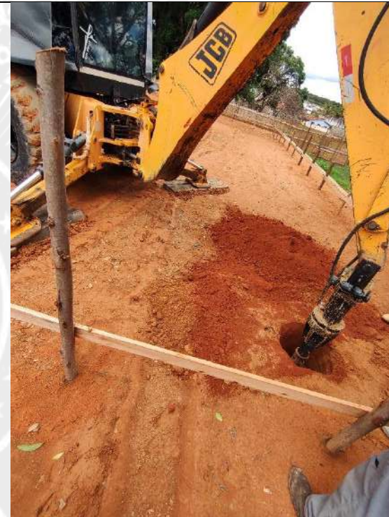
Foto 6 – Perfuração de estacas de fundação
