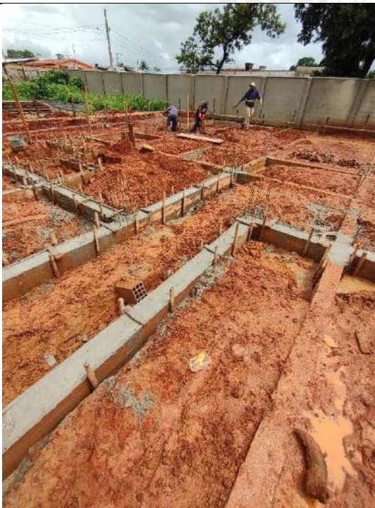
Foto 147 – Forma e concretagem de cintas de fundação
