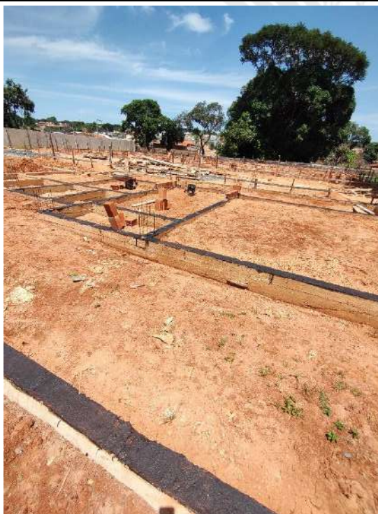
Foto 203 – impermeabilização das cintas e acerto compactado de terreno
