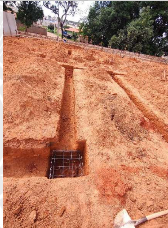
Foto 48 – Escavação de valas das cintas e dos blocos de fundação
