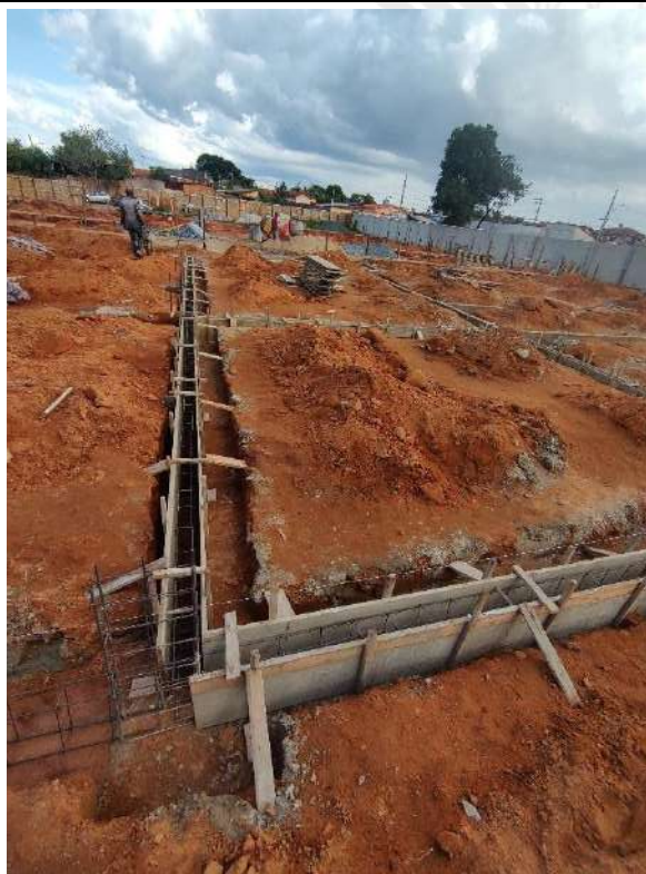
Foto 95 – Execução de forma das cintas de fundação
