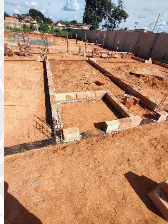
Foto 194 – impermeabilização das cintas e assentamento de alvenaria
