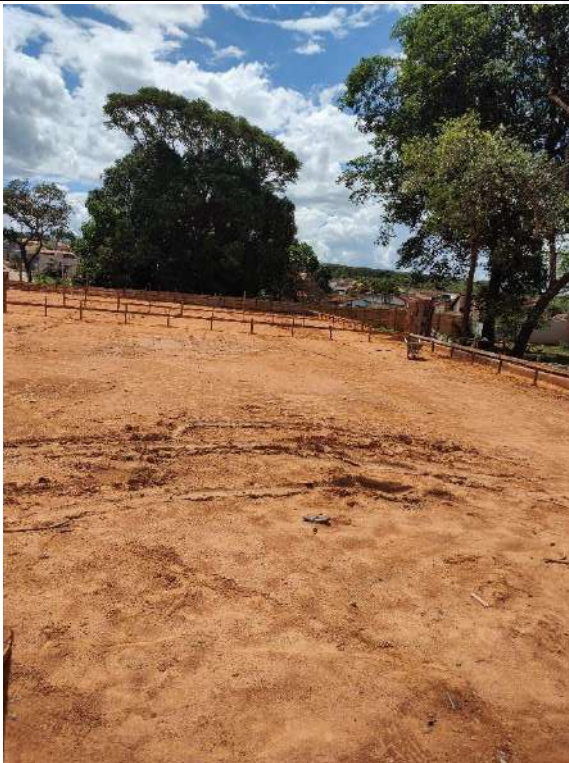
Foto 1 – Execução de gabarito para locação de obra
