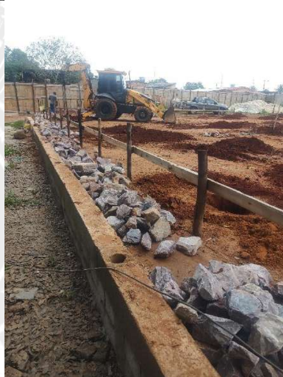
Foto 26 – Execução de estacas de fundação
