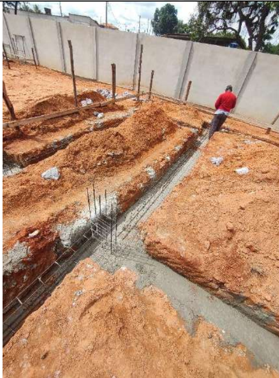
Foto 63 – Instalação das armaduras das cintas de fundação
