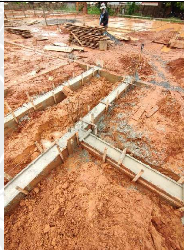
Foto 140 – Forma e concretagem das cintas de fundação
