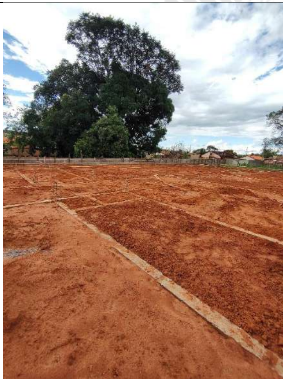
Foto 135 – Acerto compactado de terreno
