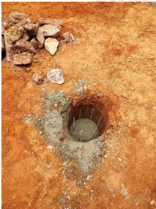
Foto 17 - Execução de estacas de fundação
