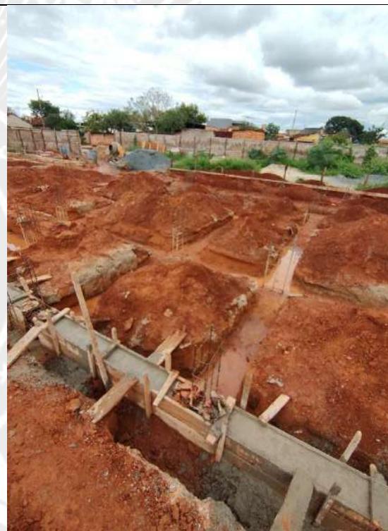
Foto 128 – Forma e concretagem das cintas de fundação
