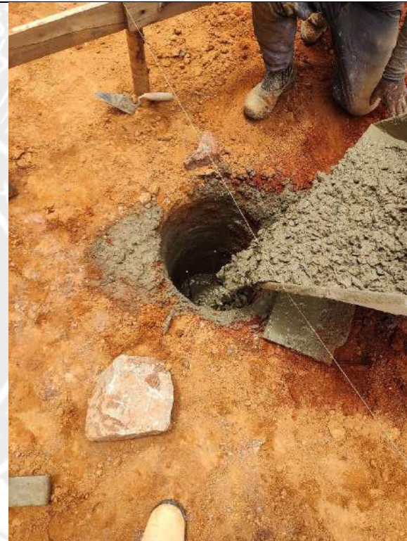
Foto 20 – Execução de estacas de fundação
