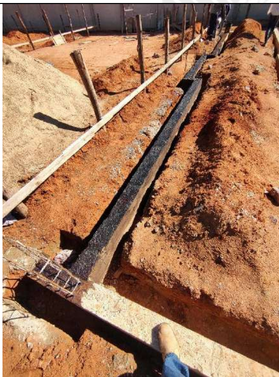
Foto 113 – Impermeabilização das cintas de fundação
