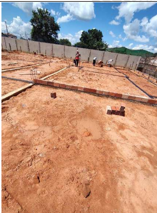
Foto 173 – impermeabilização das cintas e assentamento de alvenaria
