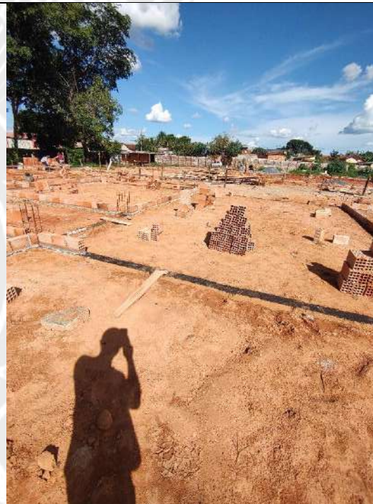
Foto 190 – impermeabilização das cintas e assentamento de alvenaria
