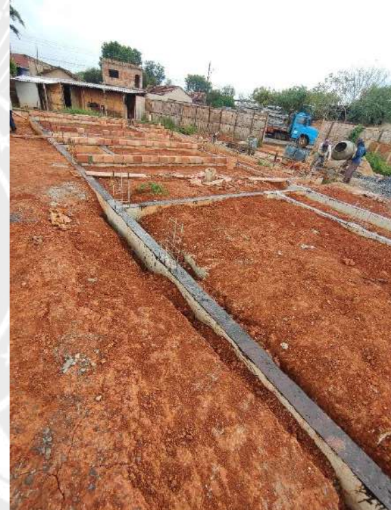
Foto 206 – impermeabilização das cintas e acerto compactado de terreno
