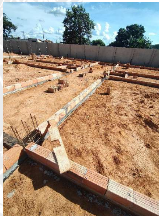
Foto 192 – impermeabilização das cintas e assentamento de alvenaria
