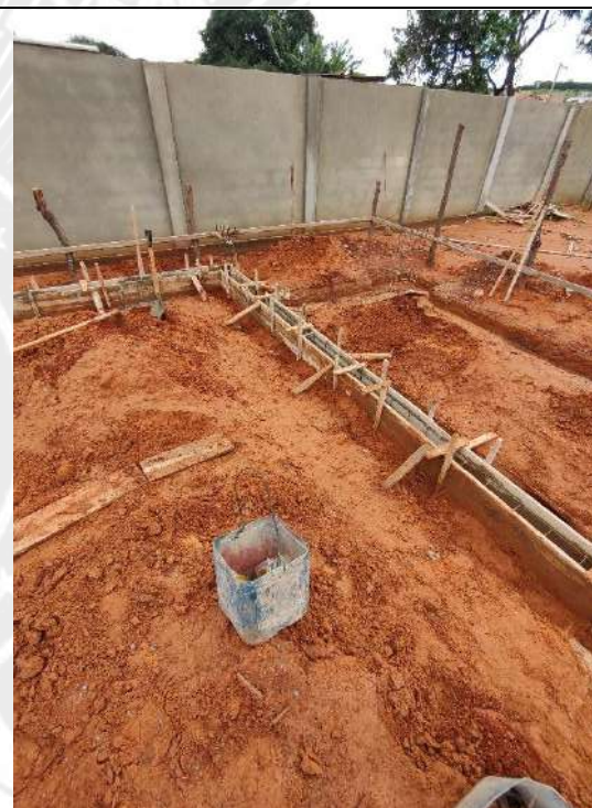
Foto 124 – Forma e concretagem das cintas de fundação
