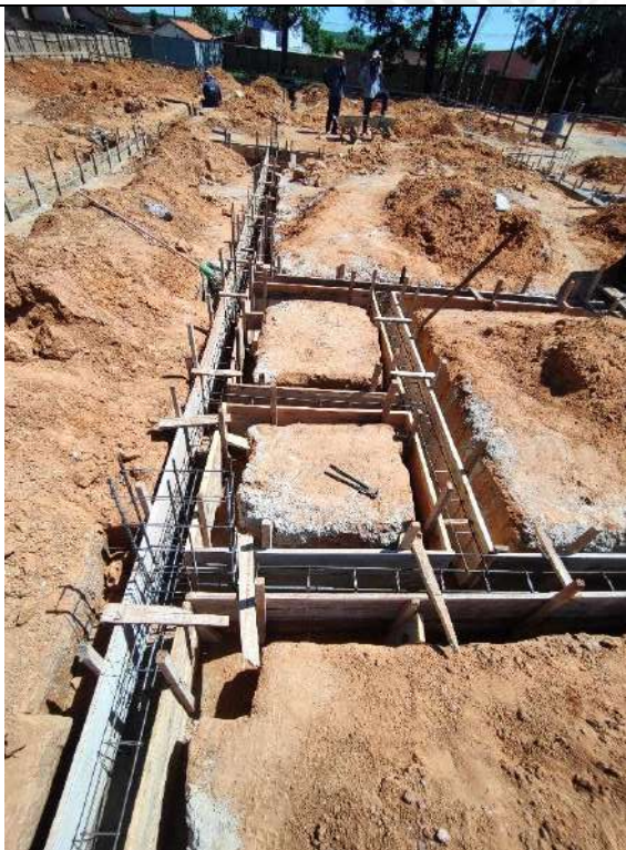
Foto 87 – Execução de forma e concretagem das cintas de fundação
