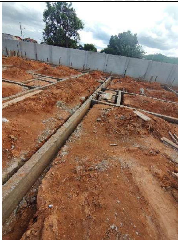
Foto 97 – Desforma das cintas de fundação
