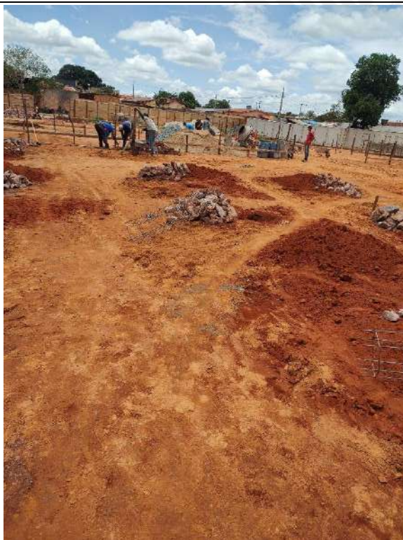
Foto 19 – Execução de estacas de fundação
