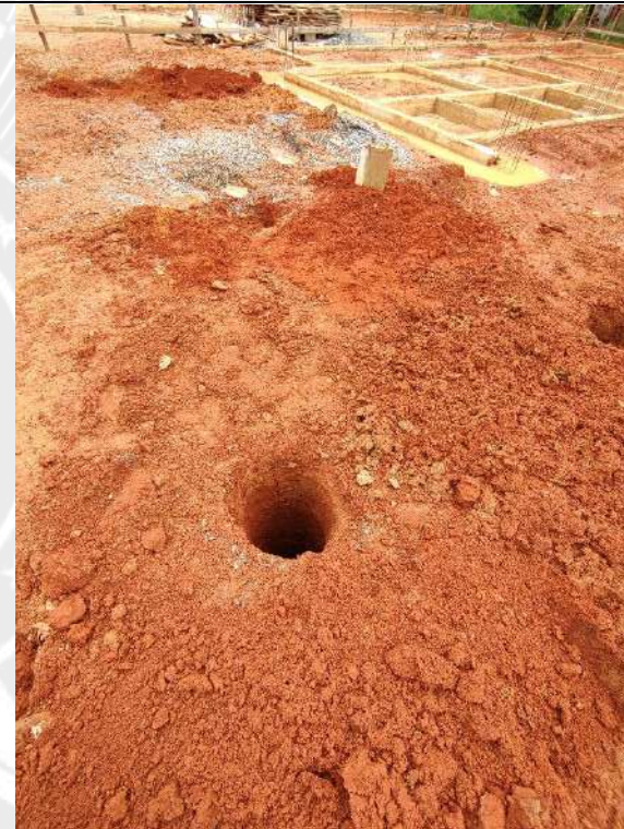
Foto 156 – Perfuração de estacas de fundação
