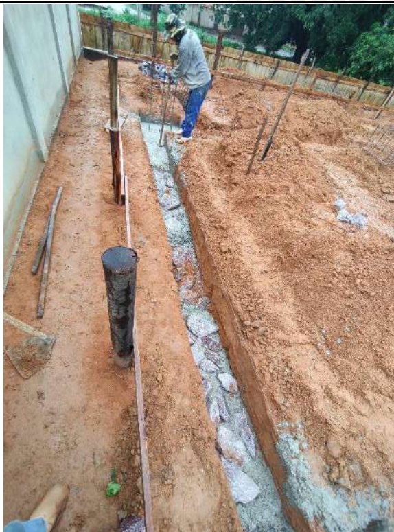
Foto 53 – Concretagem de blocos, pilares e fundo de vala das cintas de fundação
