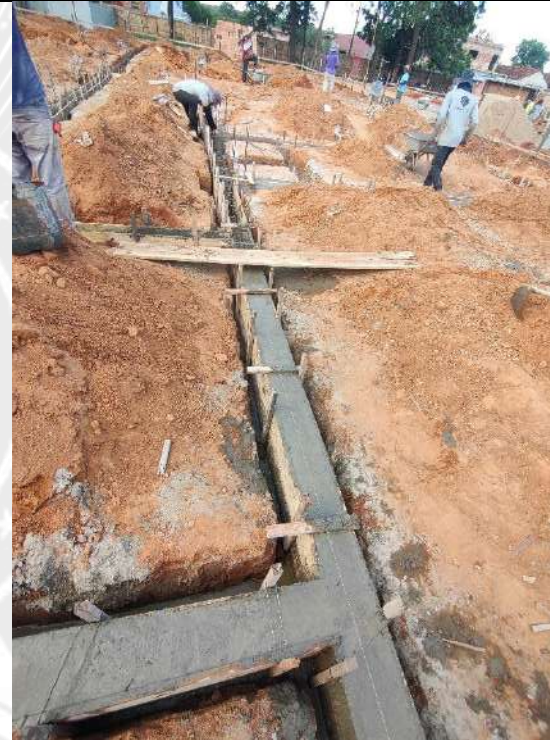
Foto 82 – Execução de forma e concretagem das cintas de fundação
