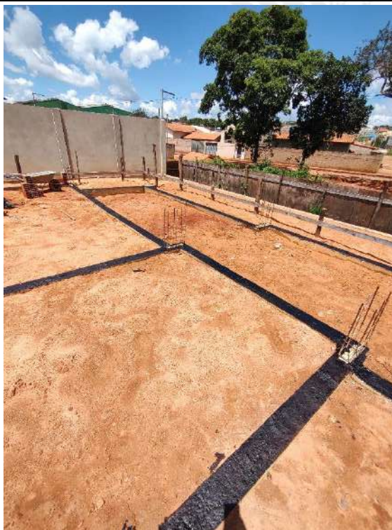
Foto 175 – impermeabilização das cintas e assentamento de alvenaria
