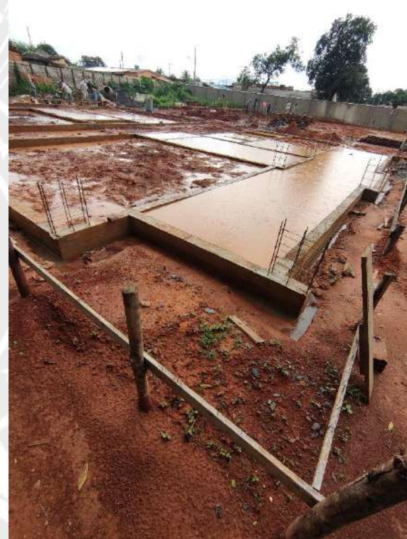
Foto 152 – Bombeamento de água de chuva
