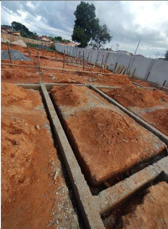
Foto 99 – Desforma das cintas de fundação
