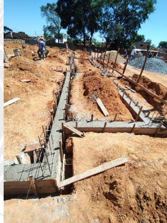
Foto 84 – Execução de forma e concretagem das cintas de fundação
