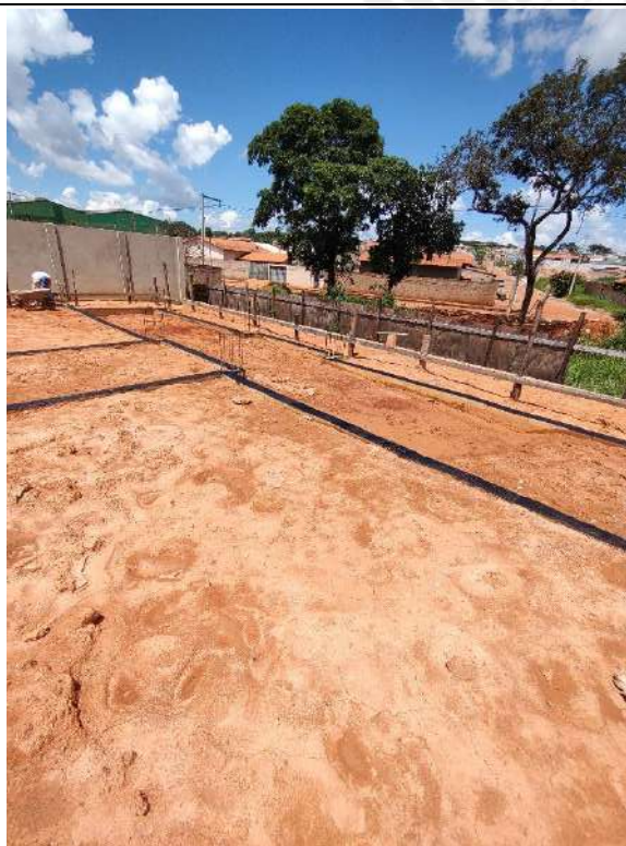
Foto 169 – impermeabilização das cintas e assentamento de alvenaria
