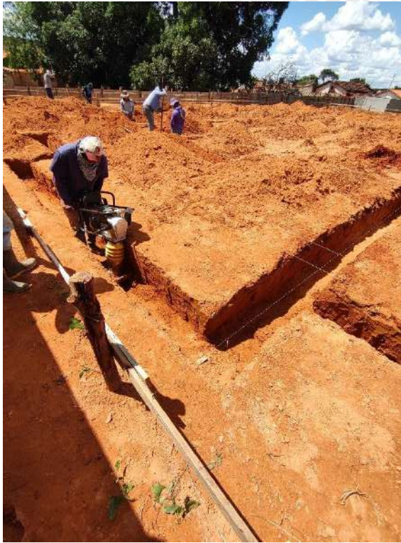
Foto 39 – Compactação de valas das cintas de fundação
