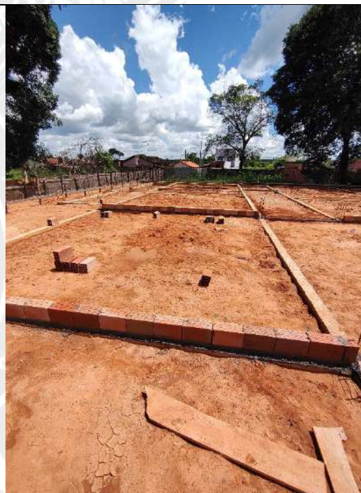
Foto 166 – impermeabilização das cintas e acerto compactado de terreno
