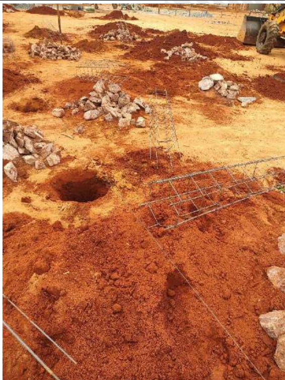
Foto 25 – Execução de estacas de fundação
