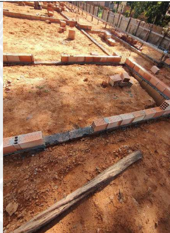
Foto 182 – impermeabilização das cintas e assentamento de alvenaria
