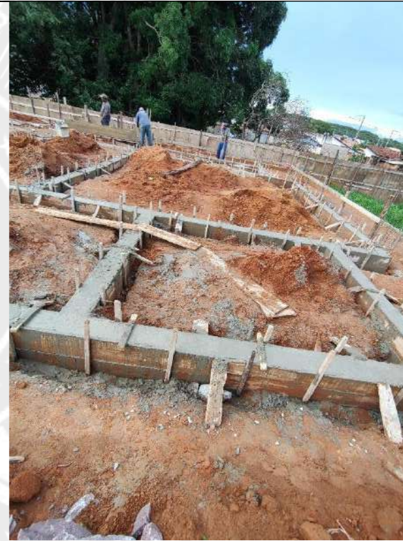
Foto 108 – Forma e concretagem das cintas de fundação
