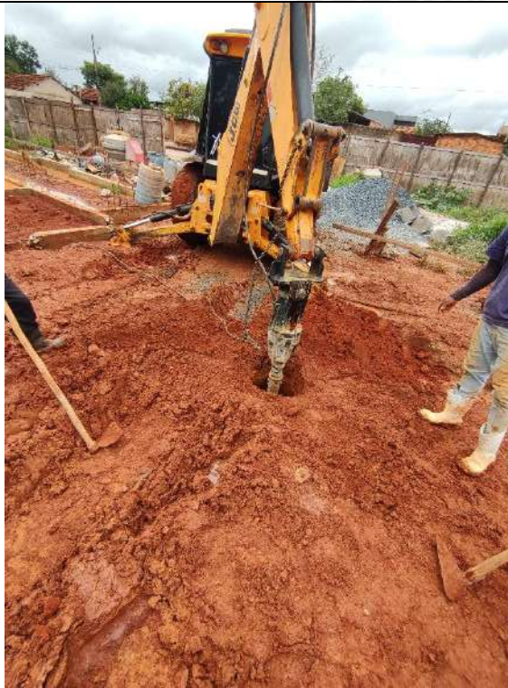
Foto 155 – Perfuração de estacas de fundação
