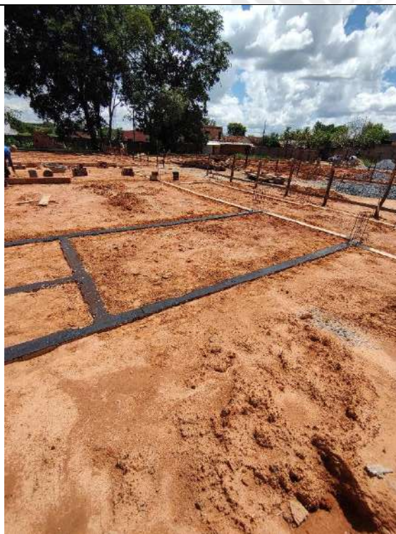
Foto 163 – impermeabilização das cintas e acerto compactado de terreno
