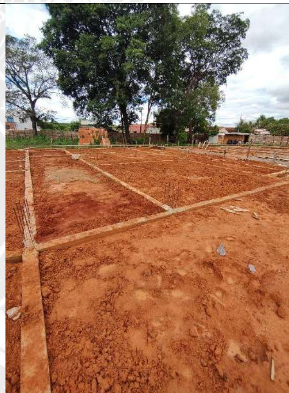
Foto 138 – Acerto compactado de terreno
