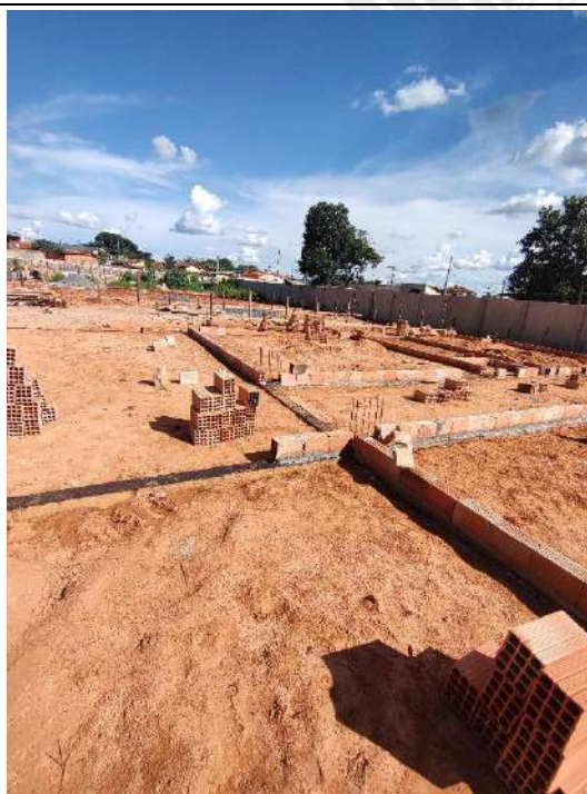
Foto 189 – impermeabilização das cintas e assentamento de alvenaria
