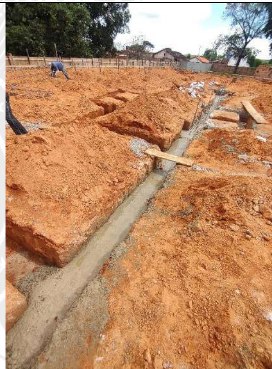
Foto 66 – Concretagem de fundo de vala das cintas de fundação
