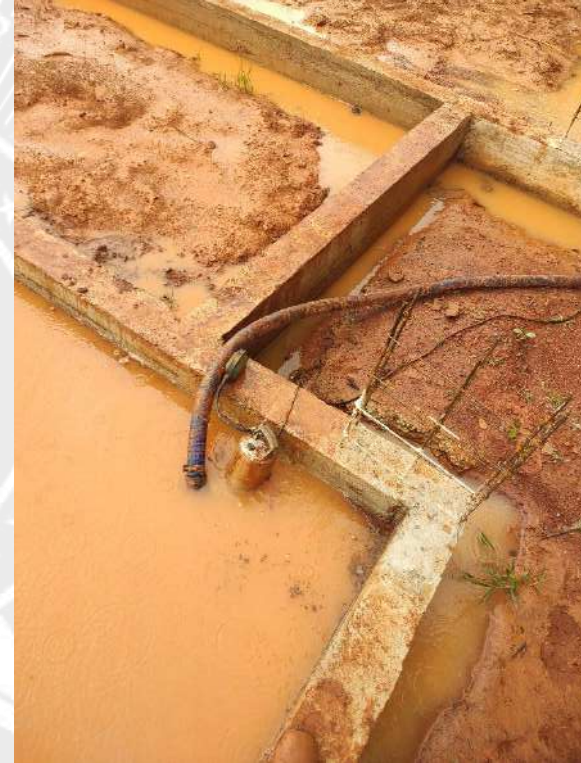
Foto 150 – Bombeamento de água de chuva
