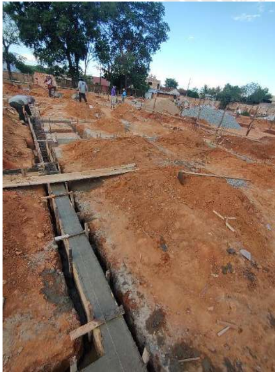
Foto 83 – Execução de forma e concretagem das cintas de fundação
