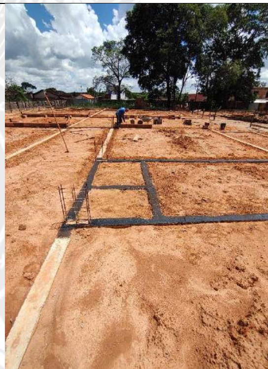
Foto 164 – impermeabilização das cintas e acerto compactado de terreno
