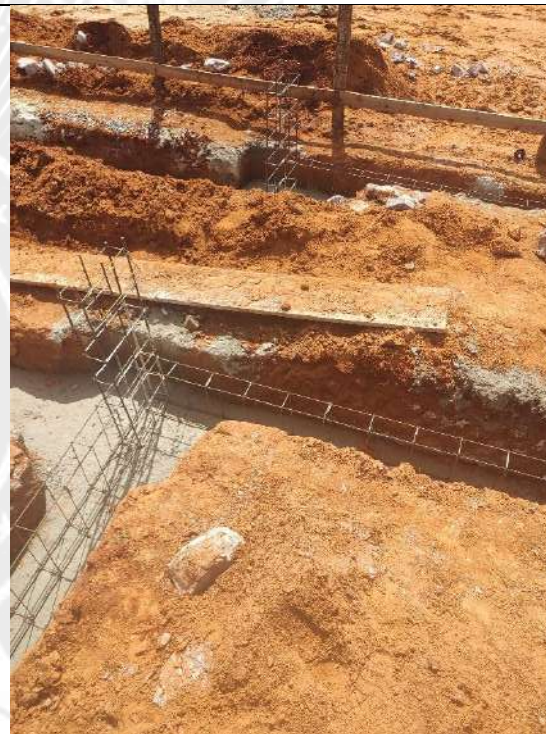
Foto 62 – Instalação das armaduras das cintas de fundação
