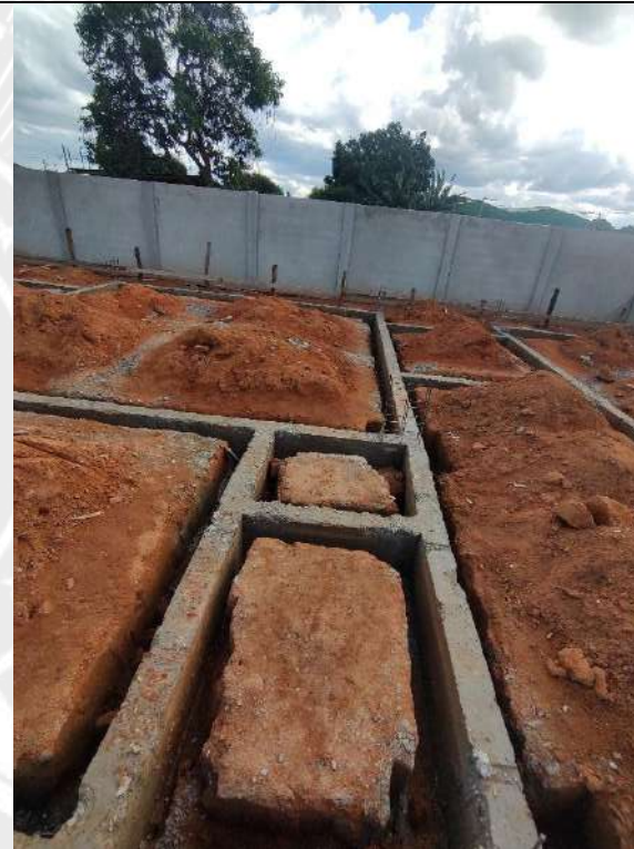
Foto 100 – Desforma das cintas de fundação
