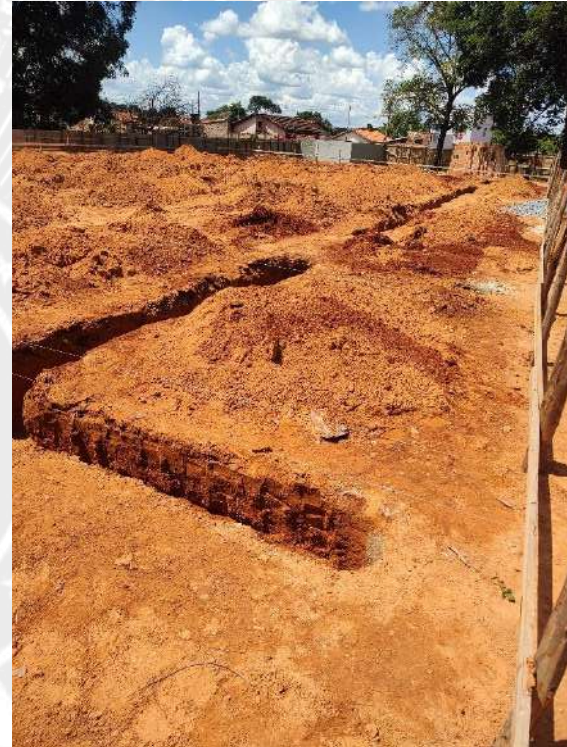
Foto 36 - Escavação de valas das cintas de fundação
