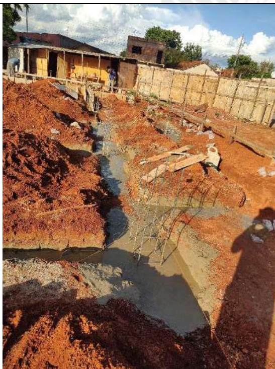
Foto 123 – Forma e concretagem das cintas de fundação
