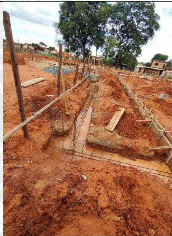
Foto 132 – Forma e concretagem das cintas de fundação
