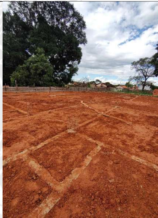
Foto 136 – Acerto compactado de terreno
