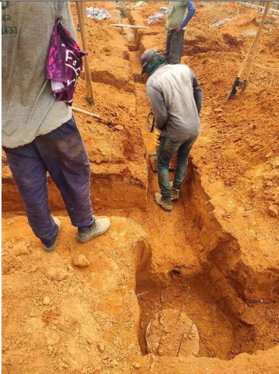
Foto 91 – Compactação de fundo de vala das cintas de fundação
