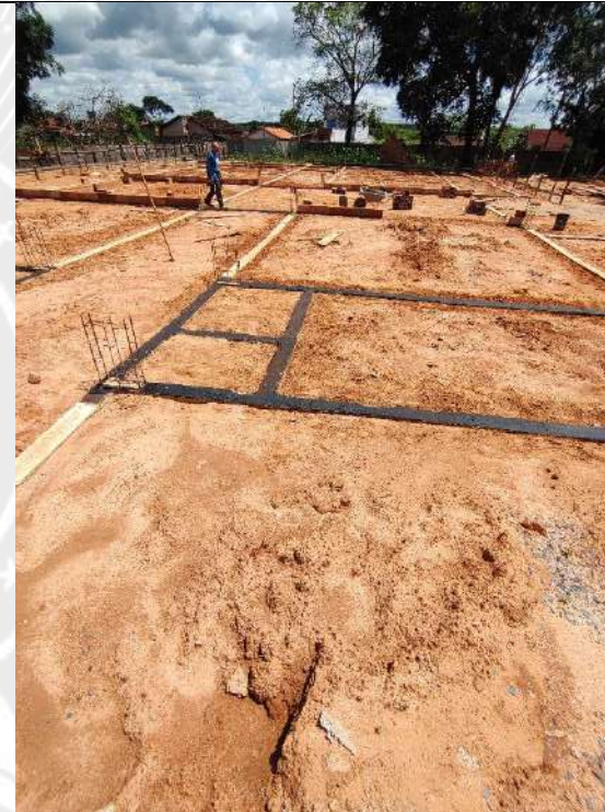
Foto 158 – impermeabilização das cintas e acerto compactado de terreno
