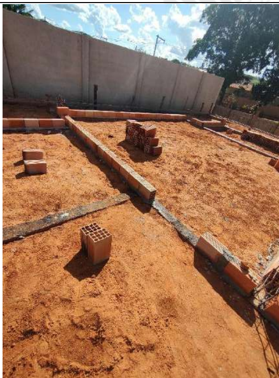
Foto 195 – impermeabilização das cintas e acerto compactado de terreno
