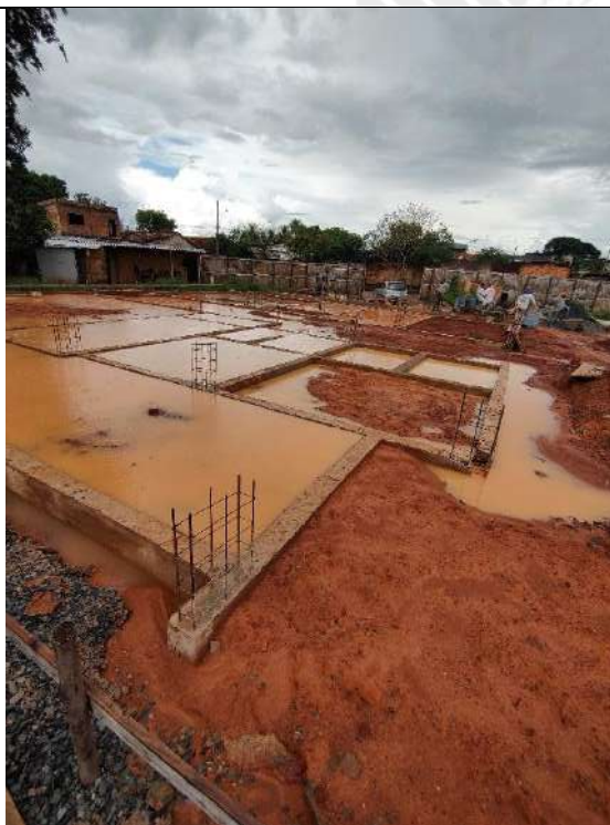
Foto 145 – Bombeamento de água de chuva
