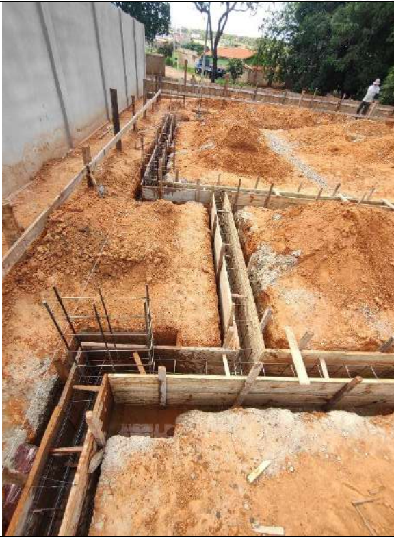
Foto 73 – Execução de forma das cintas de fundação
