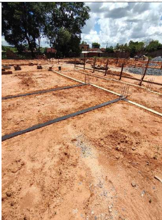
Foto 159 – impermeabilização das cintas e acerto compactado de terreno
