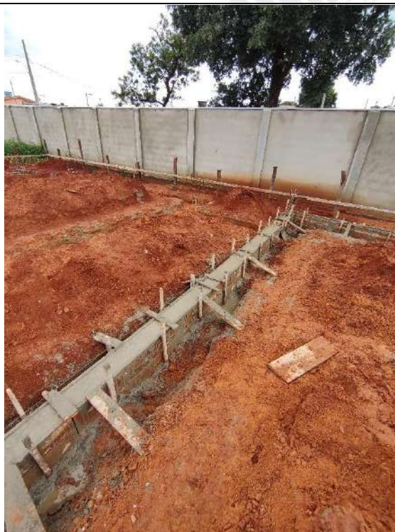
Foto 129 – Forma e concretagem das cintas de fundação
