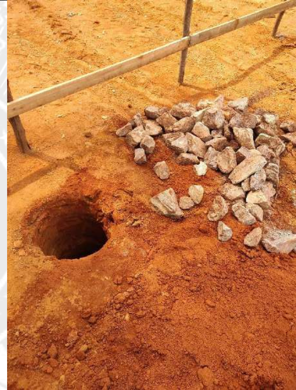
Foto 16 – Execução de estacas de fundação
