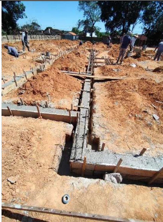
Foto 85 – Execução de forma e concretagem das cintas de fundação
