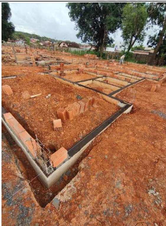
Foto 207 – impermeabilização das cintas e acerto compactado de terreno
