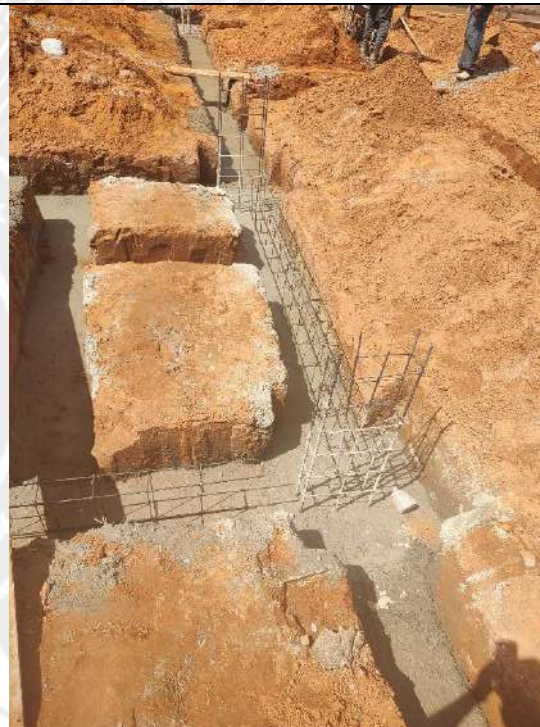
Foto 60 – Instalação das armaduras das cintas de fundação
