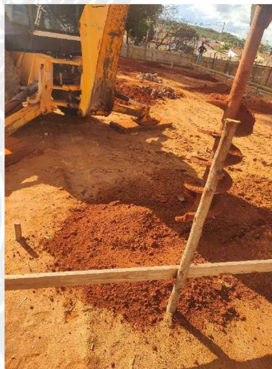
Foto 10 – Perfuração de estacas de fundação
