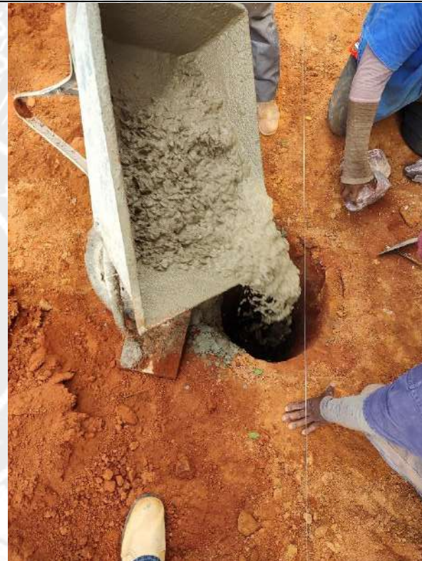
Foto 14 – Concretagem das estacas de fundação
