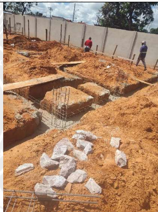
Foto 58 – Concretagem de blocos, pilares e fundo de vala das cintas de fundação
