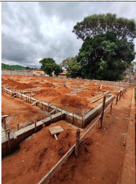
Foto 117 – Forma e concretagem das cintas de fundação
