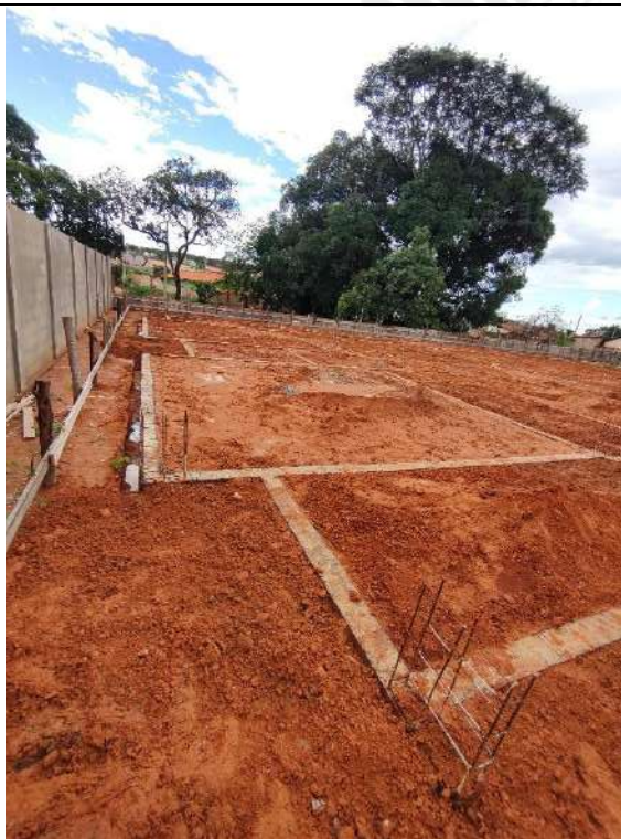
Foto 133 – Acerto compactado de terreno
