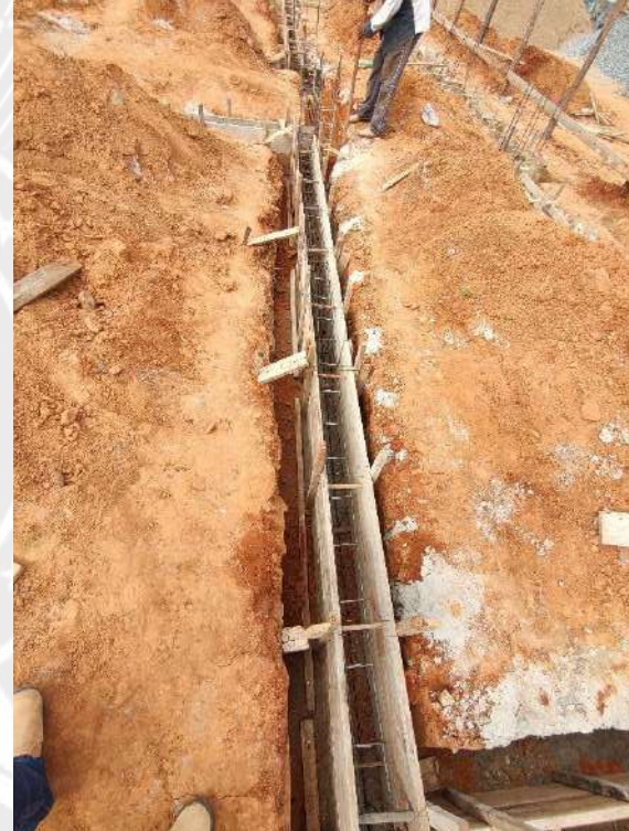
Foto 72 – Execução de forma das cintas de fundação
