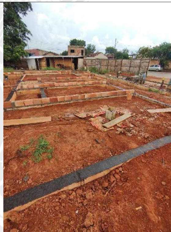
Foto 210 – impermeabilização das cintas e acerto compactado de terreno
