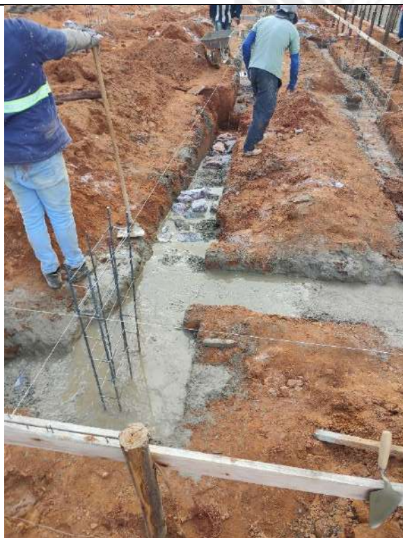
Foto 93 – Concretagem de blocos, pilares e fundo de vala das cintas de fundação
