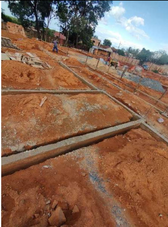
Foto 101 – Desforma das cintas de fundação
