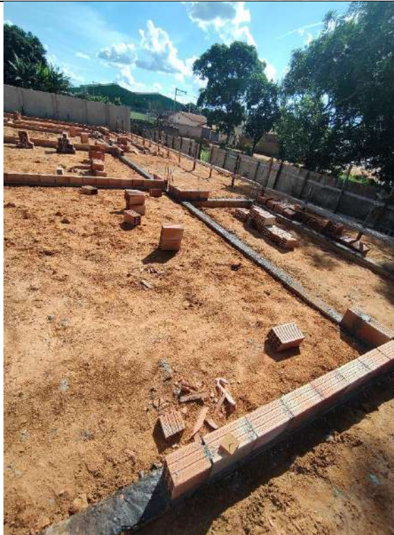
Foto 185 – impermeabilização das cintas e assentamento de alvenaria
