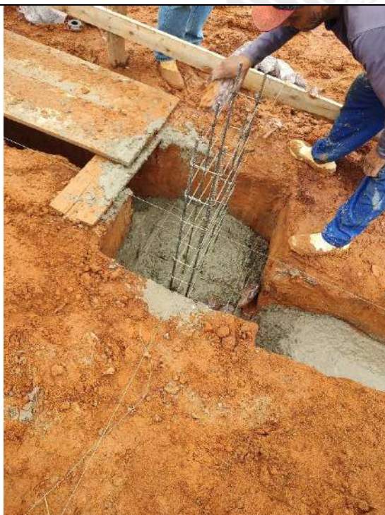
Foto 57 – Concretagem de blocos, pilares e fundo de vala das cintas de fundação
