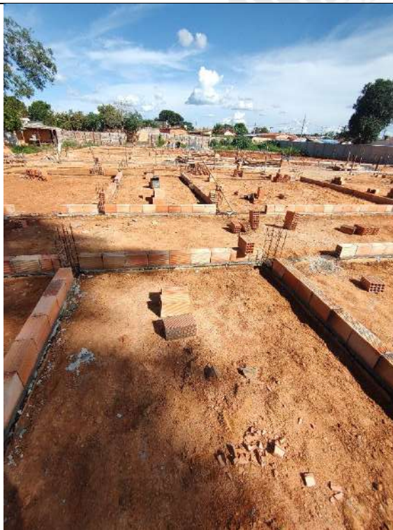
Foto 183 – impermeabilização das cintas e assentamento de alvenaria
