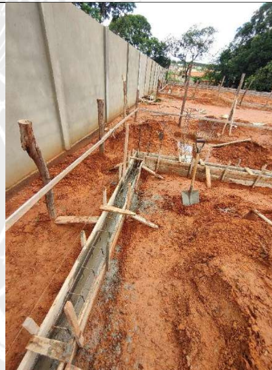
Foto 130 – Forma e concretagem das cintas de fundação
