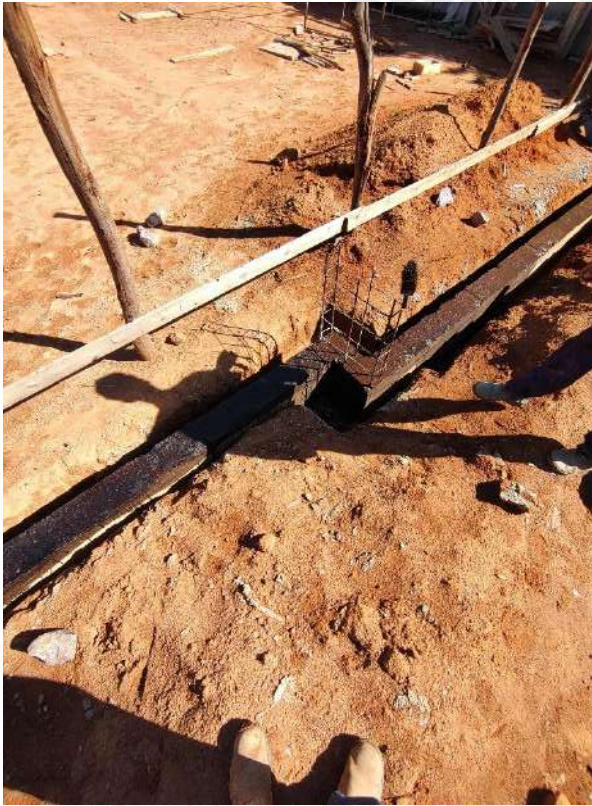
Foto 111 – Impermeabilização das cintas de fundação
