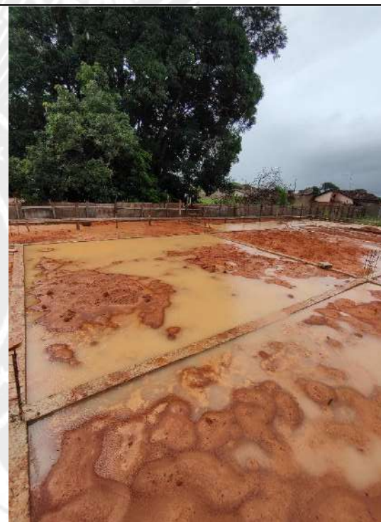
Foto 146 – Bombeamento de água de chuva
