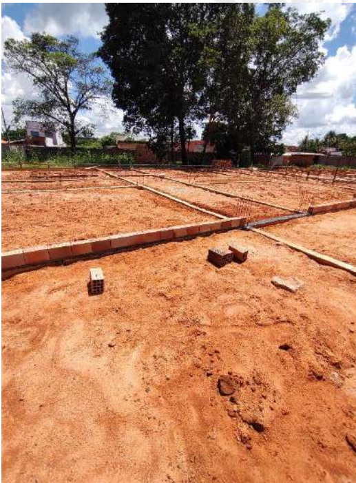
Foto 171 – impermeabilização das cintas e assentamento de alvenaria
