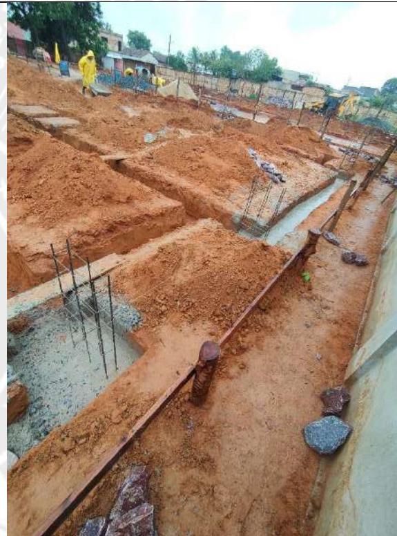
Foto 54 – Concretagem de blocos, pilares e fundo de vala das cintas de fundação
