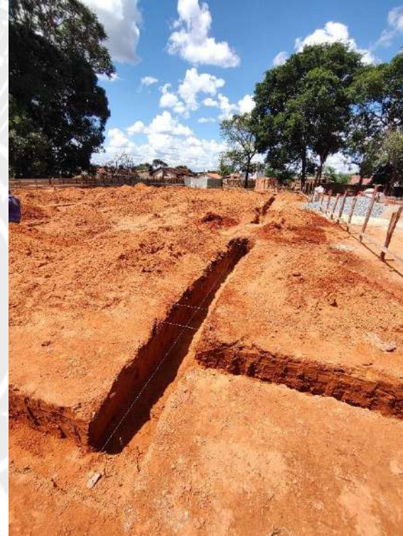
Foto 38 - Escavação de valas das cintas de fundação
