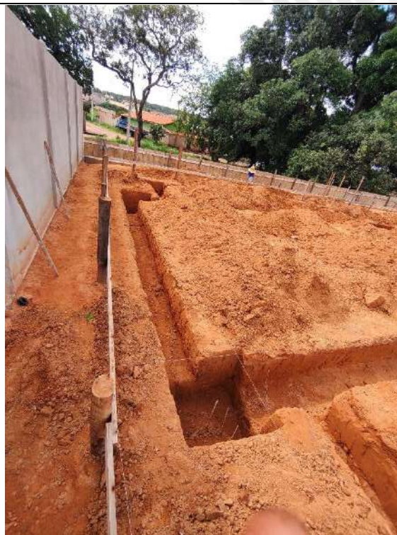
Foto 45 - Escavação de valas das cintas e dos blocos de fundação
