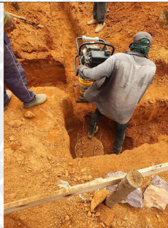
Foto 90 – Compactação de fundo de vala das cintas de fundação
