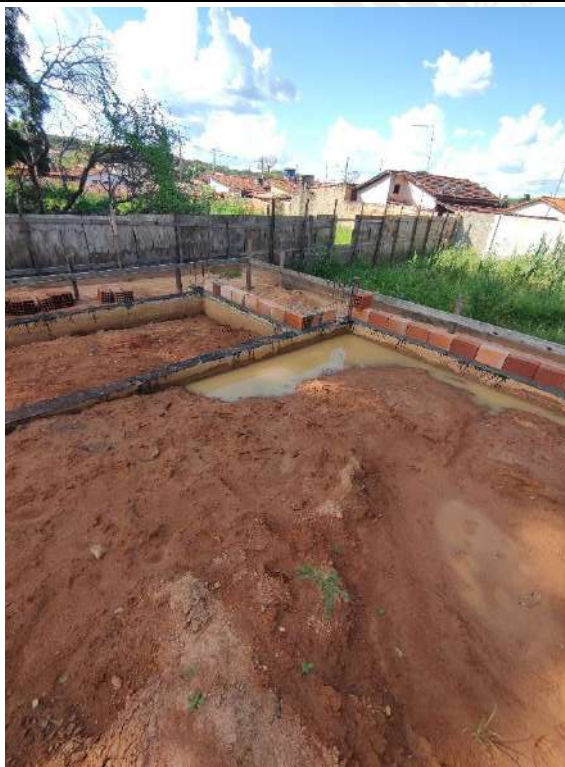
Foto 181 – impermeabilização das cintas e assentamento de alvenaria
