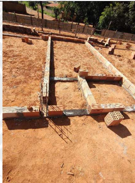
Foto 196 – impermeabilização das cintas e acerto compactado de terreno
