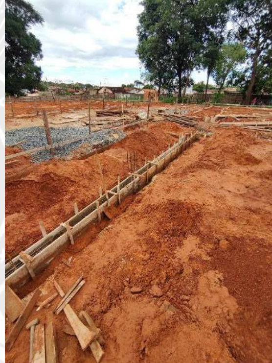
Foto 126 – Forma e concretagem das cintas de fundação
