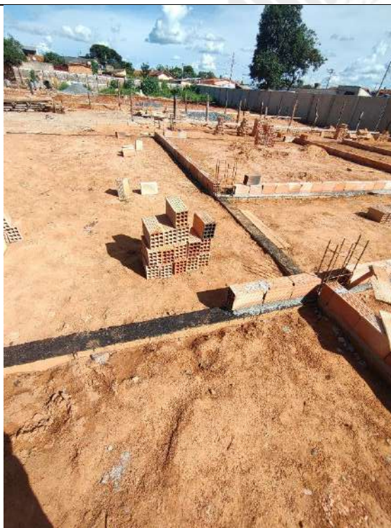
Foto 191 – impermeabilização das cintas e assentamento de alvenaria
