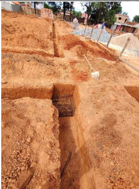
Foto 47 - Escavação de valas das cintas e dos blocos de fundação
