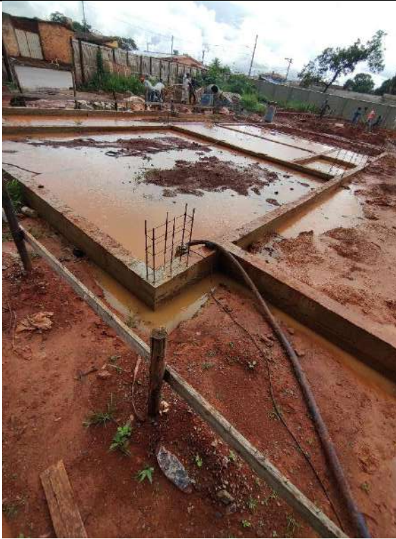
Foto 153 – Bombeamento de água de chuva
