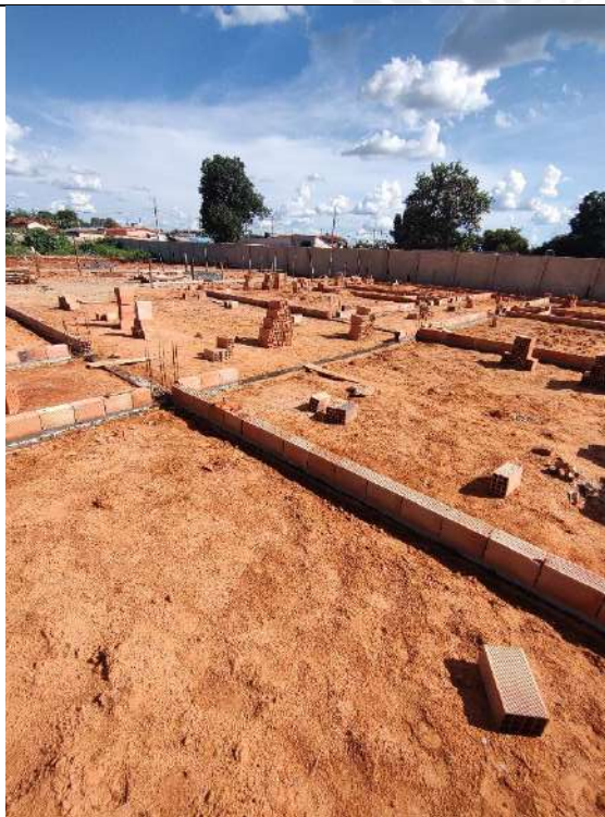
Foto 187 – impermeabilização das cintas e assentamento de alvenaria
