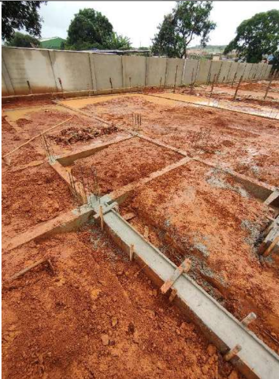
Foto 141 – Forma e concretagem das cintas de fundação
