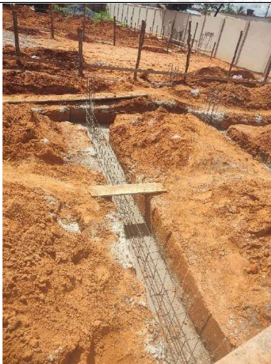
Foto 61 – Instalação das armaduras das cintas de fundação
