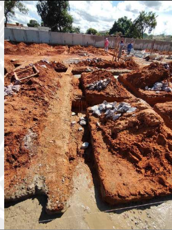
Foto 122 – Forma e concretagem das cintas de fundação
