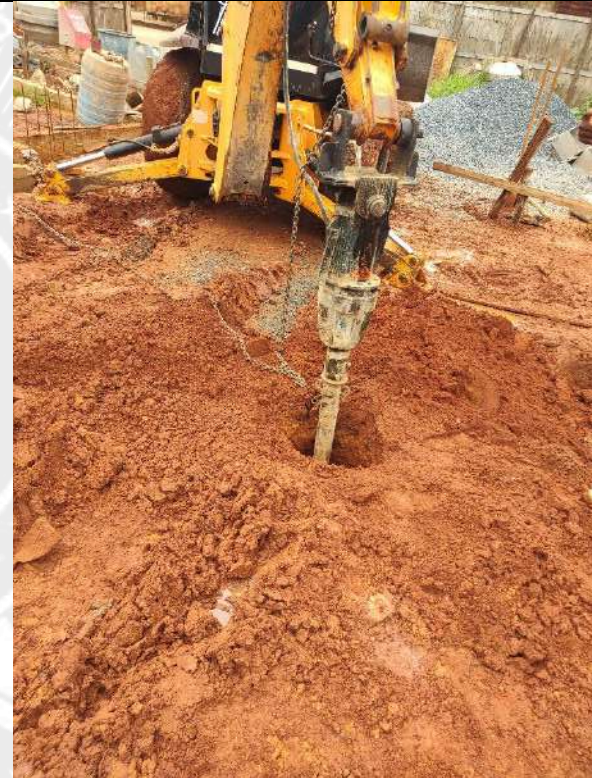
Foto 154 – Perfuração de estacas de fundação
