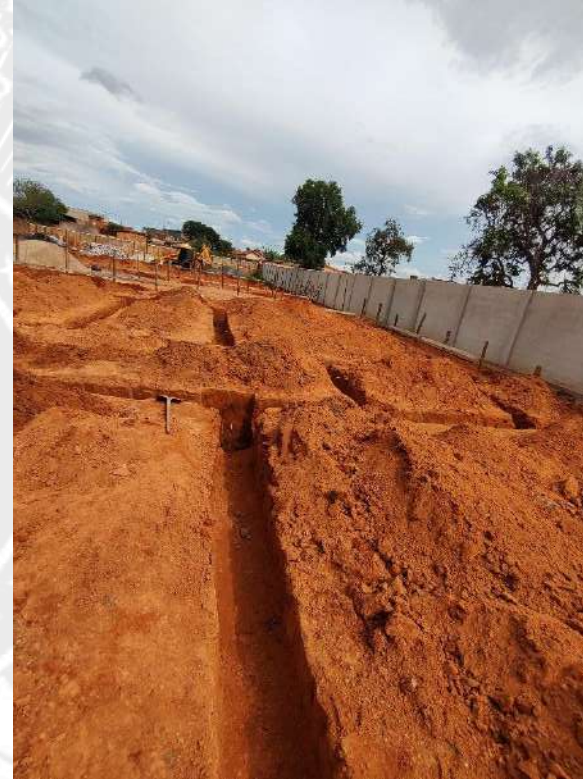
Foto 40 – Compactação de valas das cintas de fundação
