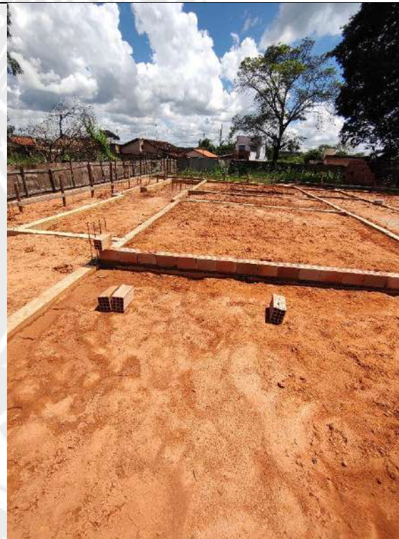
Foto 170 – impermeabilização das cintas e assentamento de alvenaria
