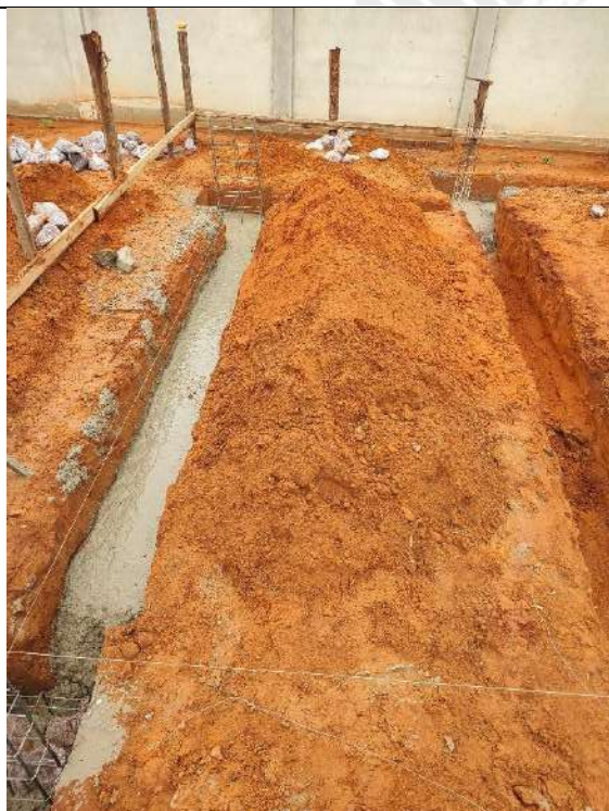
Foto 55 – Concretagem de blocos, pilares e fundo de vala das cintas de fundação
