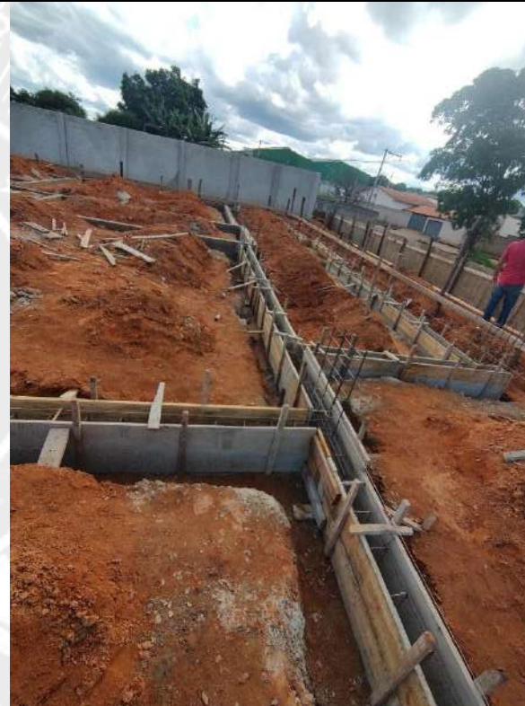
Foto 96 – Execução de forma das cintas de fundação
