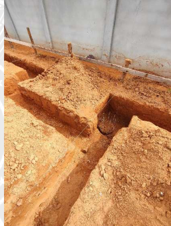
Foto 44 – Escavação de valas das cintas e dos blocos de fundação
