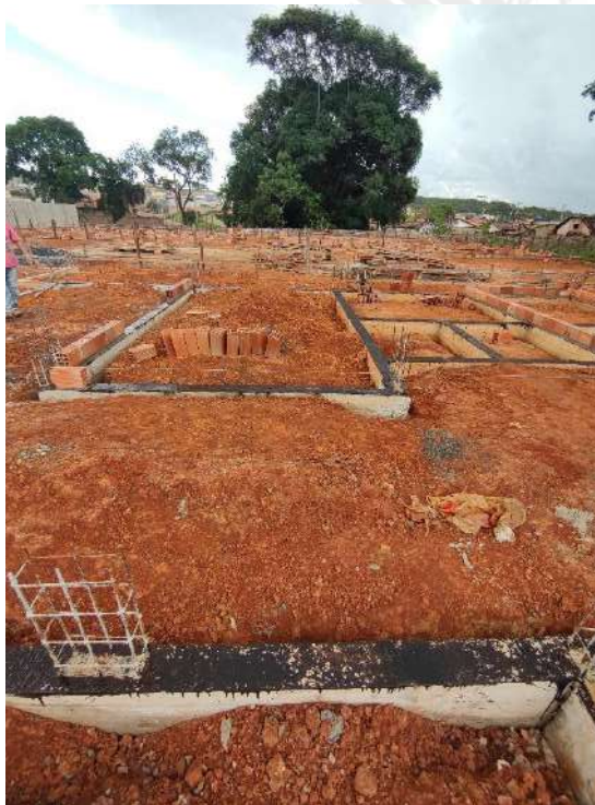
Foto 211 – impermeabilização das cintas e assentamento de alvenaria
