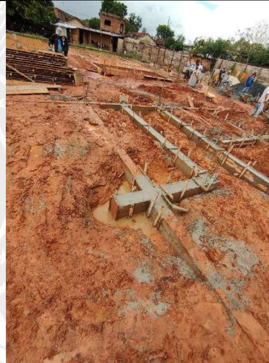
Foto 144 – Forma e concretagem de cintas de fundação
