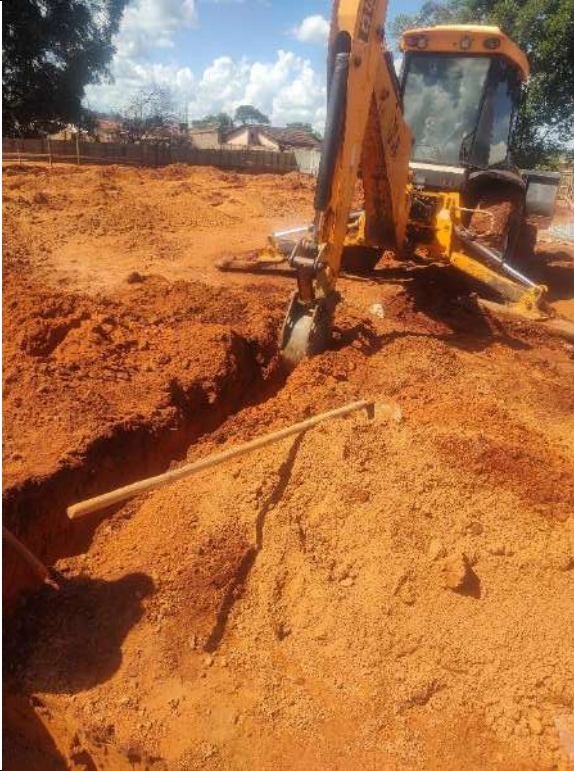
Foto 29 – Escavação de valas das cintas de fundação
