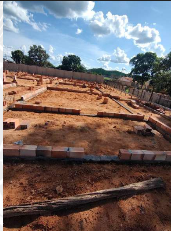
Foto 176 – impermeabilização das cintas e assentamento de alvenaria
