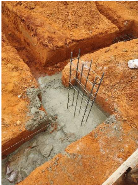
Foto 49 – Concretagem de blocos, pilares e fundo de vala das cintas de fundação
