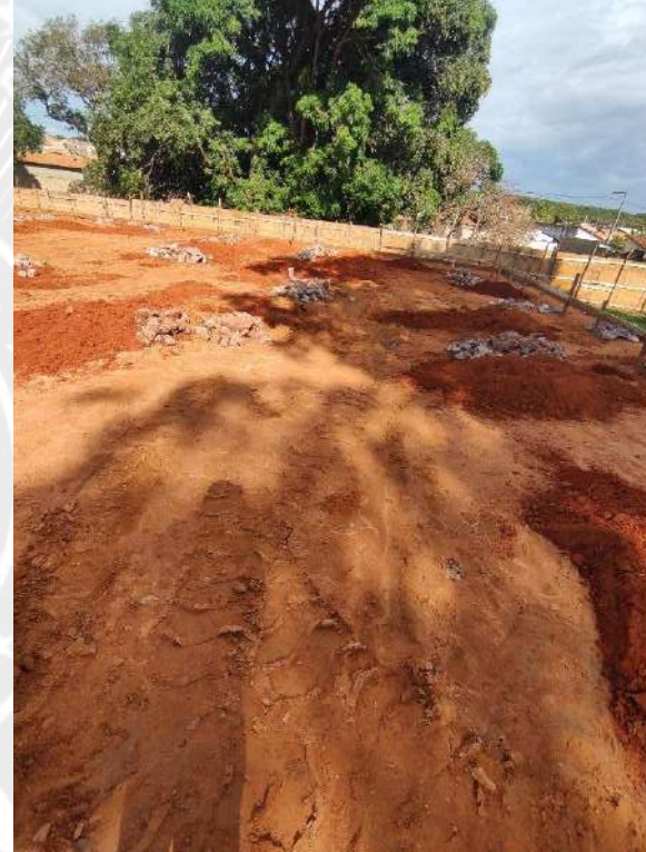
Foto 12 – Perfuração de estacas de fundação
