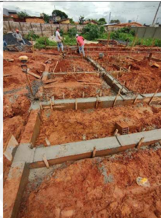
Foto 148 – Forma e concretagem de cintas de fundação
