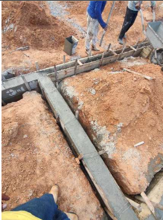
Foto 81 – Execução de forma e concretagem das cintas de fundação
