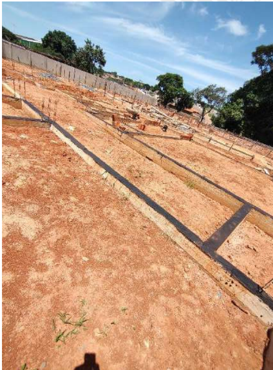
Foto 201 – impermeabilização das cintas e acerto compactado de terreno
