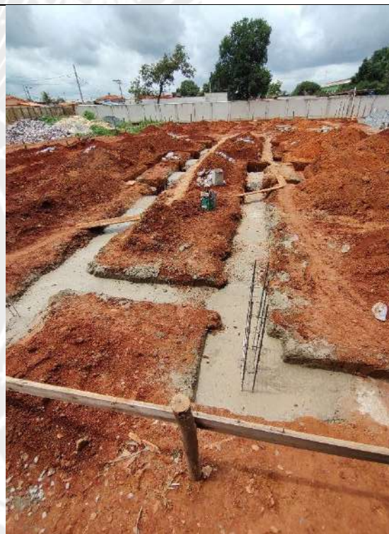
Foto 114 – Concretagem de pilares, blocos e fundo de vala das cintas
