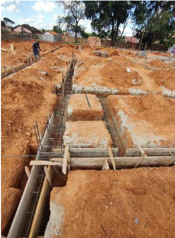
Foto 75 – Execução de forma das cintas de fundação
