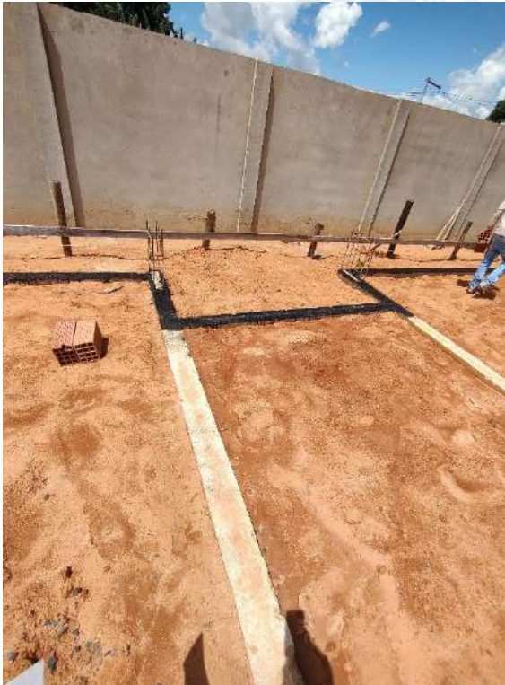
Foto 161 – impermeabilização das cintas e acerto compactado de terreno
