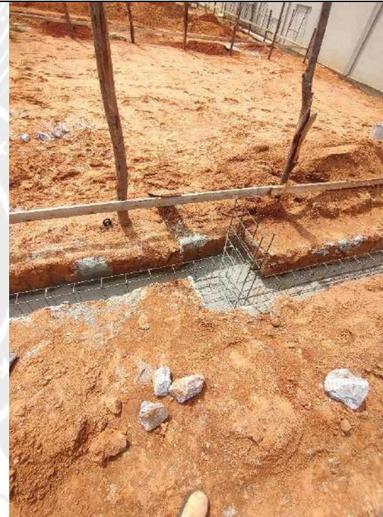
Foto 64 – Instalação das armaduras das cintas de fundação
