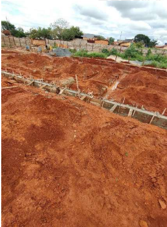
Foto 125 – Forma e concretagem das cintas de fundação
