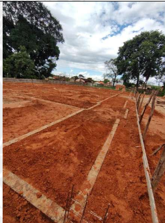
Foto 134 – Acerto compactado de terreno
