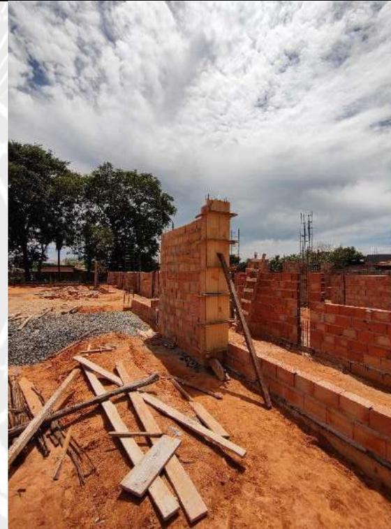
Foto 100 – Execução de forma e concretagem de pilares
