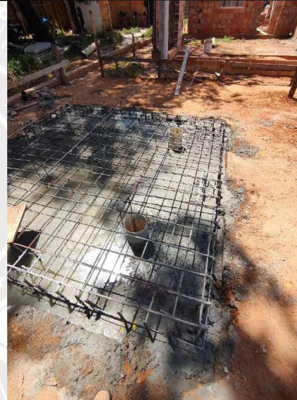
Foto 140 – Concretagem bloco de fundação caixa d'água
