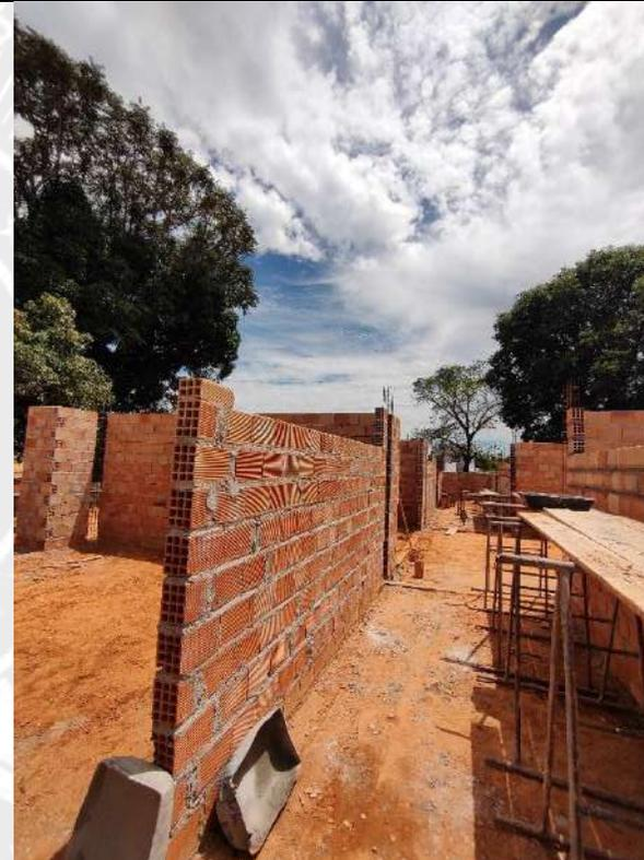
Foto 106 – Execução de alvenaria e armação de pilares
