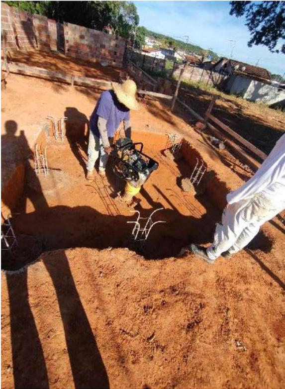
Foto 23 - Execução de bloco de fundação da caixa d'água
