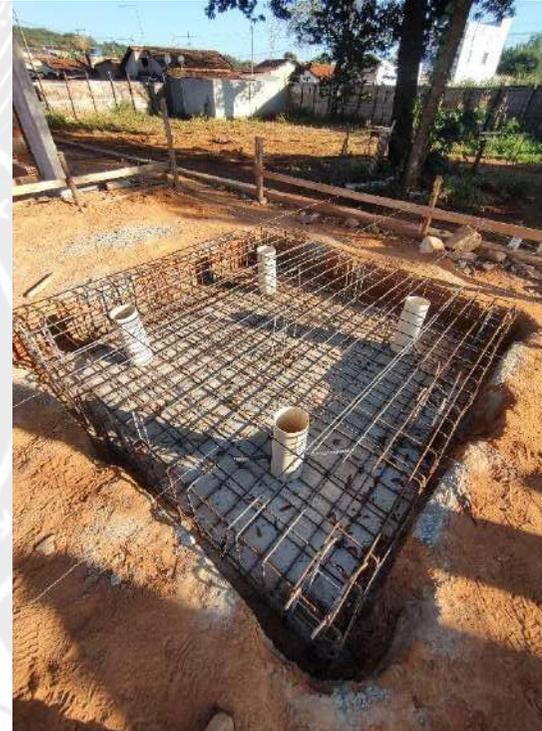
Foto 132 – Armação fundação caixa d'água
