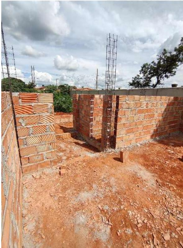
Foto 83 – Execução de alvenaria e armação de pilares
