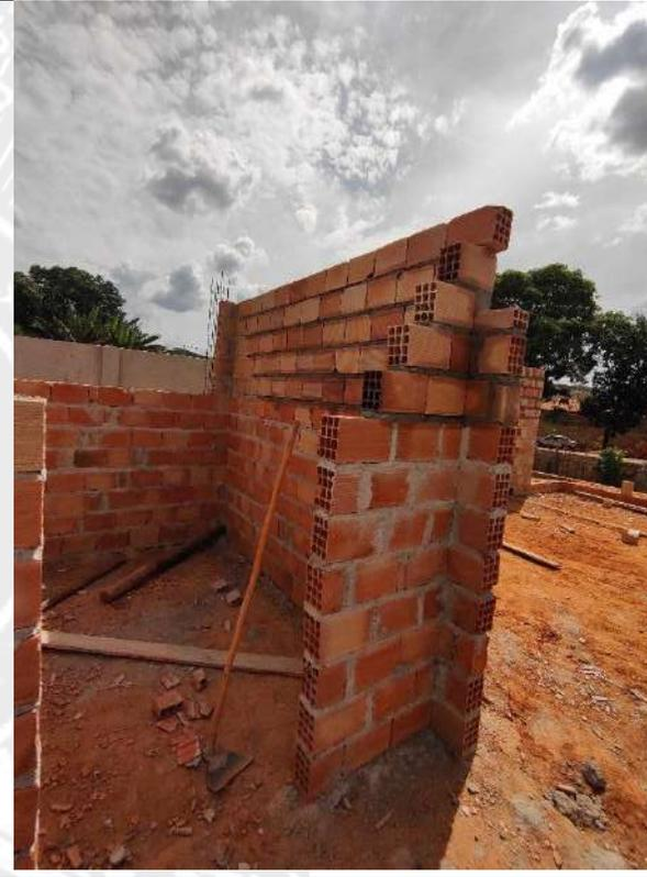
Foto 48 - Execução de alvenaria e armação de pilares
