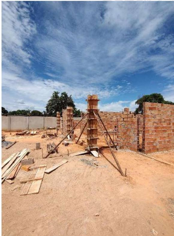
Foto 97 – Execução de forma e concretagem de pilares
