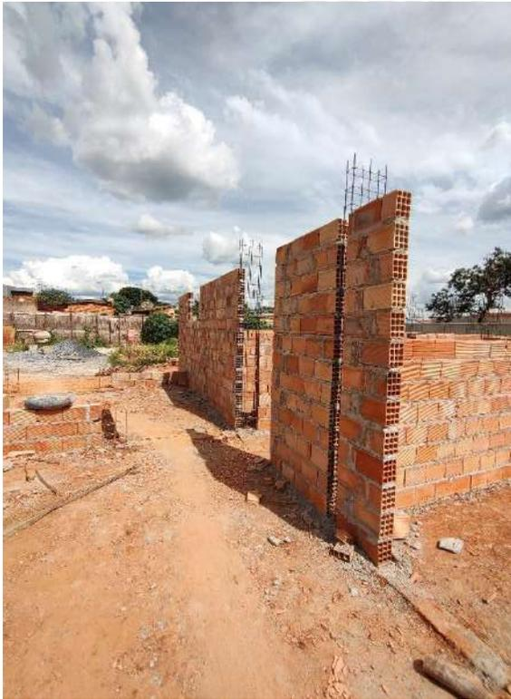
Foto 77 – Execução de alvenaria e armação de pilares
