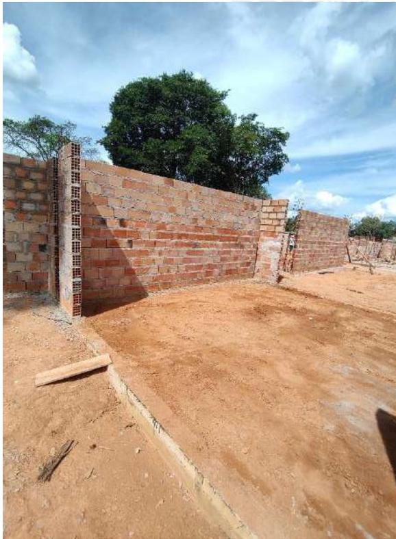
Foto 59 – Execução de alvenaria e armação de pilares
