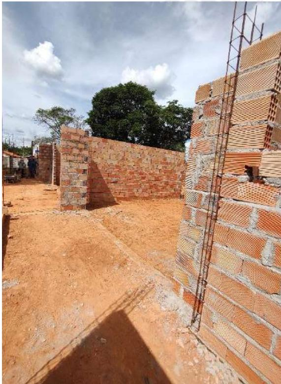
**Foto 57 – Execução de alvenaria e armação de pilares**
