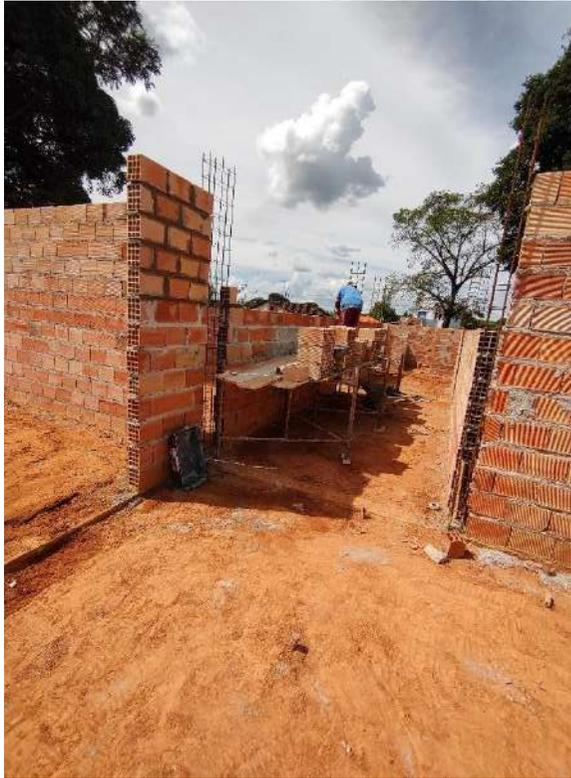
Foto 41 – Execução de alvenaria e armação de pilares
