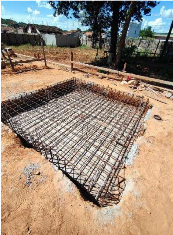
Foto 111 – Armação bloco de fundação caixa d'água
