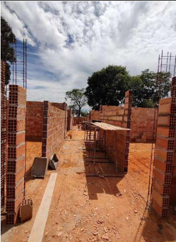
Foto 105 – Execução de alvenaria e armação de pilares
