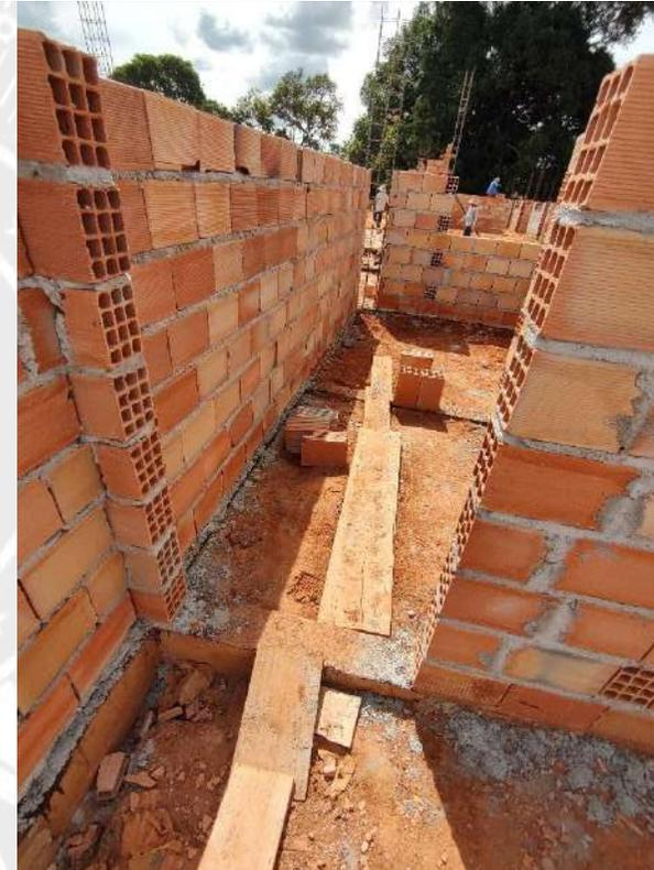
Foto 86 – Execução de alvenaria e armação de pilares
