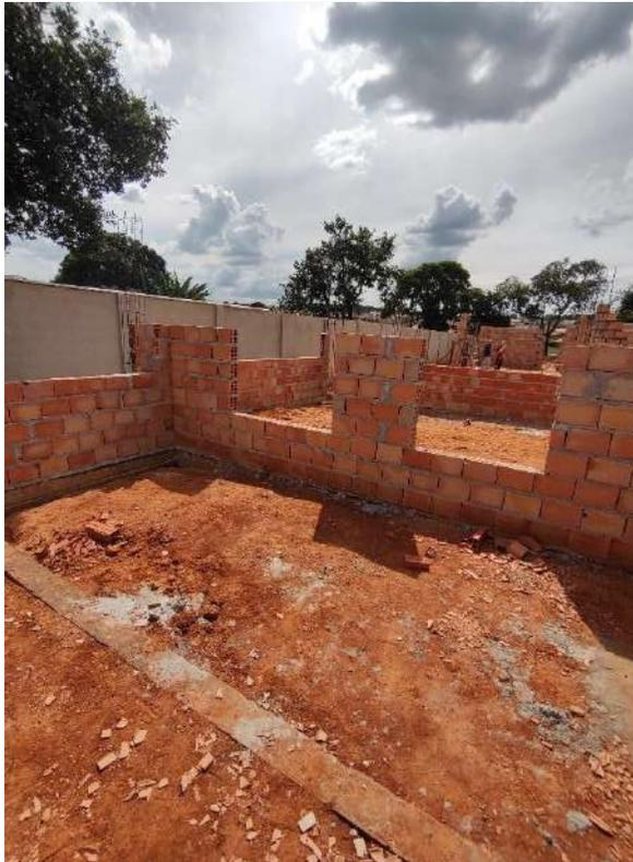
Foto 85 – Execução de alvenaria e armação de pilares
