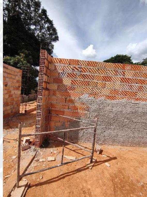
Foto 54 – Execução de alvenaria, chapisco e armação de pilares
