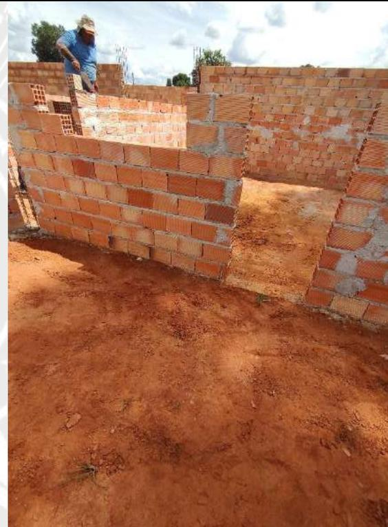
**Foto 64 – Execução de alvenaria e armação de pilares**
