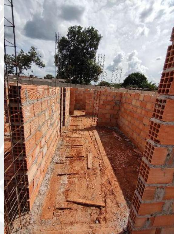
Foto 78 – Execução de alvenaria e armação de pilares
