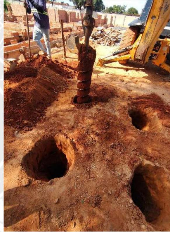
Foto 16 - Perfuração de estacas de fundação da caixa d'água
