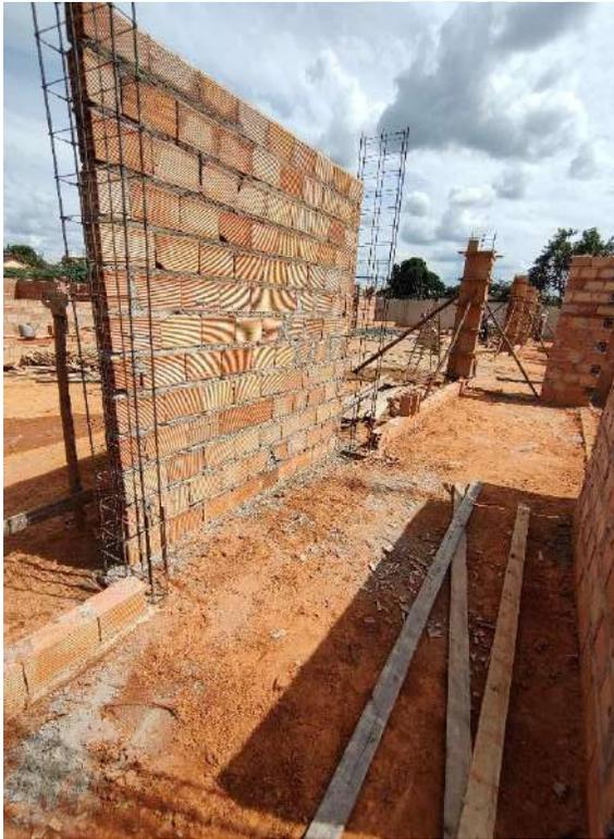
Foto 71 – Execução de alvenaria e armação de pilares
