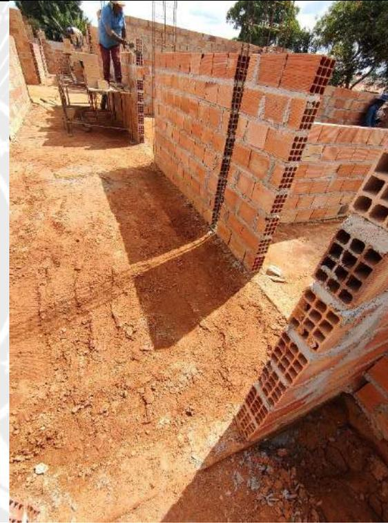
Foto 66 – Execução de alvenaria e armação de pilares
