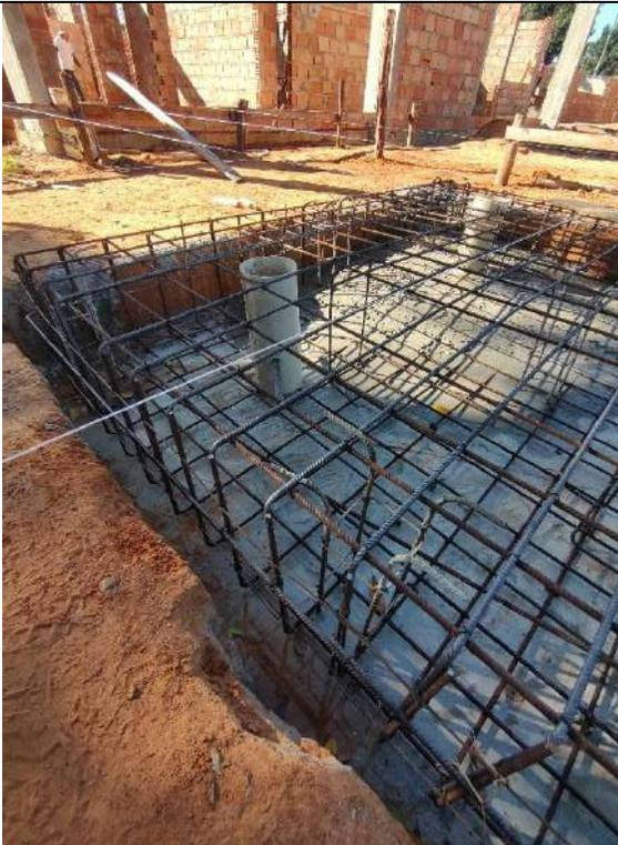
Foto 137 – Concretagem bloco de fundação caixa d'água
