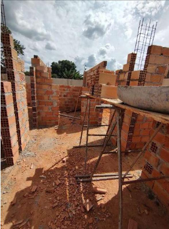
Foto 47 - Execução de alvenaria e armação de pilares
