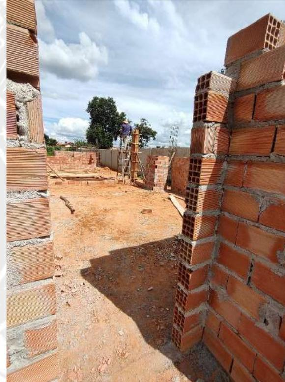
Foto 50 – Execução de alvenaria e armação de pilares
