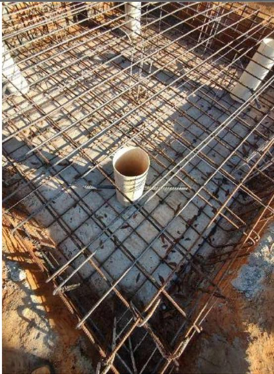
Foto 133 – Armação fundação caixa d'água
