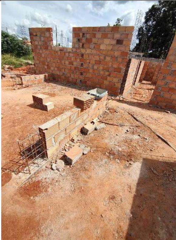
Foto 87 – Execução de alvenaria e armação de pilares
