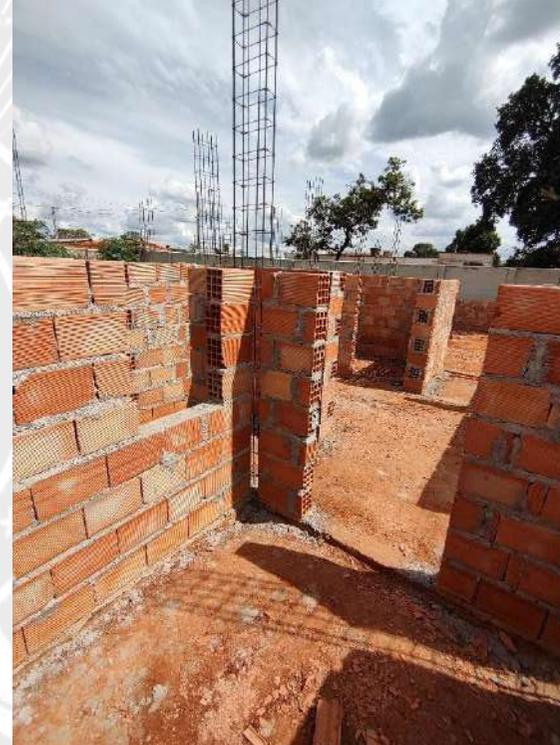
Foto 80 – Execução de alvenaria e armação de pilares
