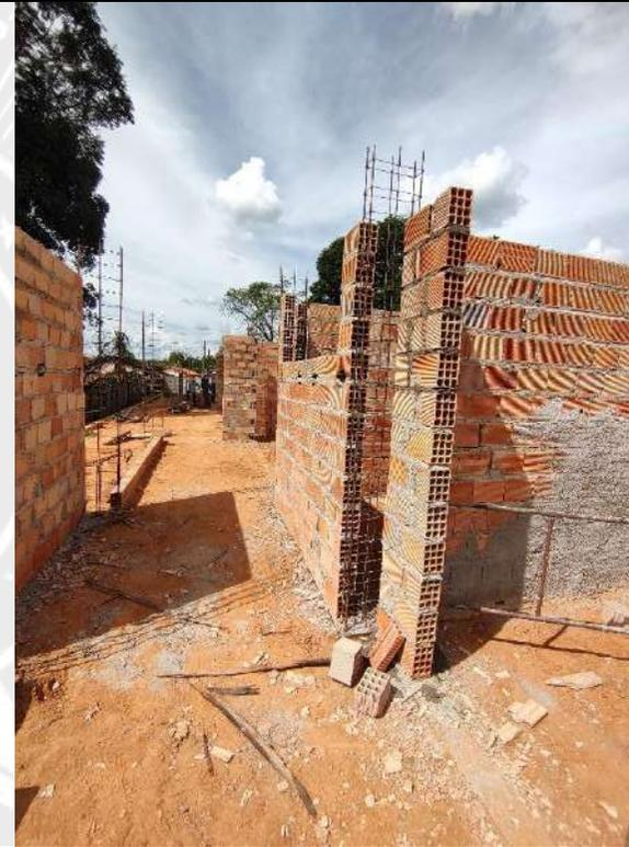
Foto 56 – Execução de alvenaria e armação de pilares
