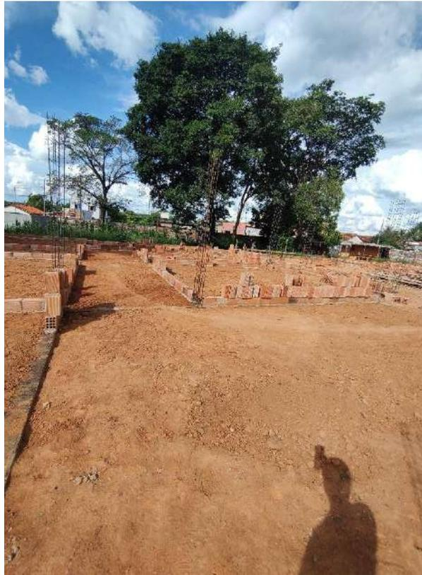
Foto 9 – Execução de alvenaria e armação de pilares
