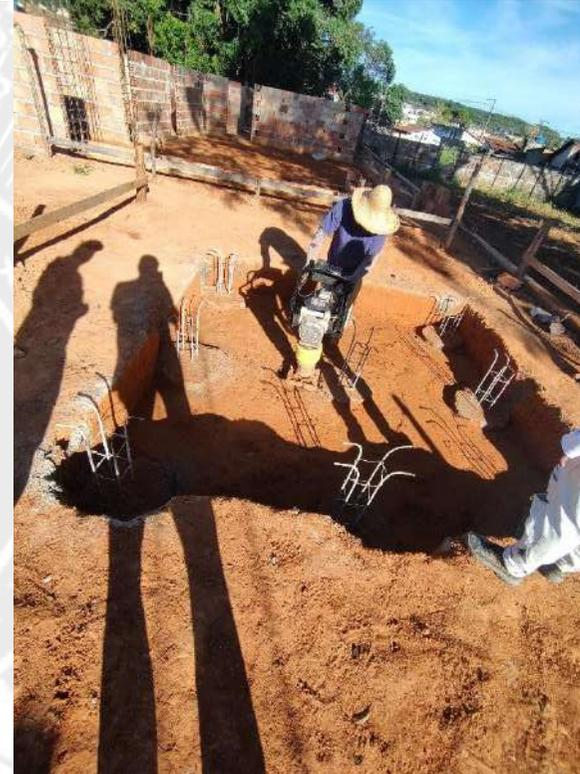
Foto 22 – Execução de bloco de fundação da caixa d'água
