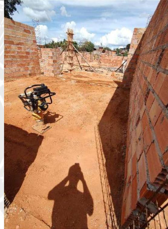
Foto 44 - Execução de alvenaria e armação de pilares
