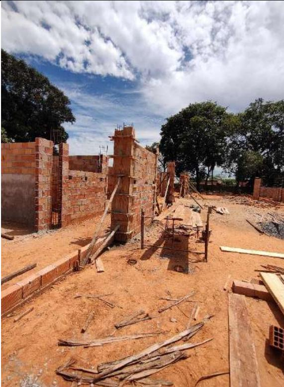
Foto 103 – Execução de forma e concretagem de pilares
