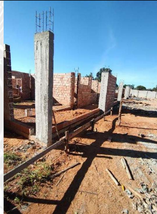
Foto 144 – Forma e concretagem de pilares
