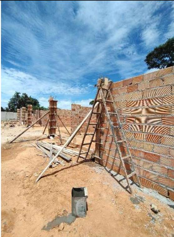
Foto 95 – Execução de forma e concretagem de pilares
