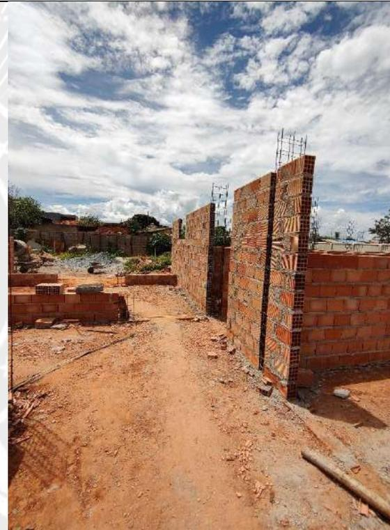
Foto 108 – Execução de alvenaria e armação de pilares
