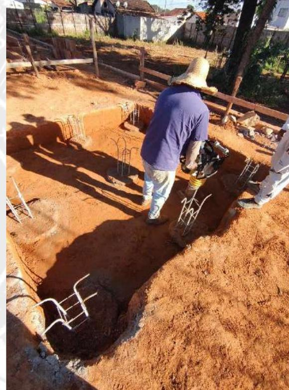
Foto 24 - Execução de bloco de fundação da caixa d'água
