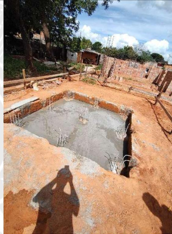
Foto 26 – Execução de bloco de fundação da caixa d'água
