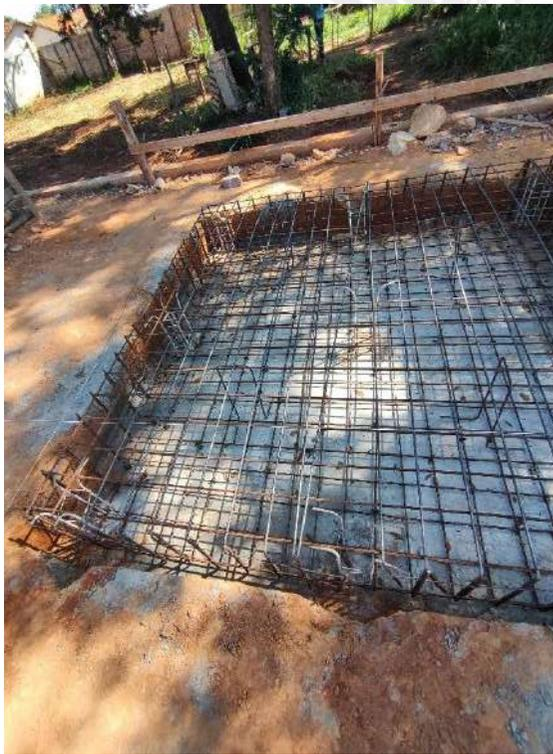
Foto 129 – Armação fundação caixa d'água
