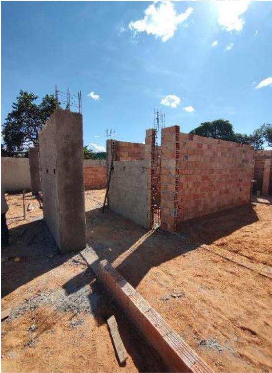
Foto 115 – Alvenaria, chapisco e concretagem de pilares
