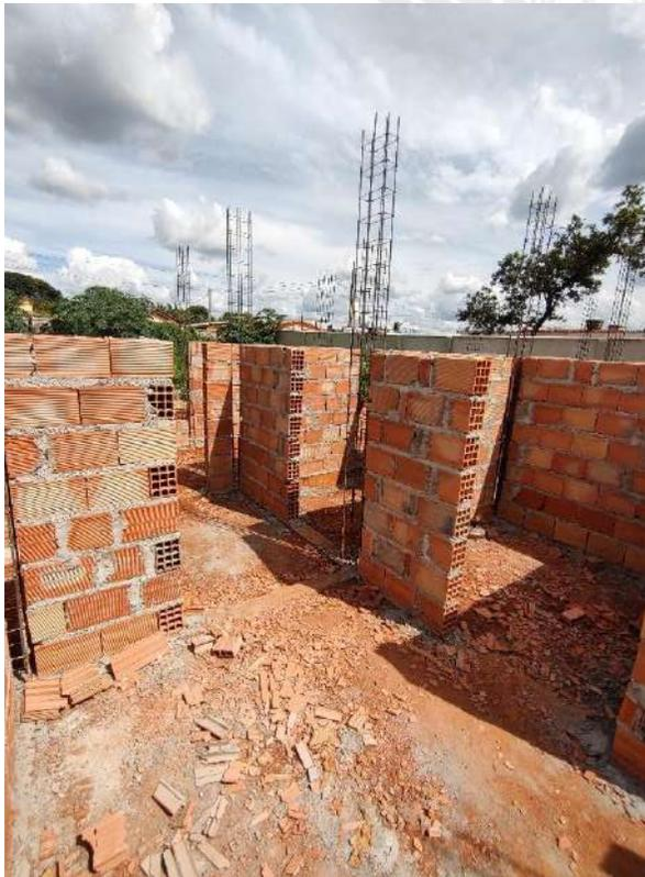
Foto 81 – Execução de alvenaria e armação de pilares
