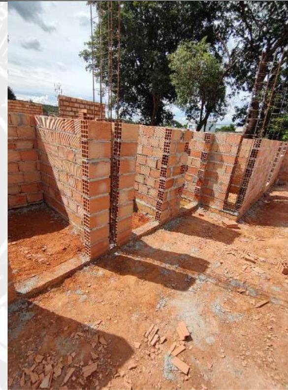
Foto 88 – Execução de alvenaria e armação de pilares
