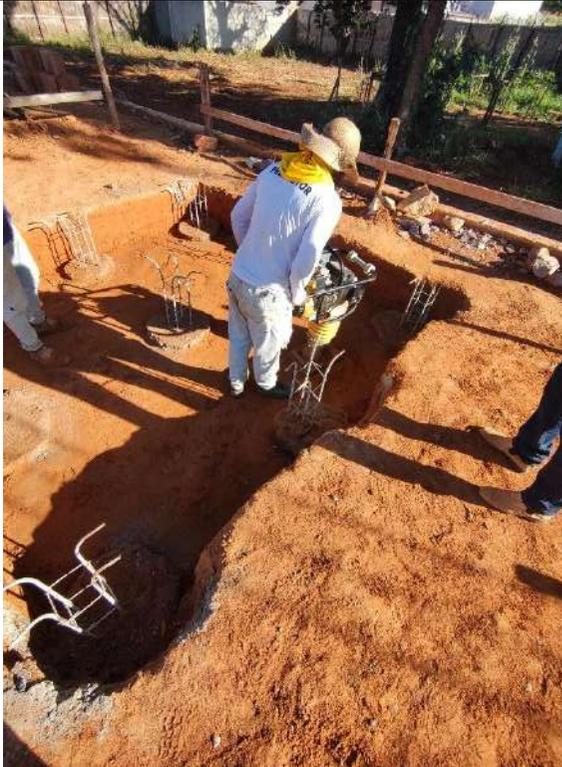
Foto 25 – Execução de bloco de fundação da caixa d'água
