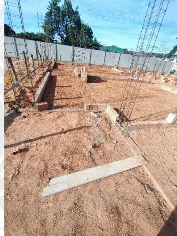
**Foto 4 - Execução de alvenaria e armação de pilares**
