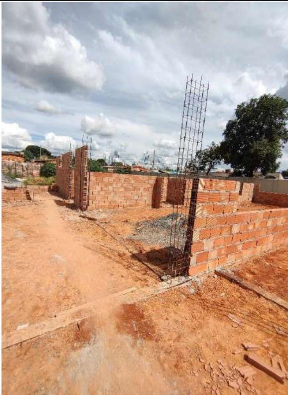
Foto 73 – Execução de alvenaria e armação de pilares
