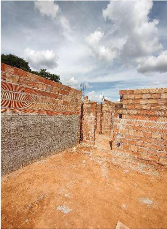
Foto 53 – Execução de alvenaria, chapisco e armação de pilares
