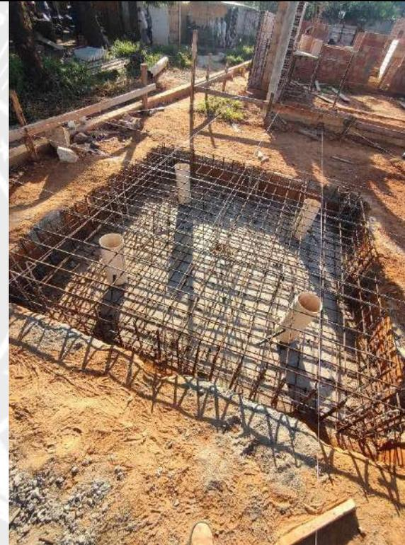
Foto 130 – Armação fundação caixa d'água
