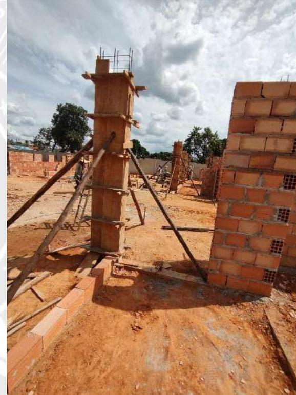
Foto 72 – Execução de forma e concretagem de pilares
