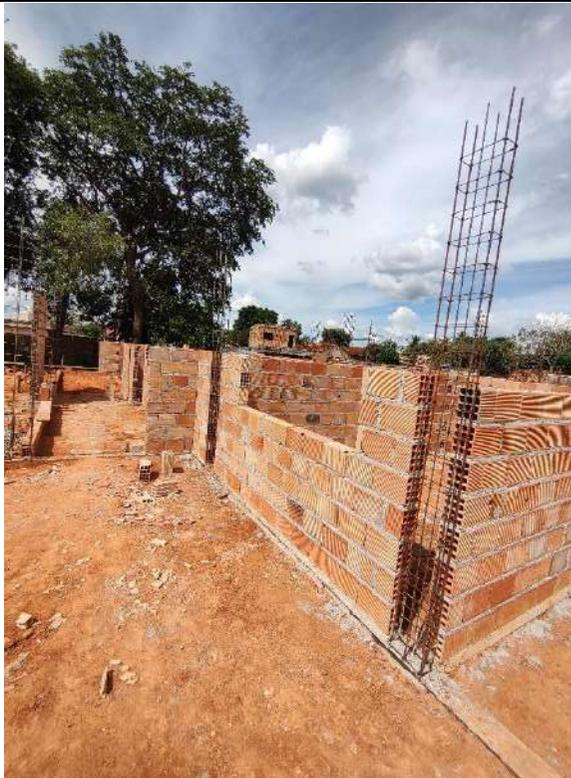
Foto 75 – Execução de alvenaria e armação de pilares
