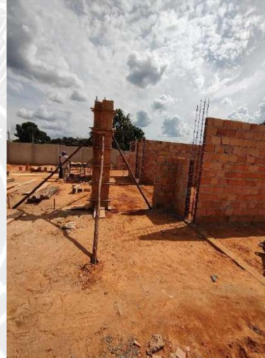
Foto 36 - Forma e concretagem de pilares
