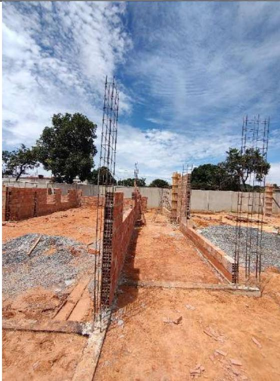
Foto 107 – Execução de alvenaria e armação de pilares
