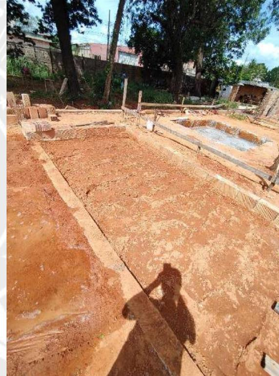
Foto 70 – Execução de alvenaria e armação de pilares
