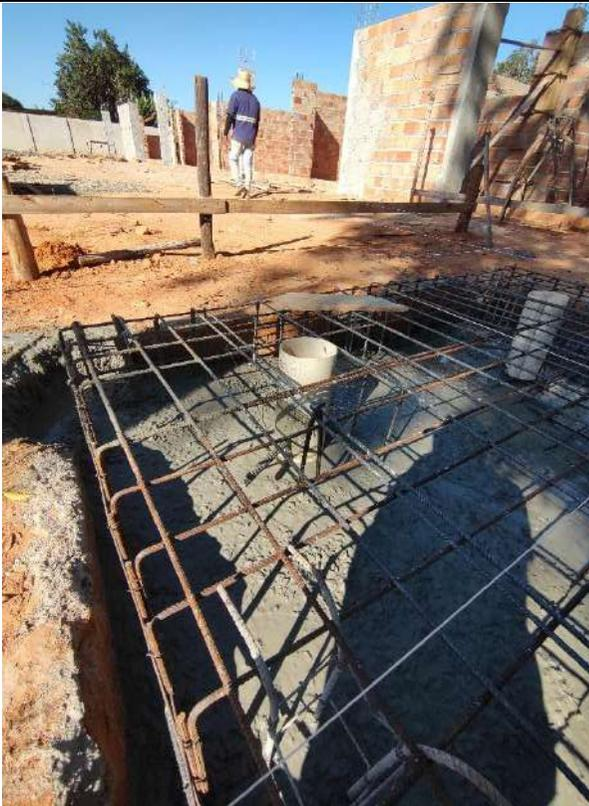
Foto 139 – Concretagem bloco de fundação caixa d'água
