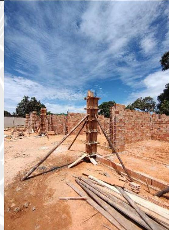
Foto 96 – Execução de forma e concretagem de pilares
