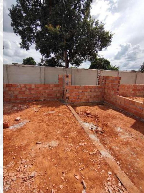
Foto 84 – Execução de alvenaria e armação de pilares
