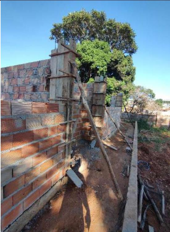
Foto 147 – Forma e concretagem de pilares
