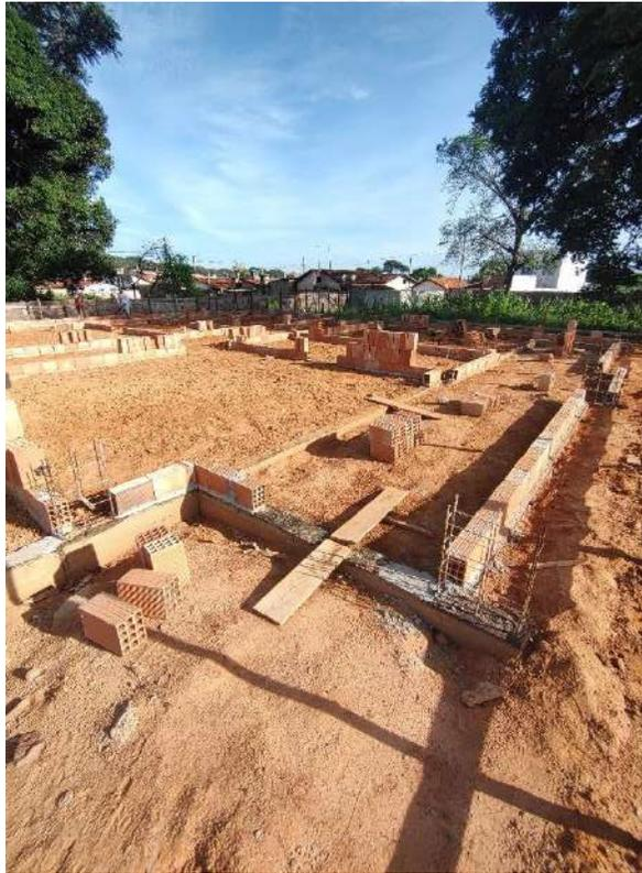
**Foto 3 - Execução de alvenaria**
