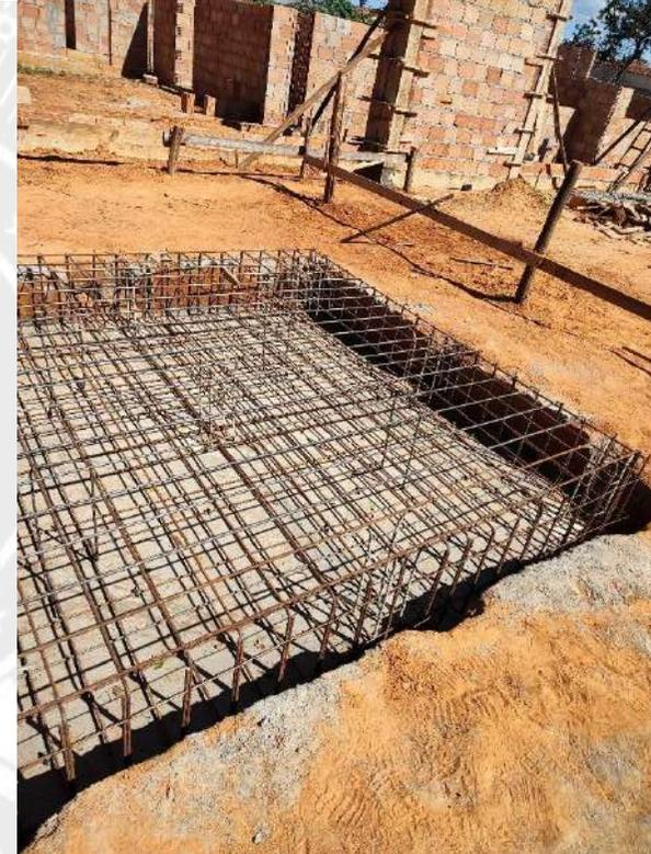
Foto 110 – Armação bloco de fundação caixa d'água
