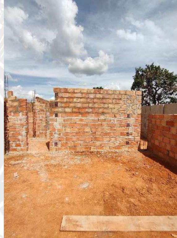
Foto 52 - Execução de alvenaria e armação de pilares
