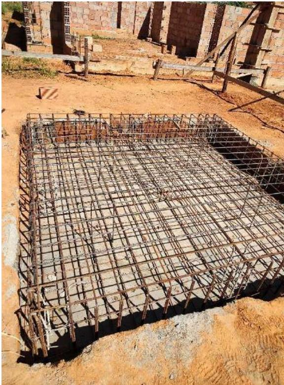
Foto 109 – Armação bloco de fundação caixa d'água
