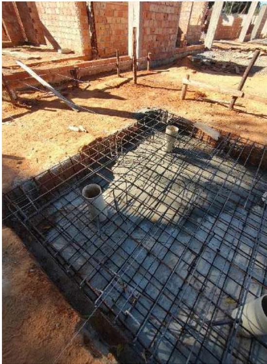
Foto 135 – Concretagem bloco de fundação caixa d'água
