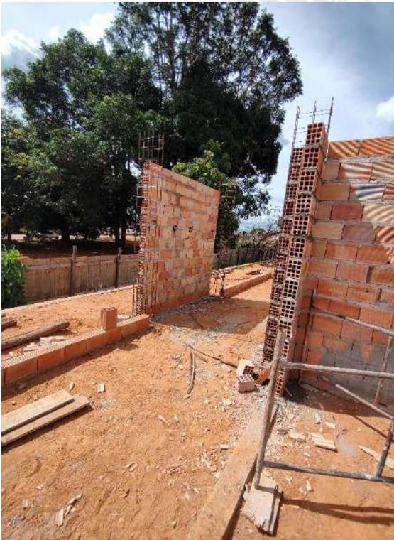
Foto 55 – Execução de alvenaria e armação de pilares
