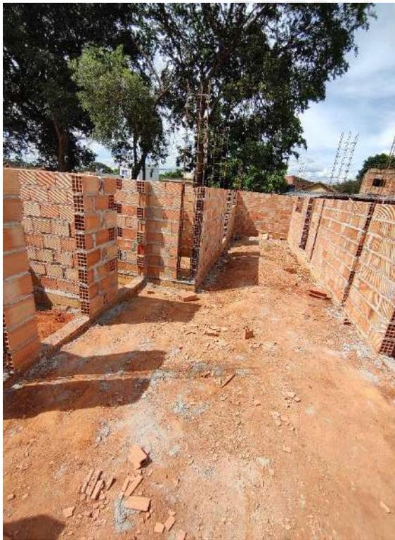
Foto 89 – Execução de alvenaria e armação de pilares
