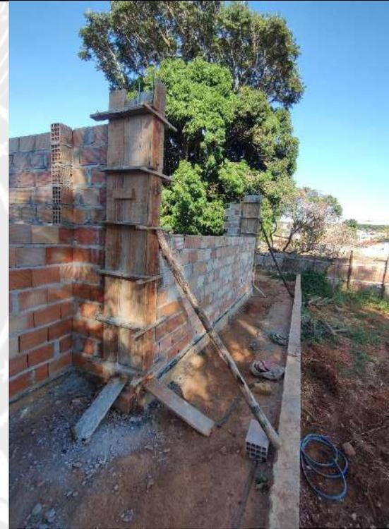
Foto 148 – Forma e concretagem de pilares
