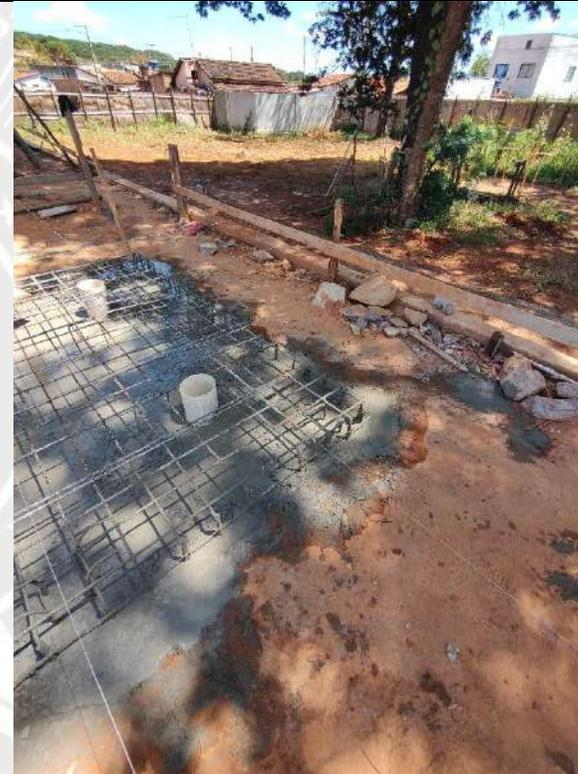
Foto 142 – Concretagem bloco de fundação caixa d'água
