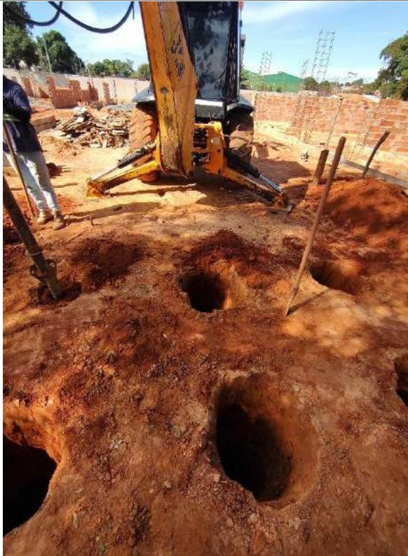
Foto 15 - Perfuração de estacas de fundação da caixa d'água
