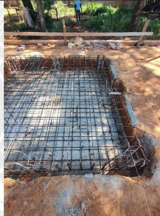
Foto 128 – Armação fundação caixa d'água
