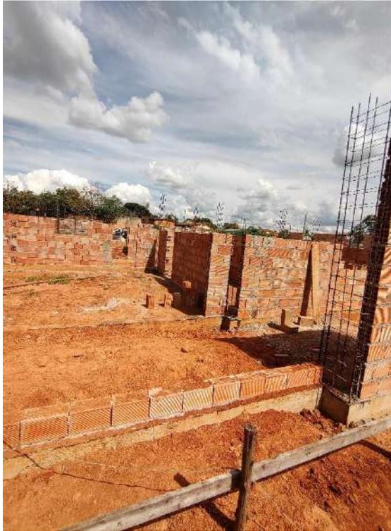
Foto 29 – Execução de alvenaria e armação de pilares
