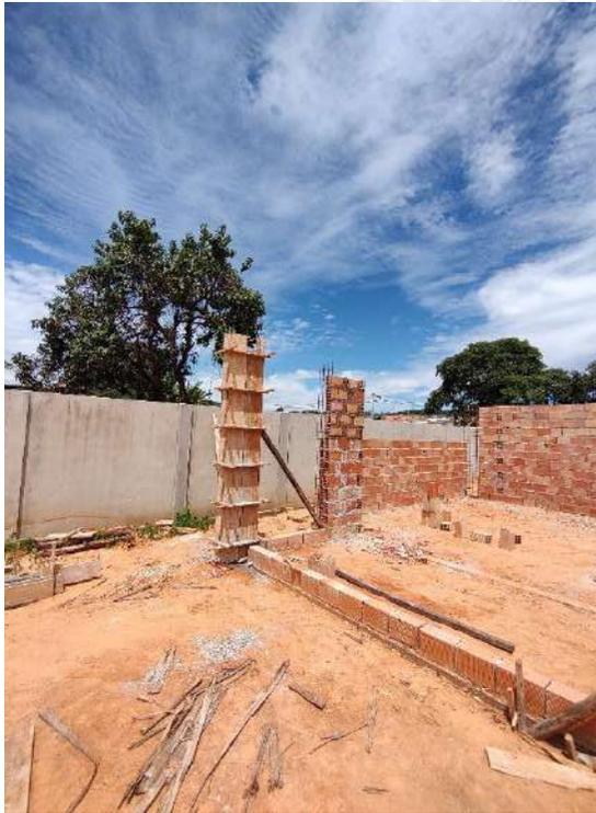
Foto 99 – Execução de forma e concretagem de pilares
