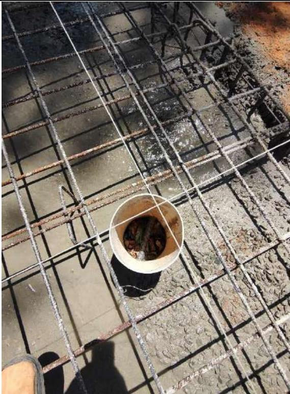
Foto 141 – Concretagem bloco de fundação caixa d'água
