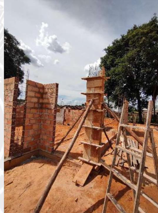
Foto 34 – Forma e concretagem de pilares
