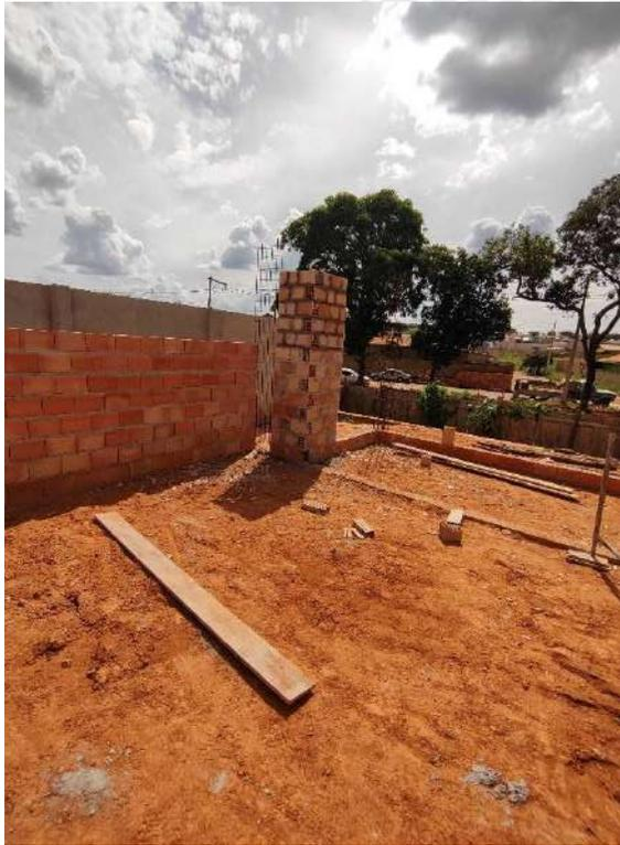
Foto 51 – Execução de alvenaria e armação de pilares
