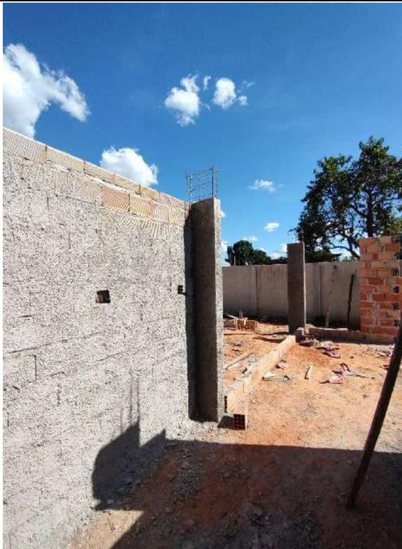
Foto 117 – Alvenaria, chapisco e concretagem de pilares
