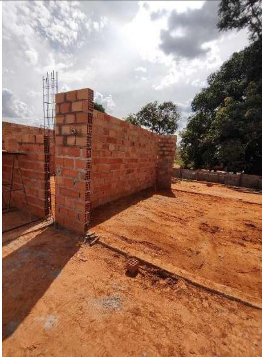
Foto 39 – Execução de alvenaria e armação de pilares
