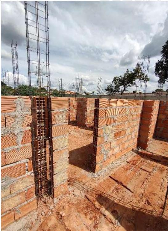
Foto 79 – Execução de alvenaria e armação de pilares
