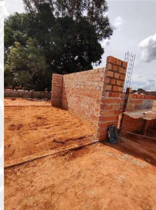
Foto 40 – Execução de alvenaria e armação de pilares
