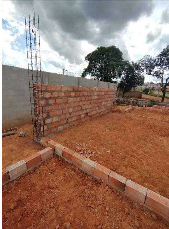
Foto 5 - Execução de alvenaria e armação de pilares
