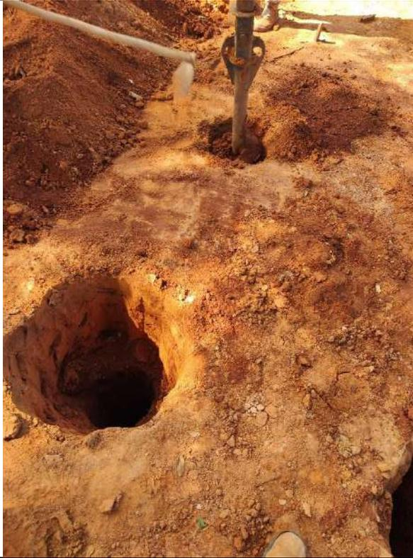
Foto 11 – Perfuração de estacas de fundação da caixa d'água
