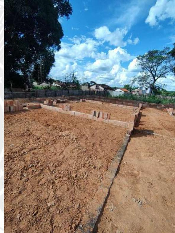
Foto 8 - Execução de alvenaria e armação de pilares
