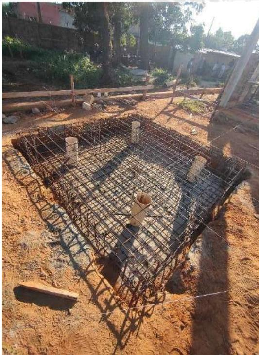
Foto 131 – Armação fundação caixa d'água
