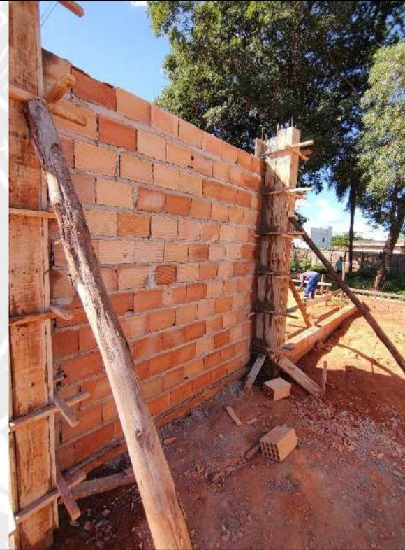
Foto 112 – Execução de forma e concretagem de pilares
