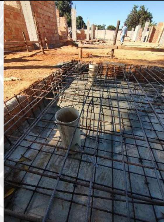
Foto 138 – Concretagem bloco de fundação caixa d'água
