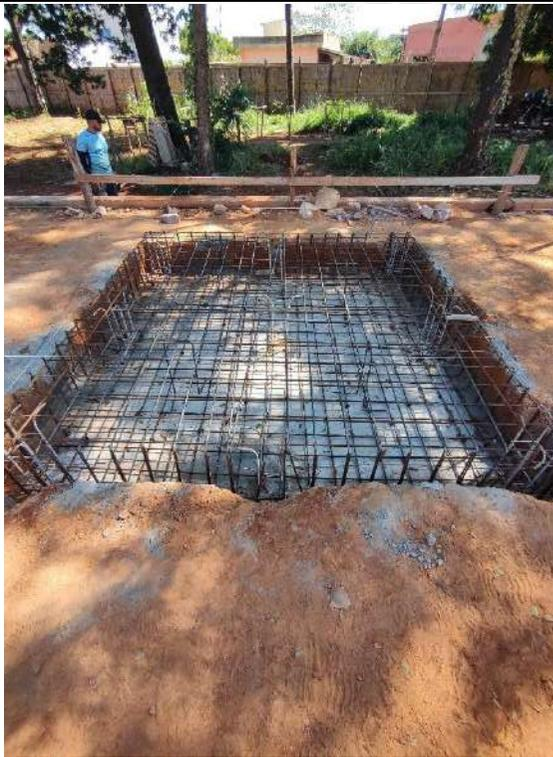
Foto 127 – Armação fundação caixa d'água
