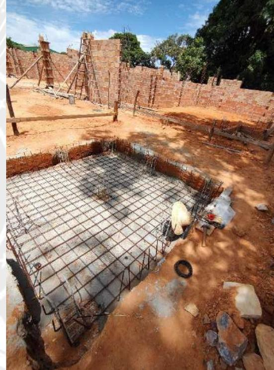
Foto 94 – Armação de bloco de fundação da caixa d'água
