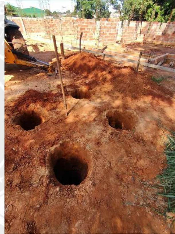
Foto 14 – Perfuração de estacas de fundação da caixa d'água
