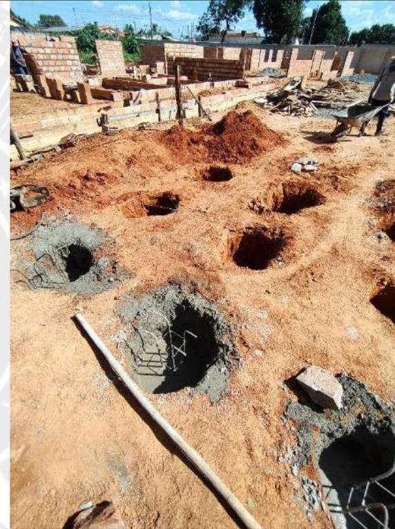
Foto 20 – Execução de estacas de fundação
