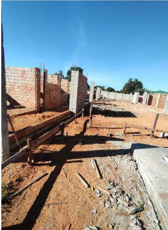
Foto 145 – Forma e concretagem de pilares
