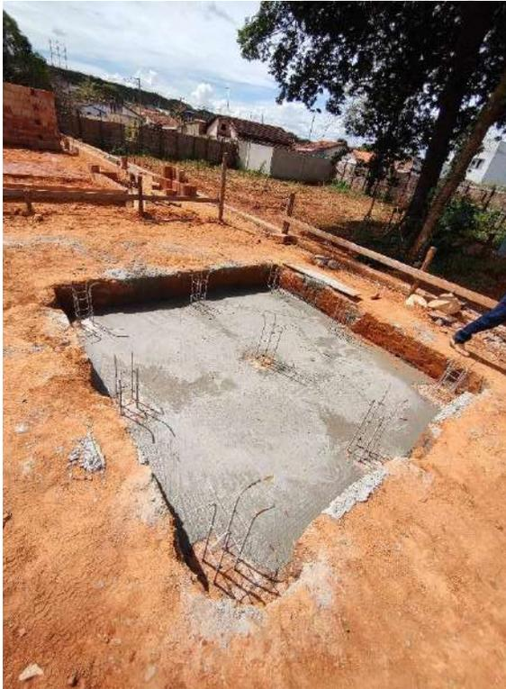
Foto 27 – Execução de bloco de fundação da caixa d'água
