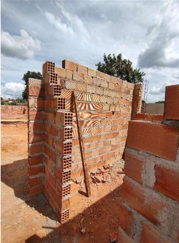
Foto 49 – Execução de alvenaria e armação de pilares
