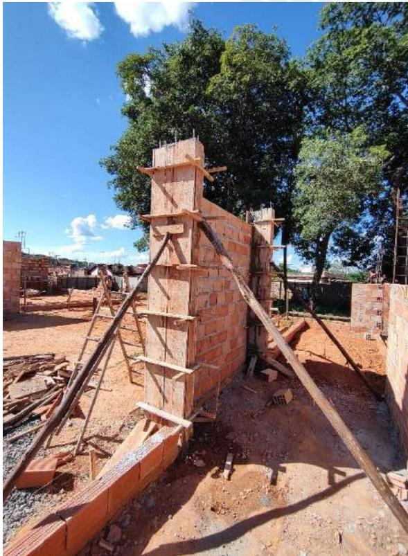
Foto 113 – Execução de forma e concretagem de pilares
