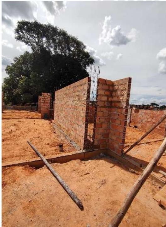
Foto 33 – Execução de alvenaria e armação de pilares
