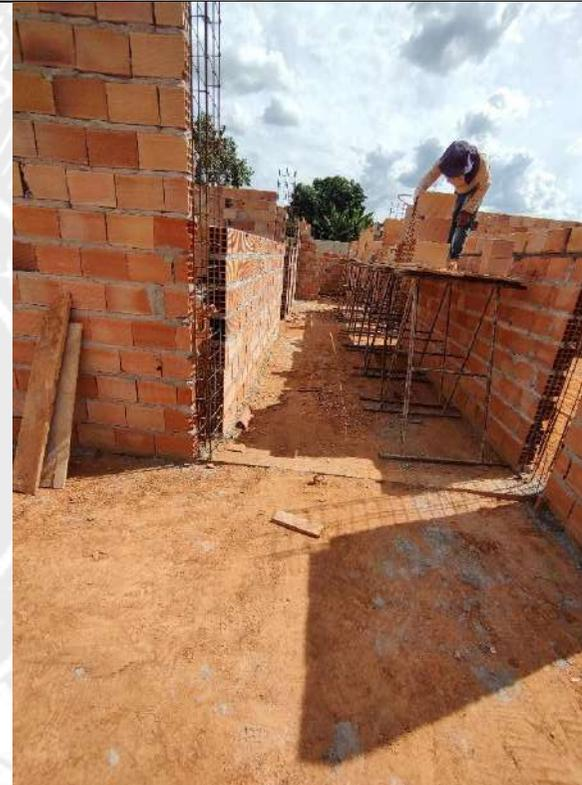
Foto 42 - Execução de alvenaria e armação de pilares
