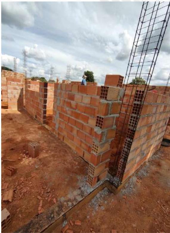
Foto 61 – Execução de alvenaria e armação de pilares
