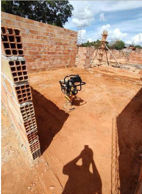
Foto 43 - Execução de alvenaria e armação de pilares
