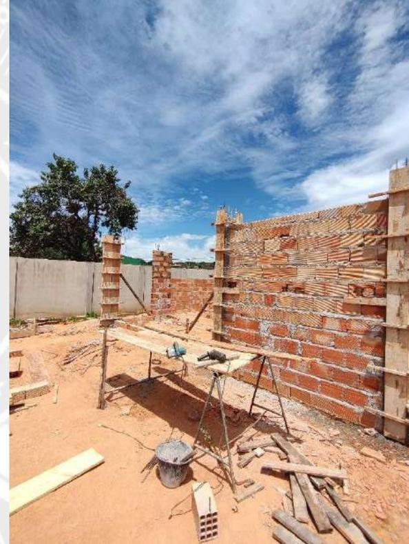
Foto 98 – Execução de forma e concretagem de pilares
