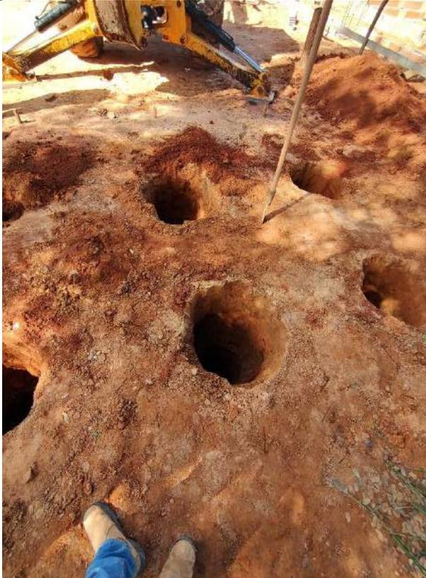
Foto 13 – Perfuração de estacas de fundação da caixa d'água
