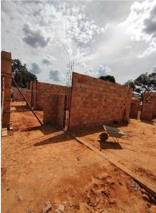
Foto 35 - Execução de alvenaria e armação de pilares
