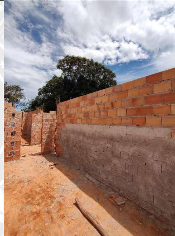
Foto 104 – Execução de alvenaria e chapisco
