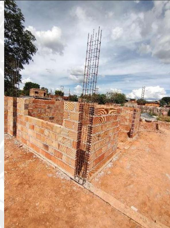
Foto 74 – Execução de alvenaria e armação de pilares
