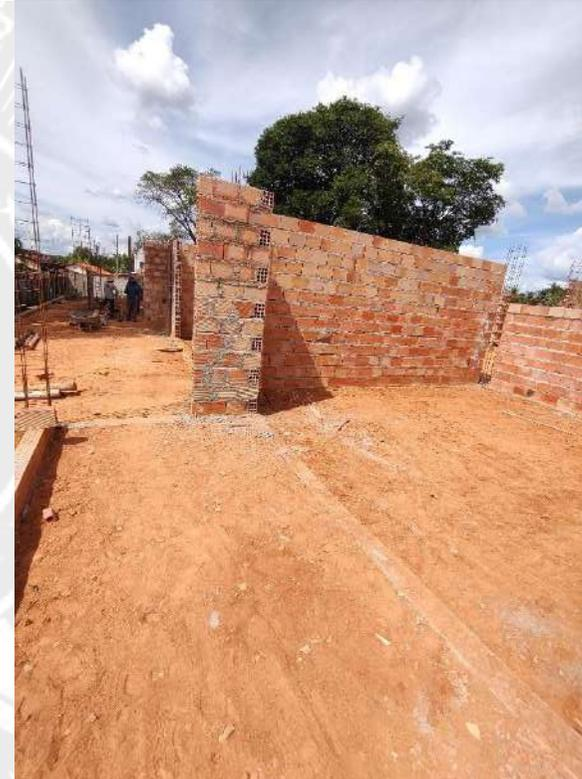
**Foto 58 – Execução de alvenaria e armação de pilares**
