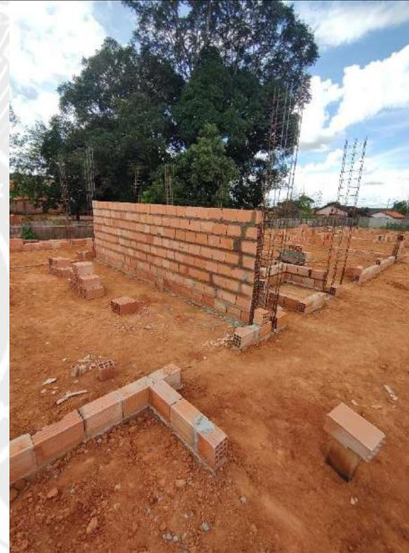
Foto 6 - Execução de alvenaria e armação de pilares
