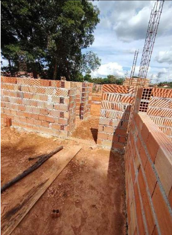
Foto 65 – Execução de alvenaria e armação de pilares
