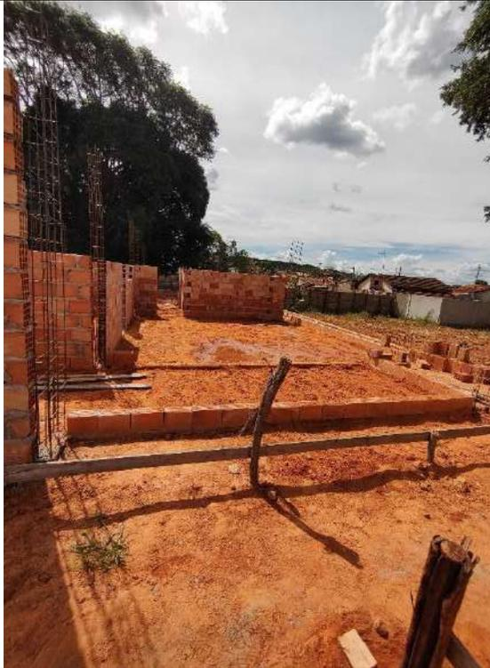
Foto 31 - Execução de alvenaria e armação de pilares
