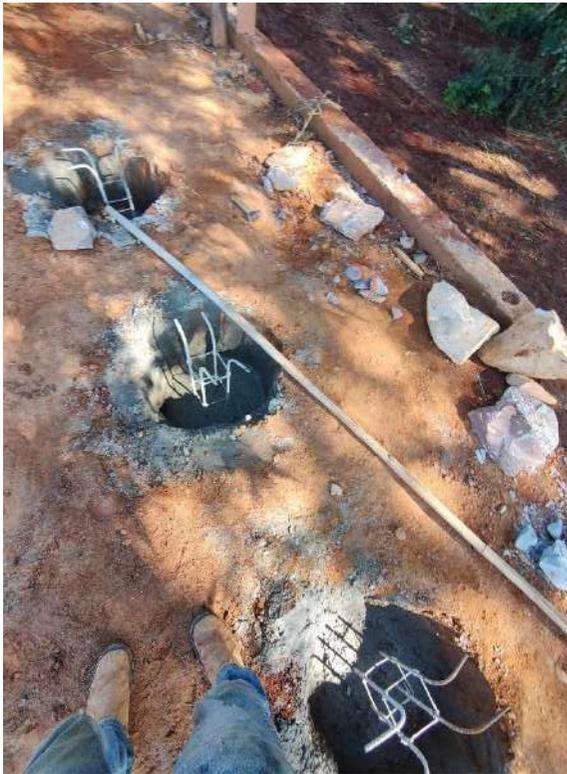
Foto 21 – Execução de estacas de fundação
