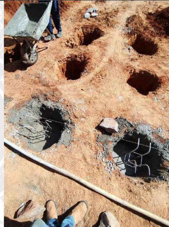
Foto 18 - Execução de estacas de fundação
