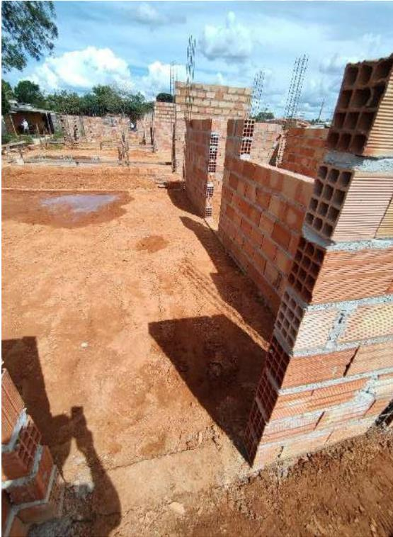
Foto 67 – Execução de alvenaria e armação de pilares
