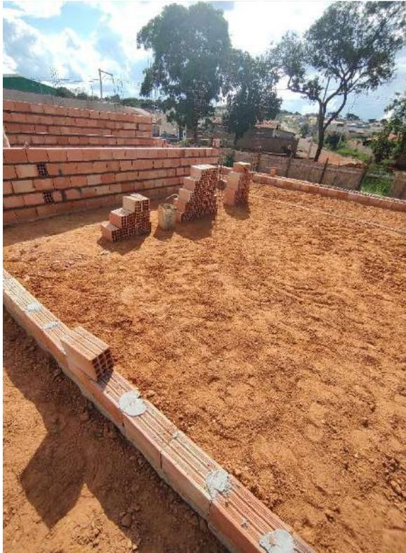
Foto 7 - Execução de alvenaria e armação de pilares
