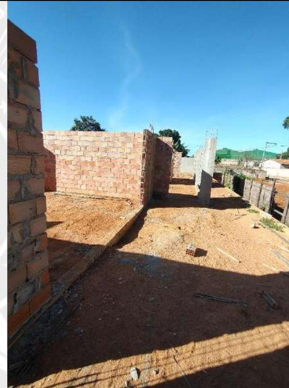
Foto 154 – Execução de alvenaria
