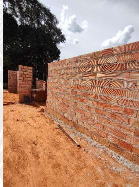
Foto 38 - Execução de alvenaria e armação de pilares
