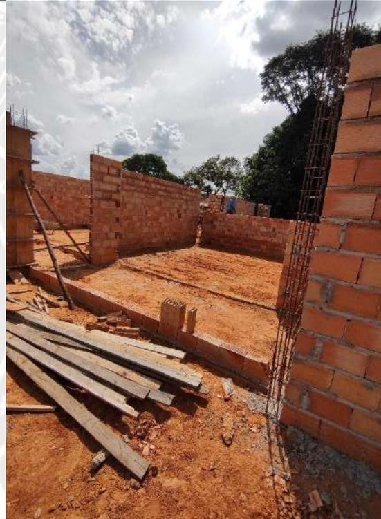
Foto 32 - Execução de alvenaria e armação de pilares
