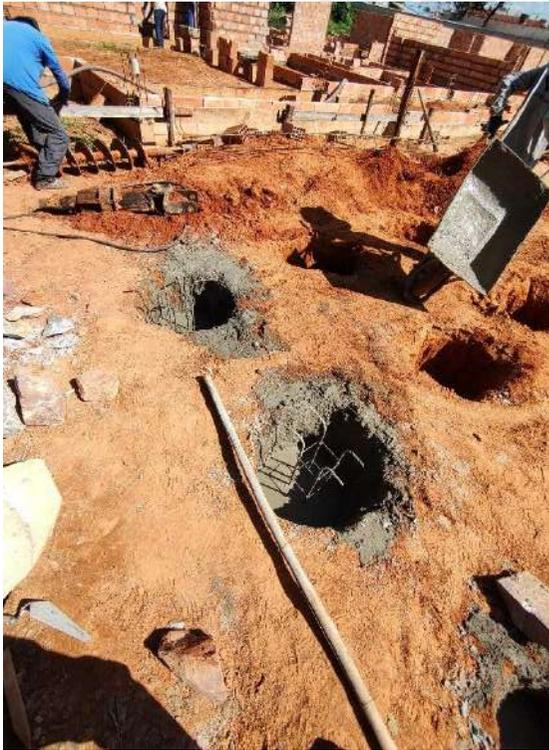
Foto 19 – Execução de estacas de fundação
