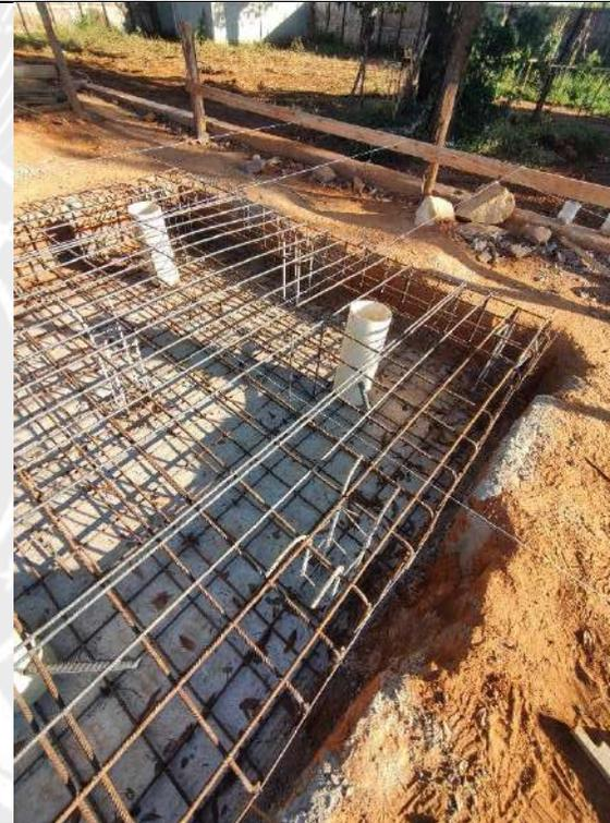
Foto 134 – Armação fundação caixa d'água
