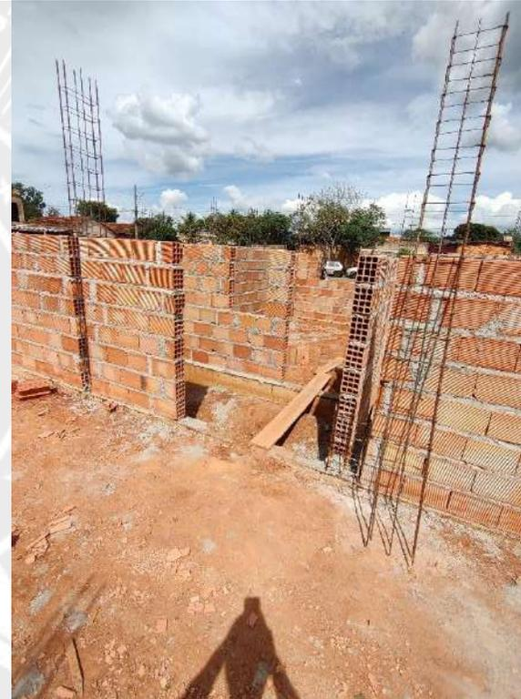
Foto 90 – Execução de alvenaria e armação de pilares
