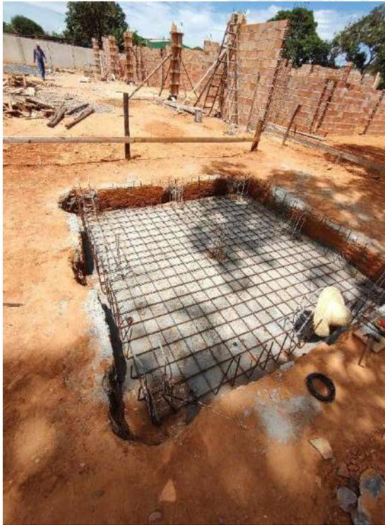
Foto 93 – Armação de bloco de fundação da caixa d'água
