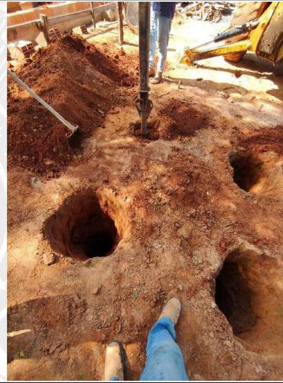
Foto 12 – Perfuração de estacas de fundação da caixa d'água
