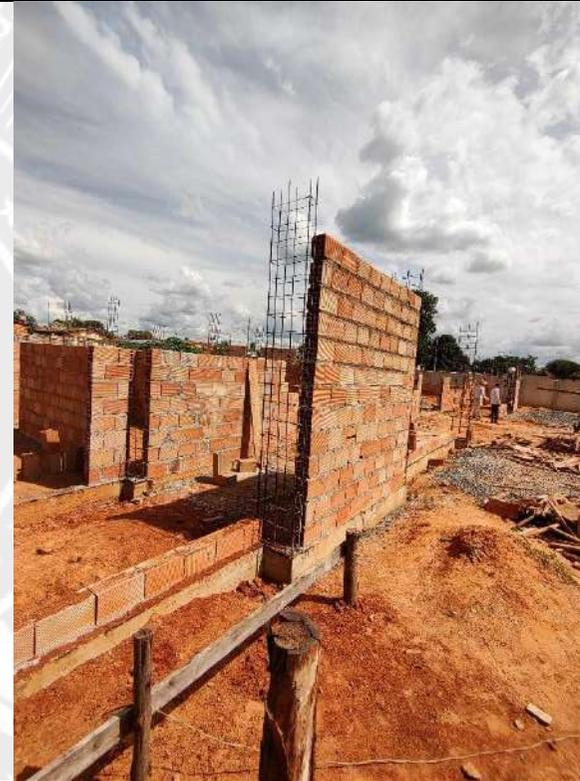
Foto 28 – Execução de alvenaria e armação de pilares
