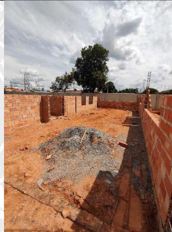
Foto 76 – Execução de alvenaria e armação de pilares
