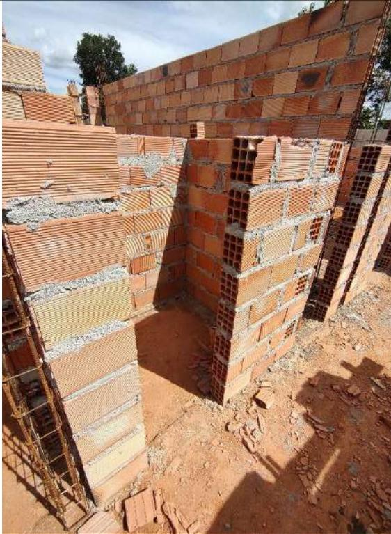
Foto 45 - Execução de alvenaria e armação de pilares
