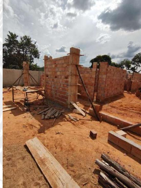
**Foto 92 – Execução de forma e concretagem de pilares**
