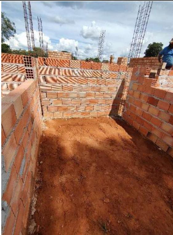
**Foto 63 – Execução de alvenaria e armação de pilares**
