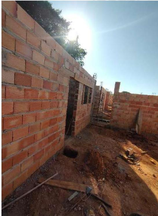
Foto 153 – Execução de alvenaria e vergas
