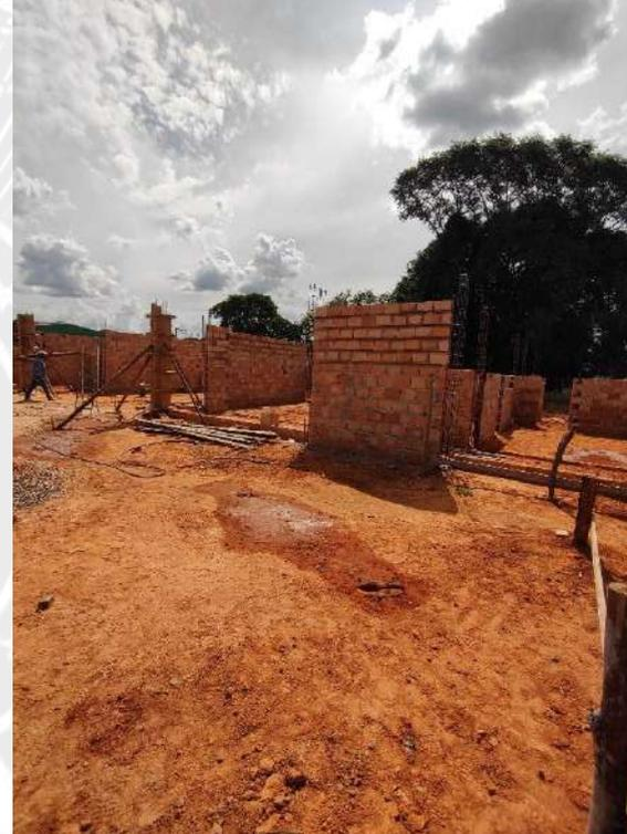
Foto 30 - Execução de alvenaria e armação de pilares
