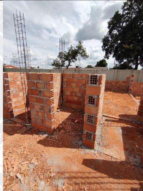
Foto 82 – Execução de alvenaria e armação de pilares
