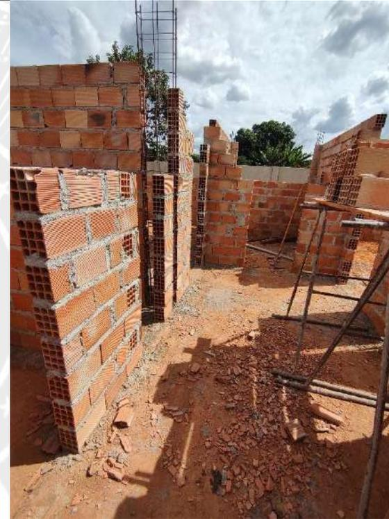
Foto 46 - Execução de alvenaria e armação de pilares
