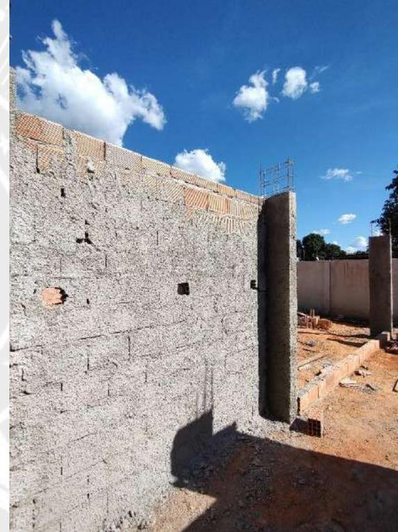
Foto 116 – Alvenaria, chapisco e concretagem de pilares
