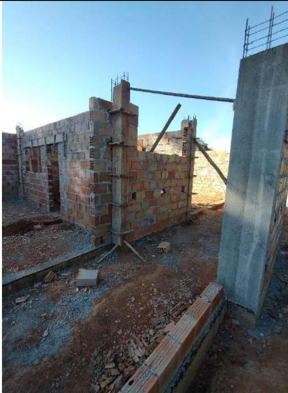
Foto 149 – Forma e concretagem de pilares
