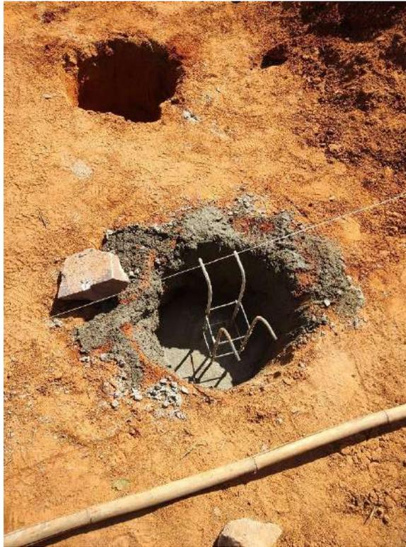
Foto 17 - Execução de estacas de fundação
