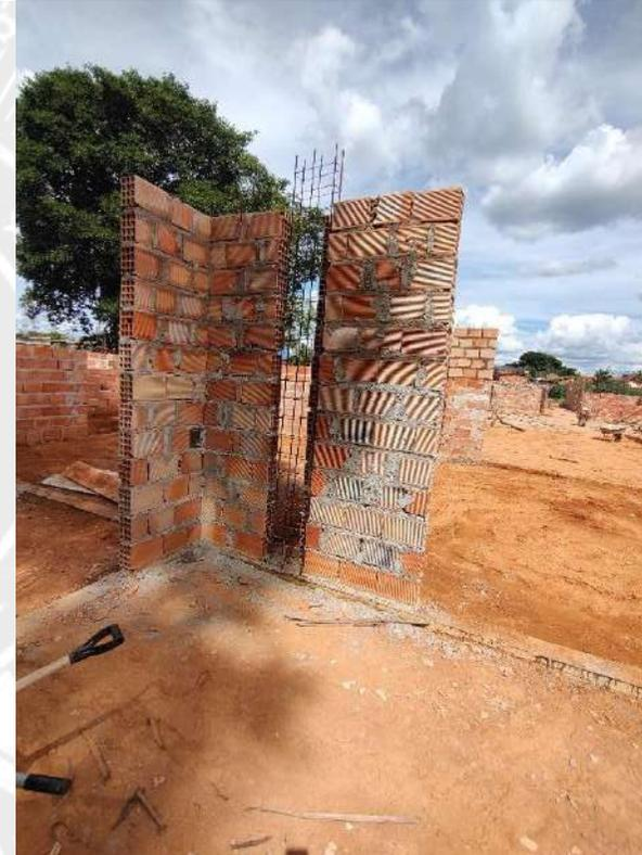
Foto 60 – Execução de alvenaria e armação de pilares
