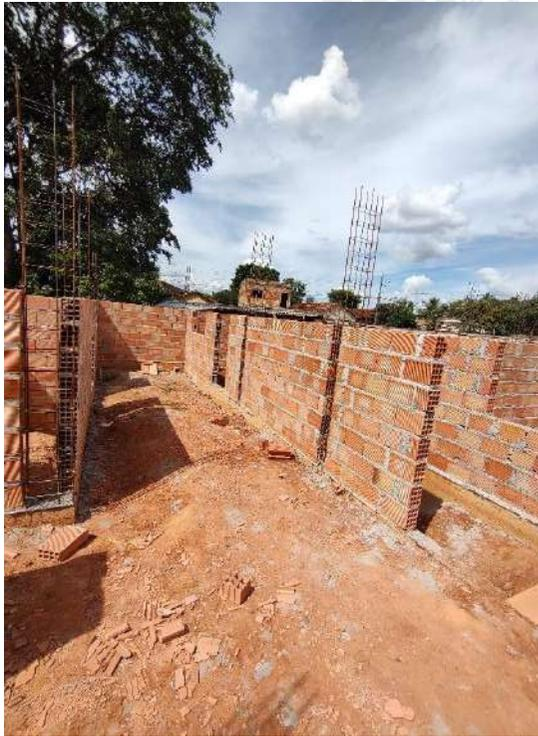
**Foto 91 – Execução de alvenaria e armação de pilares**
