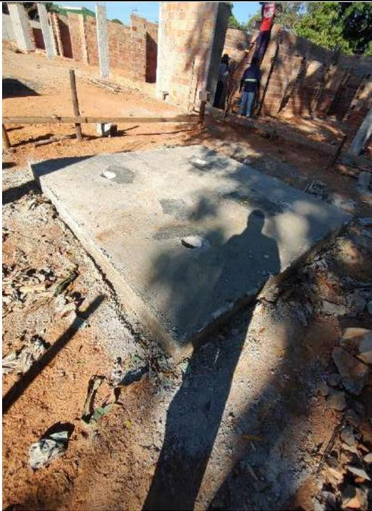
Foto 143 – Concretagem bloco de fundação caixa d'água
