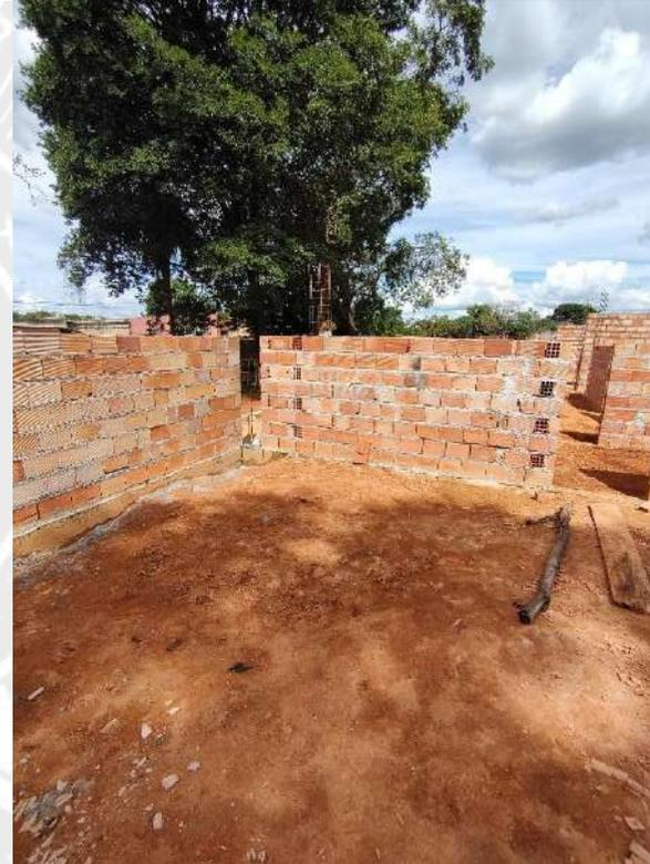
Foto 62 – Execução de alvenaria e armação de pilares
