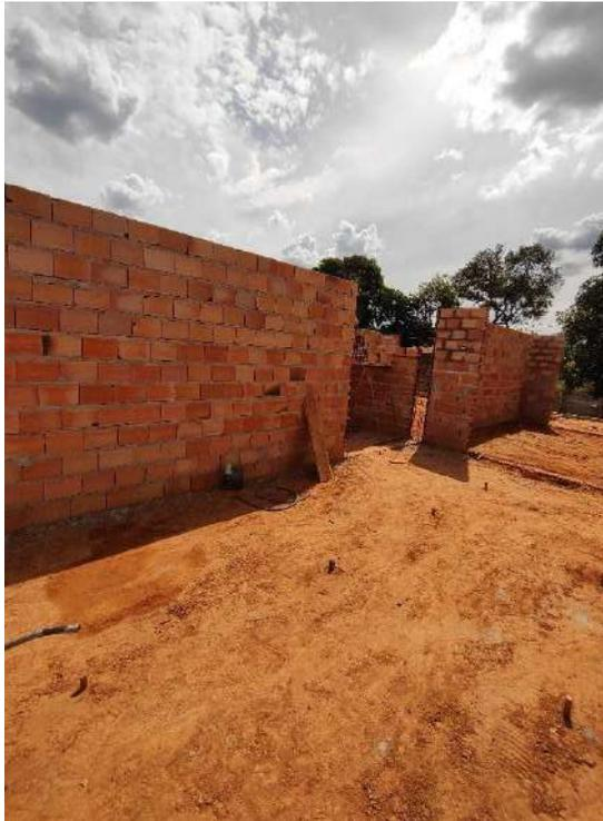
Foto 37 – Execução de alvenaria e armação de pilares
