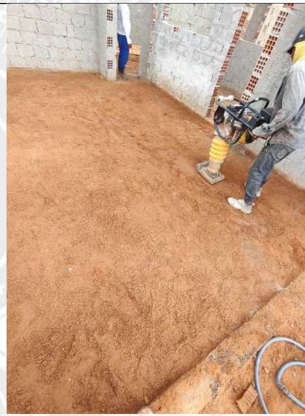
Foto 112 – Acerto compactado de piso
