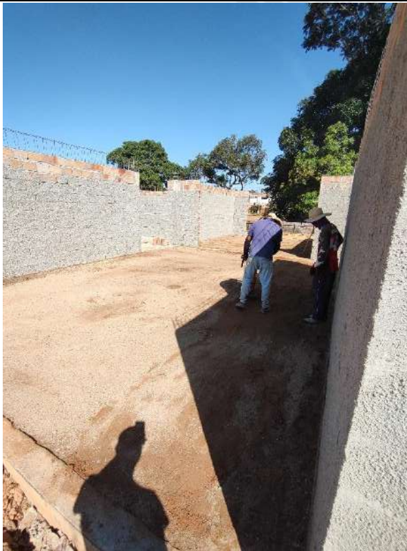
Foto 65 – Acerto compactado de piso
