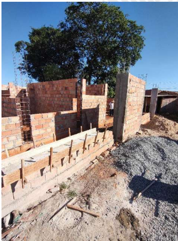
Foto 33 – Armação, forma e concretagem de pilares
