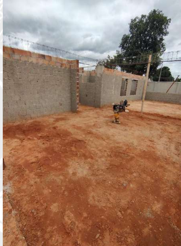
Foto 168 – Acerto compactado de piso
