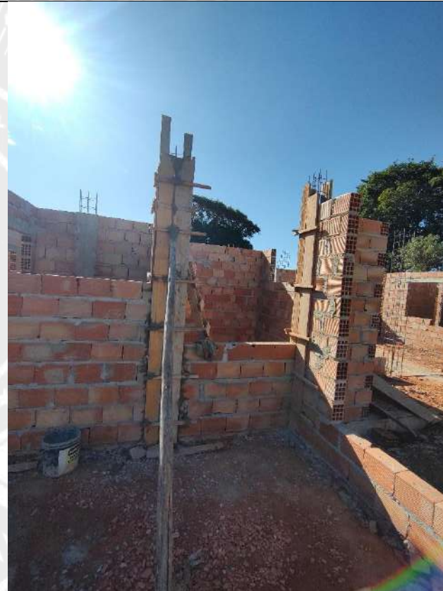
Foto 64 – Armação, forma e concretagem de pilares
