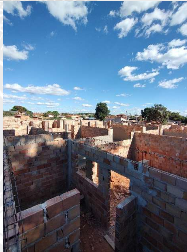
Foto 36 - Armação, forma e concretagem de cintas
