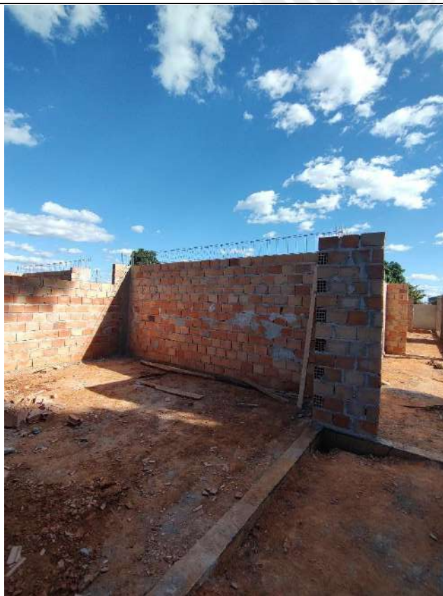
Foto 37 – Armação, forma e concretagem de cintas
