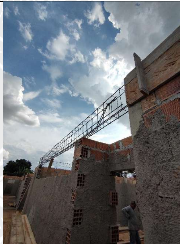
Foto 84 – Armação, forma e concretagem de vigas e cintas
