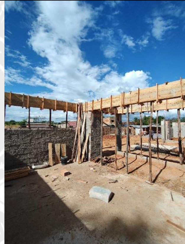
Foto 122 – Concretagem de piso e vigas
