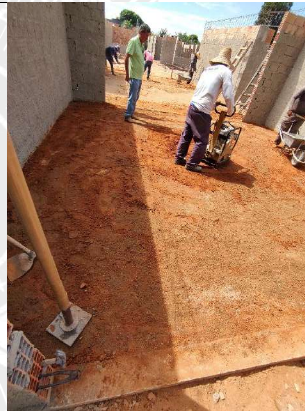
Foto 106 – Acerto compactado de piso
