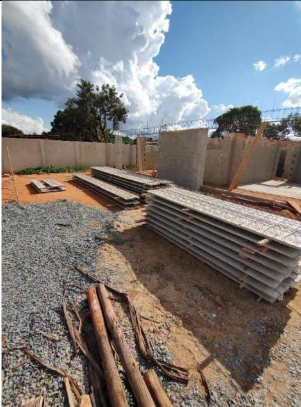
Foto 149 – Armação, forma e concretagem de vigas e cintas
