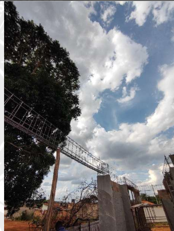
Foto 68 – Armação, forma e concretagem de vigas e cintas
