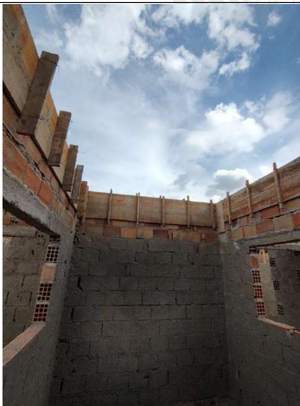
Foto 81 – Armação, forma e concretagem de vigas e cintas
