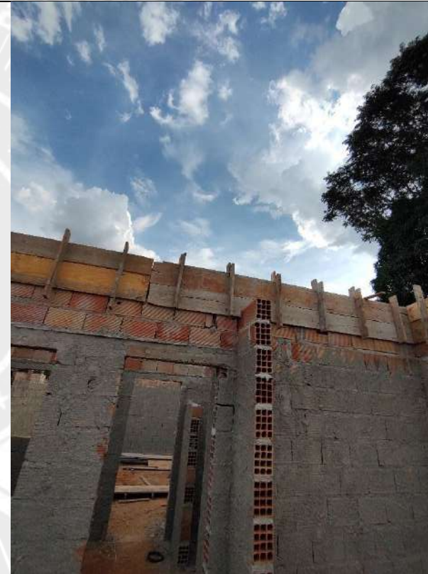
Foto 78 – Armação, forma e concretagem de vigas e cintas
