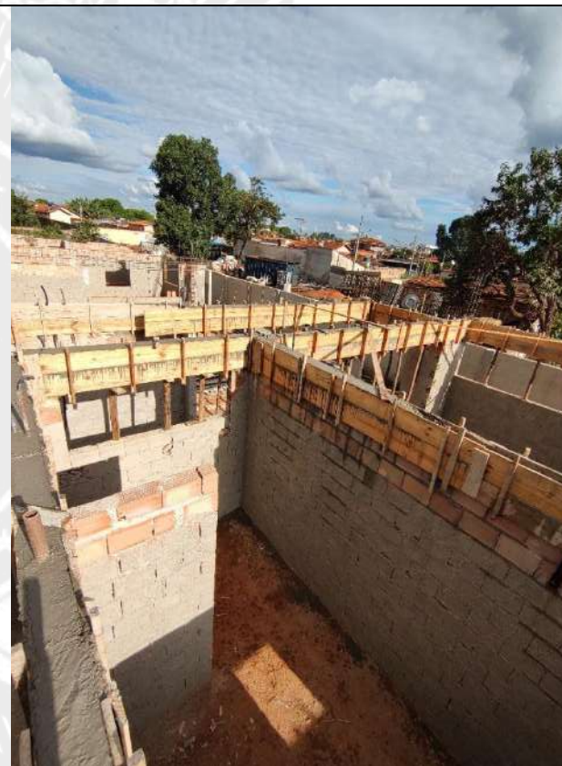
Foto 182 – Concretagem de vigas e cintas
