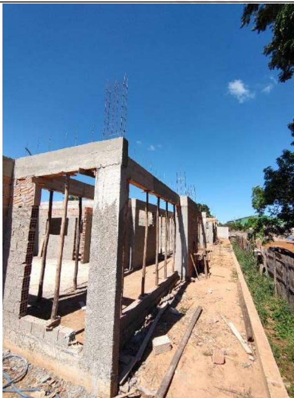
Foto 171 – Armação, forma e concretagem de vigas e cintas
