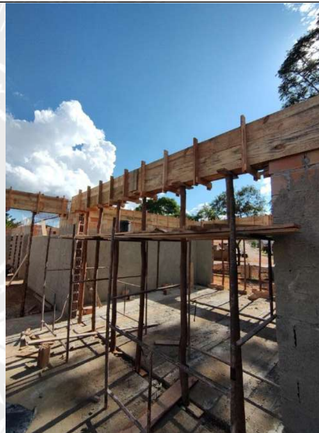
Foto 134 – Armação, forma e concretagem de vigas e cintas
