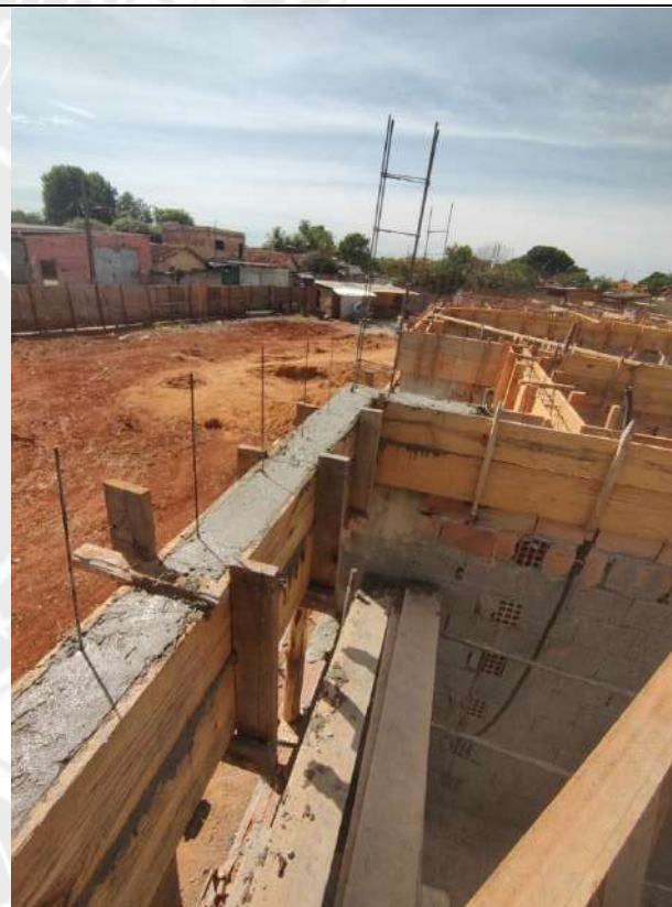
Foto 154 – Armação, forma e concretagem de vigas e cintas
