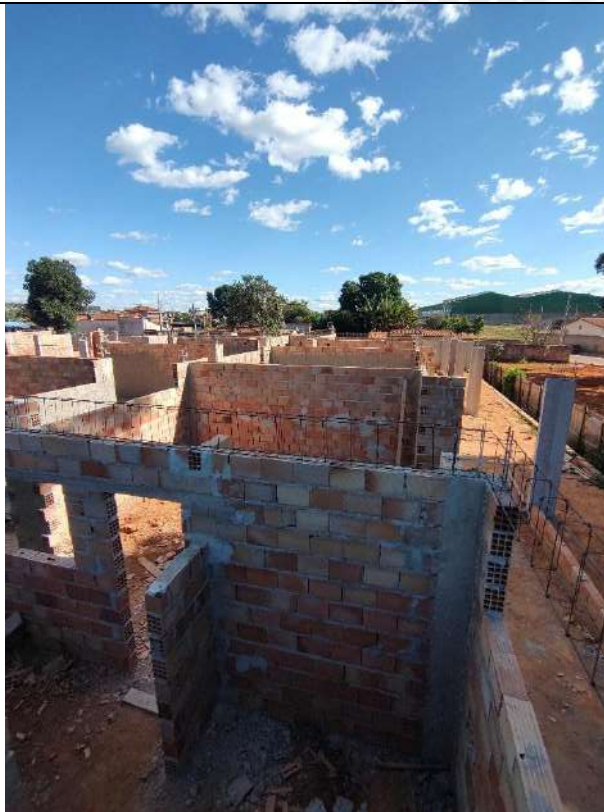
Foto 35 - Armação, forma e concretagem de cintas
