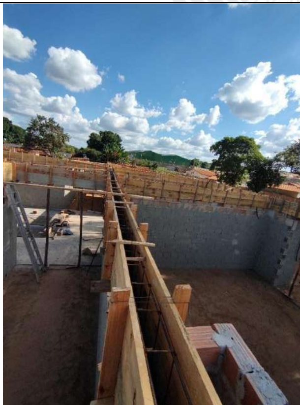
Foto 153 – Armação, forma e concretagem de vigas e cintas
