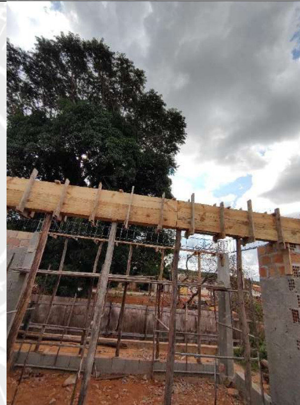
Foto 76 – Armação, forma e concretagem de vigas e cintas
