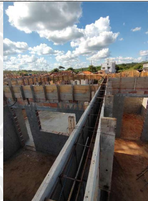
Foto 152 – Armação, forma e concretagem de vigas e cintas
