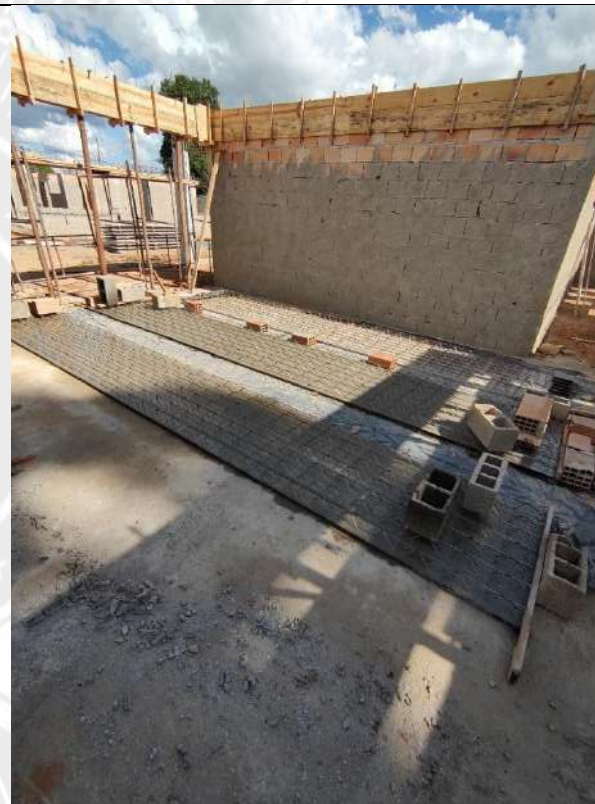
Foto 136 – Armação, forma e concretagem de vigas e cintas
