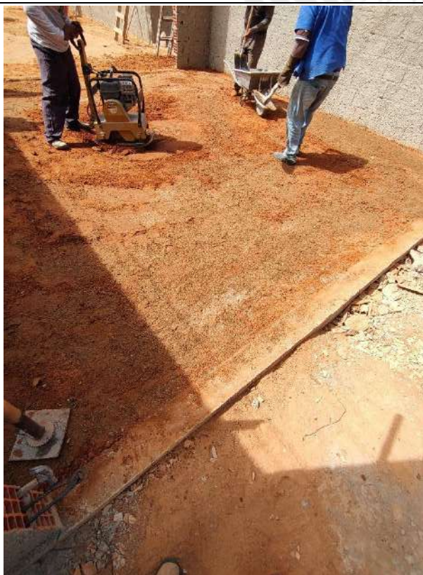
Foto 105 – Acerto compactado de piso
