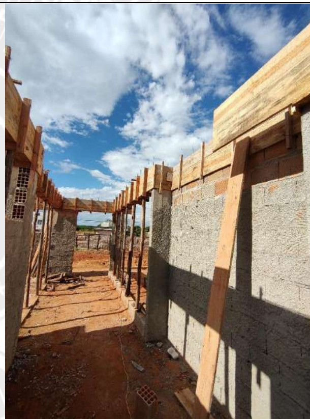
Foto 146 – Armação, forma e concretagem de vigas e cintas
