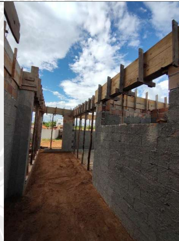
Foto 142 – Armação, forma e concretagem de vigas e cintas
