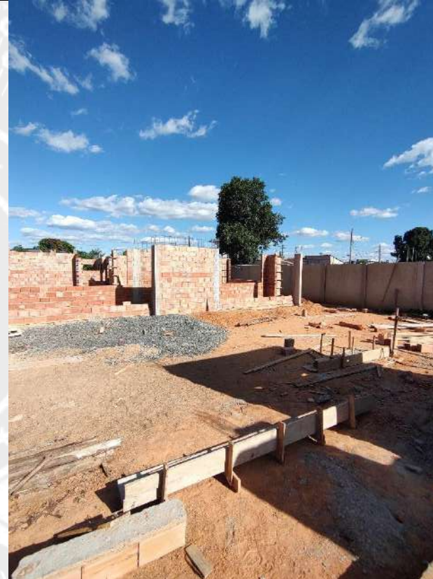
Foto 52 - Armação, forma e concretagem de pilares
