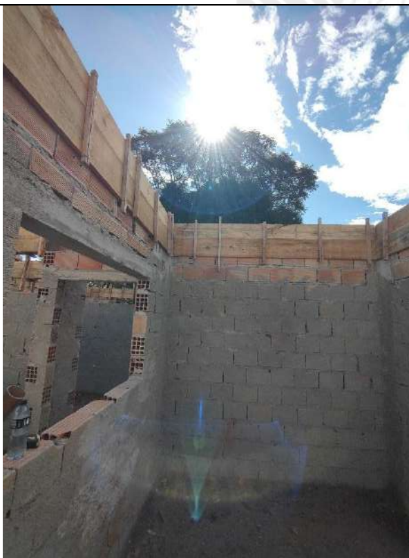
Foto 119 – Concretagem de piso e vigas
