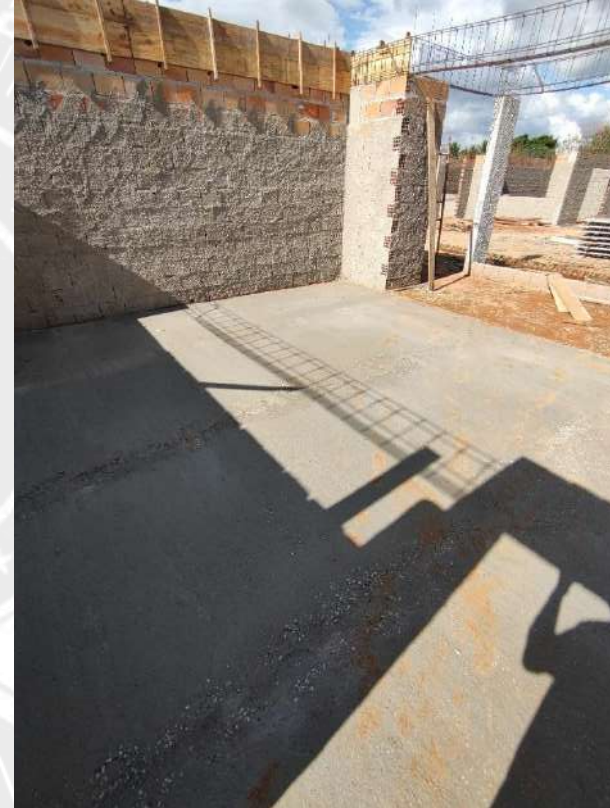
Foto 140 – Concretagem de piso
