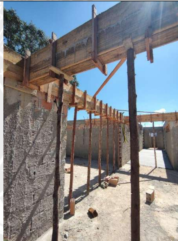
Foto 180 – Concretagem de piso
