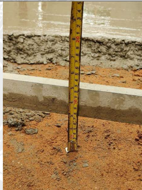
Foto 162 – Concretagem de piso
