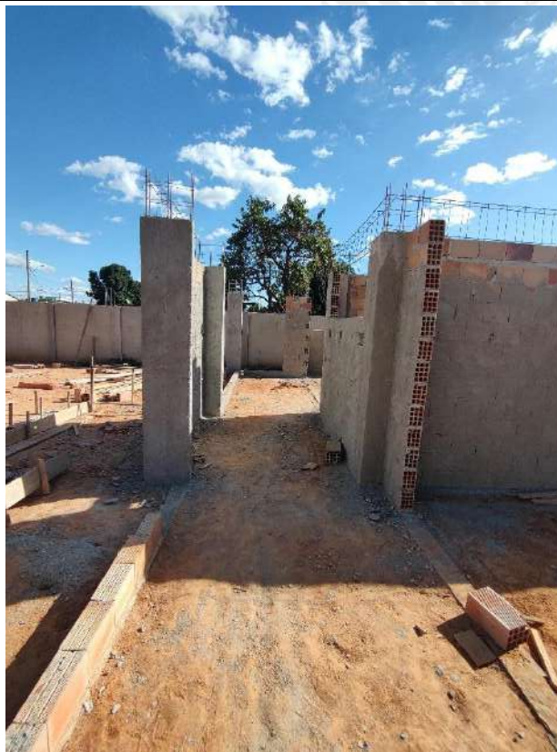
Foto 51 – Armação, forma e concretagem de pilares
