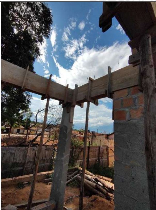
Foto 127 – Armação, forma e concretagem de vigas e cintas
