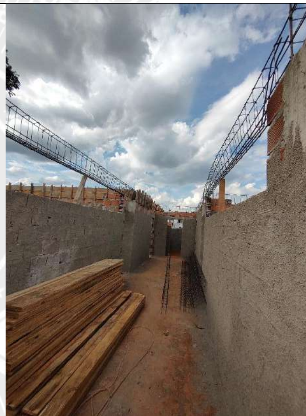
Foto 102 – Armação, forma e concretagem de vigas e cintas
