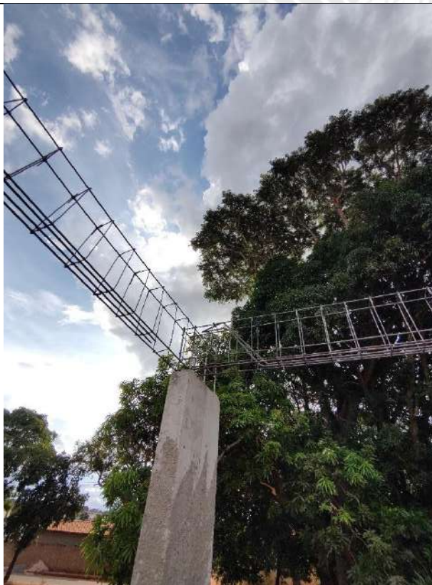
Foto 69 – Armação, forma e concretagem de vigas e cintas
