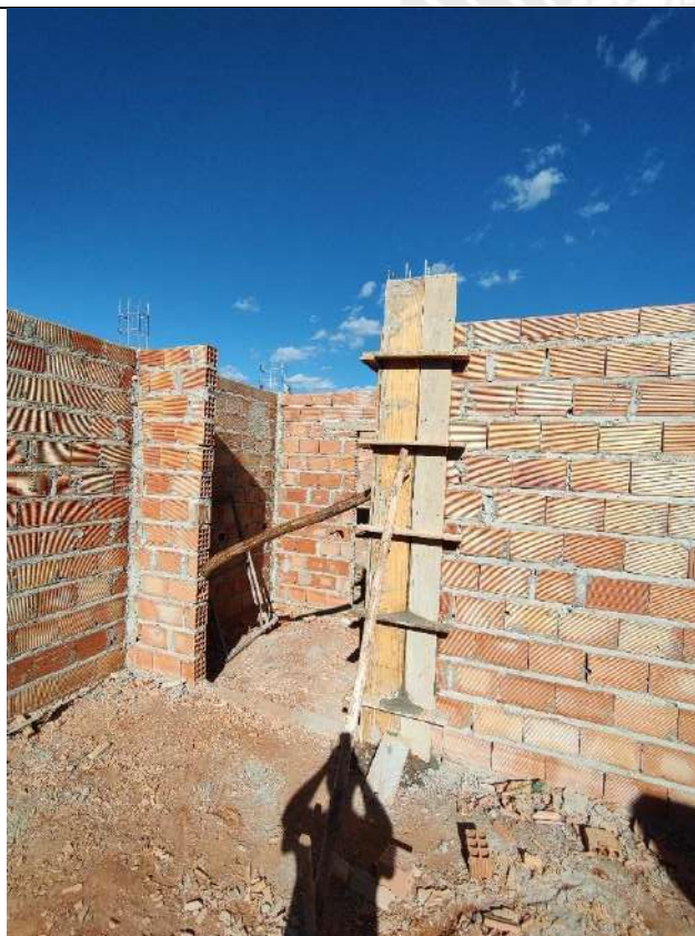
Foto 59 – Armação, forma e concretagem de pilares
