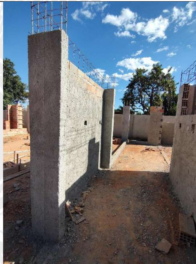
Foto 54 – Armação, forma e concretagem de pilares
