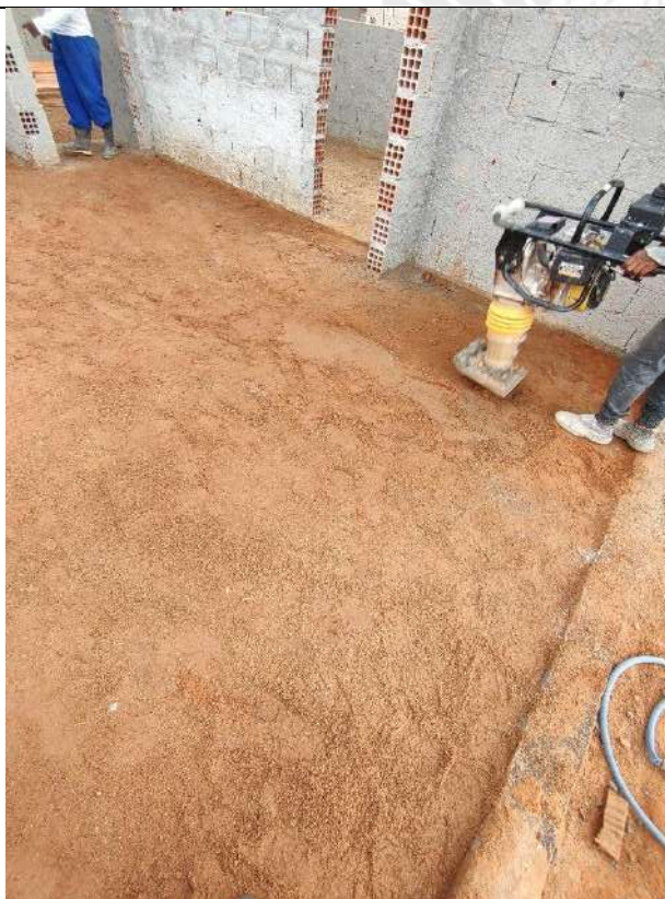
Foto 111 – Acerto compactado de piso
