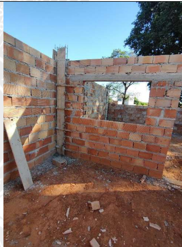
Foto 8 – Armação, forma e concretagem de pilares
