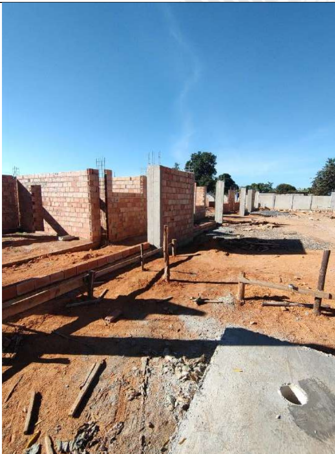
Foto 11 – Armação, forma e concretagem de pilares
