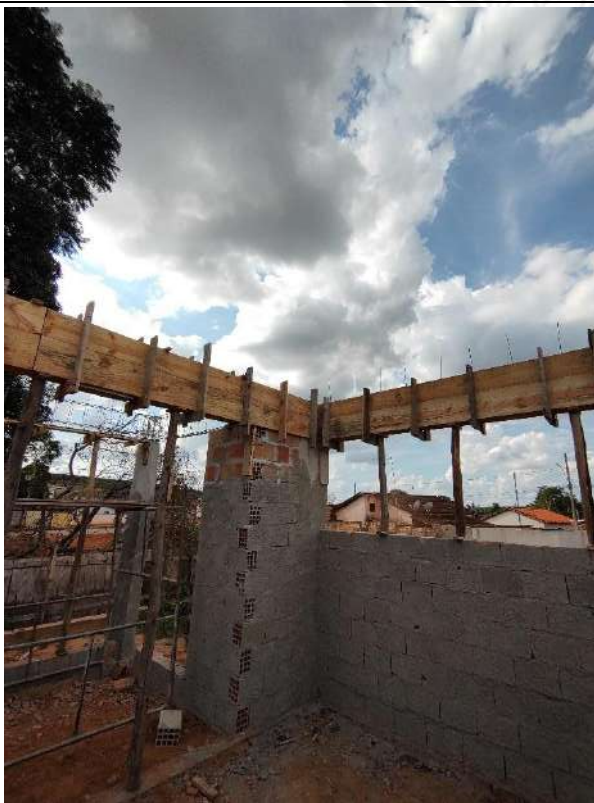
Foto 75 – Armação, forma e concretagem de vigas e cintas
