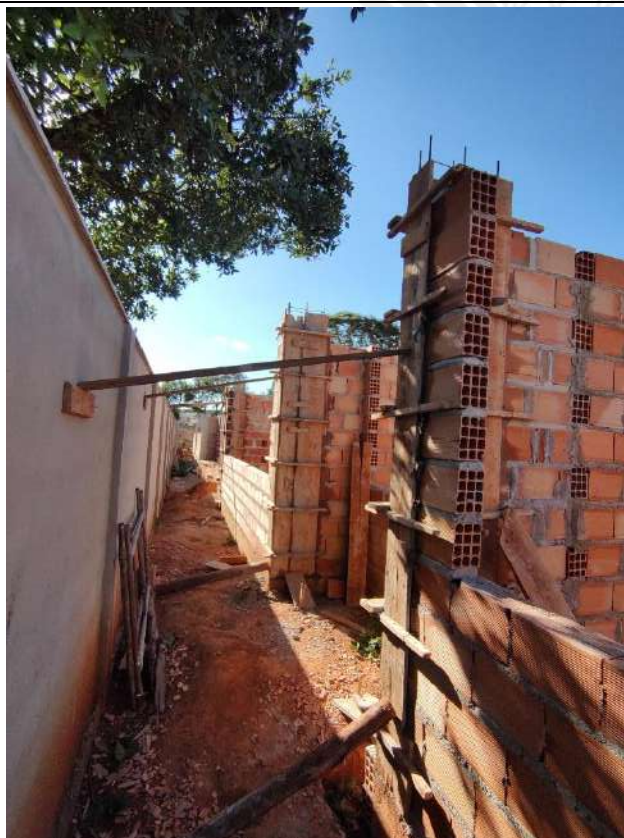
Foto 63 – Armação, forma e concretagem de pilares
