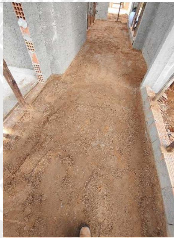
Foto 132 – Acerto compactado de piso
