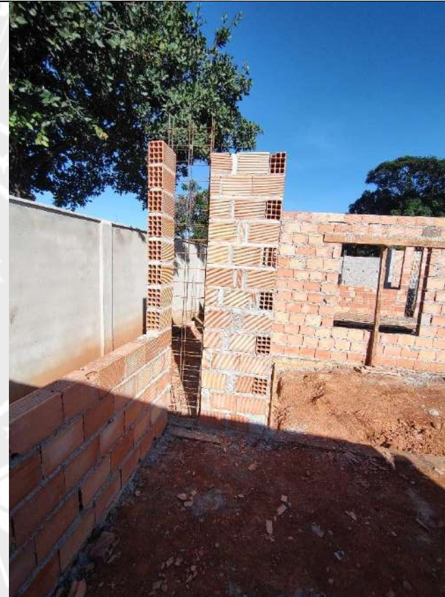
Foto 26 – Armação, forma e concretagem de pilares
