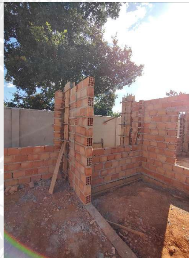
Foto 58 – Armação, forma e concretagem de pilares
