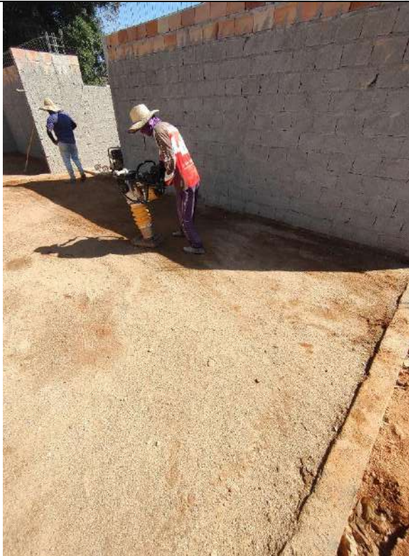
Foto 67 – Acerto compactado de piso
