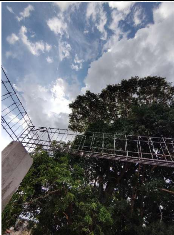
Foto 71 – Armação, forma e concretagem de vigas e cintas
