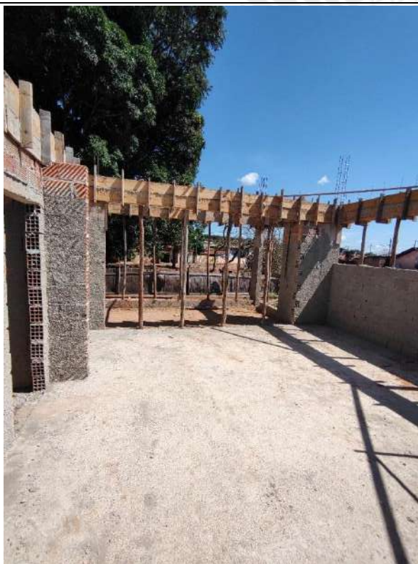
Foto 161 – Armação, forma e concretagem de vigas e cintas
