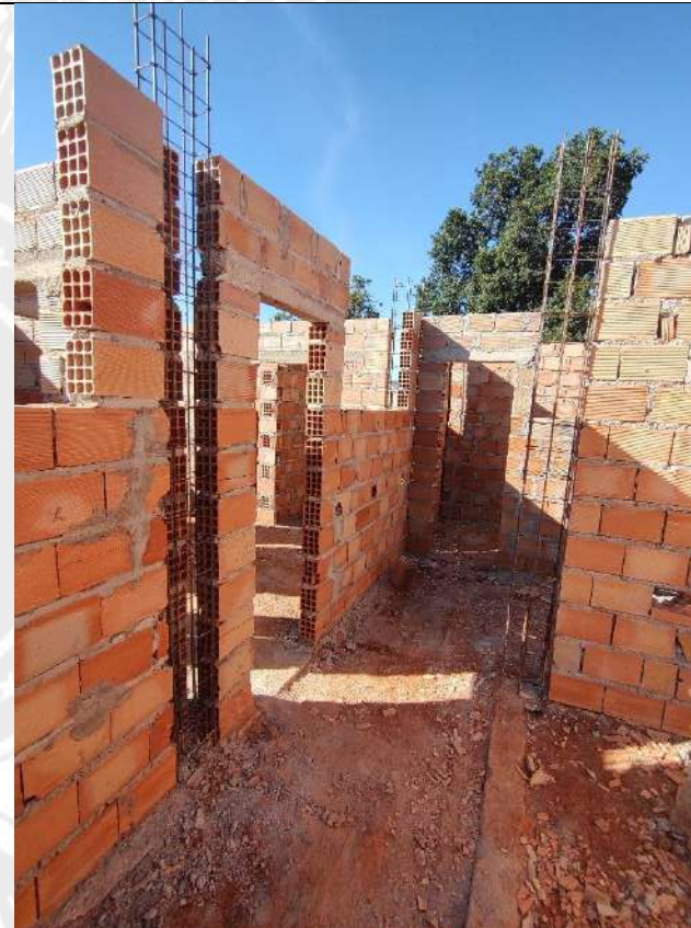
Foto 18 – Armação, forma e concretagem de pilares
