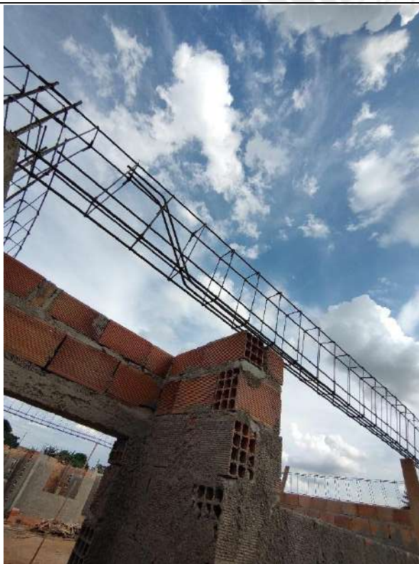
Foto 87 – Armação, forma e concretagem de vigas e cintas
