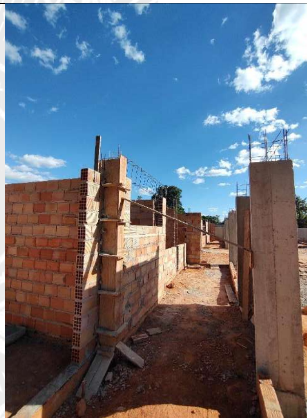
Foto 56 – Armação, forma e concretagem de pilares
