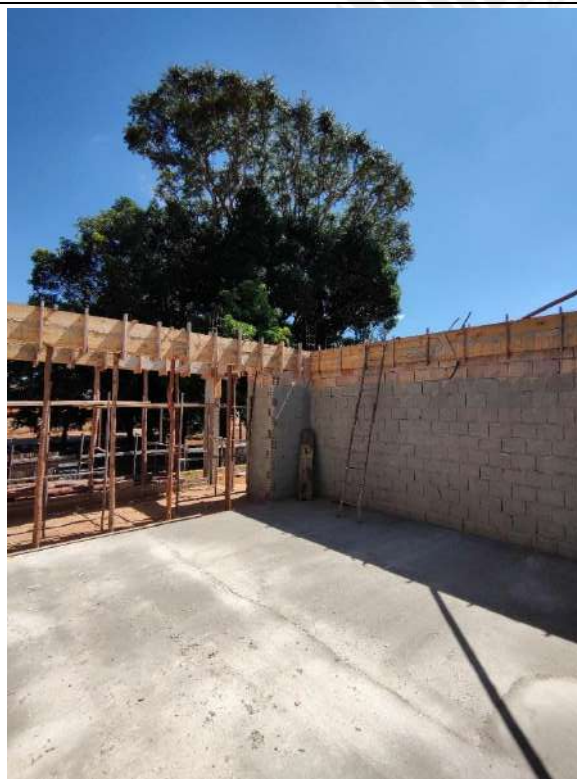
Foto 179 – Concretagem de piso
