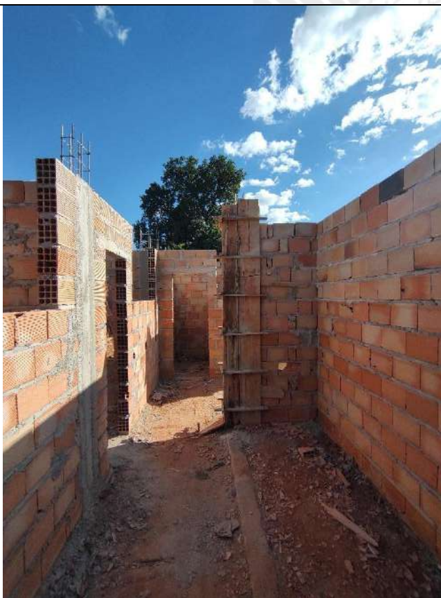
Foto 57 – Armação, forma e concretagem de pilares
