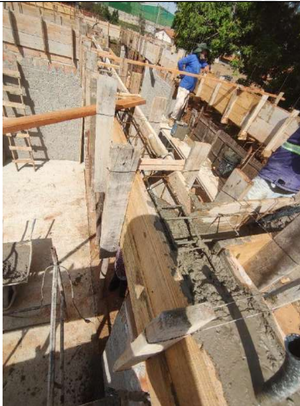
Foto 159 – Armação, forma e concretagem de vigas e cintas
