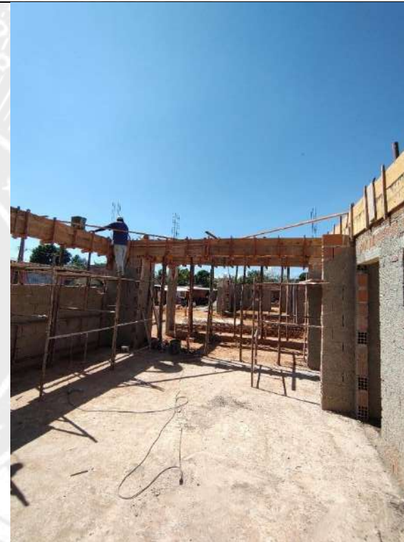
Foto 160 – Armação, forma e concretagem de vigas e cintas
