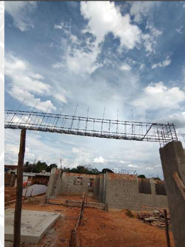
Foto 92 – Armação, forma e concretagem de vigas e cintas
