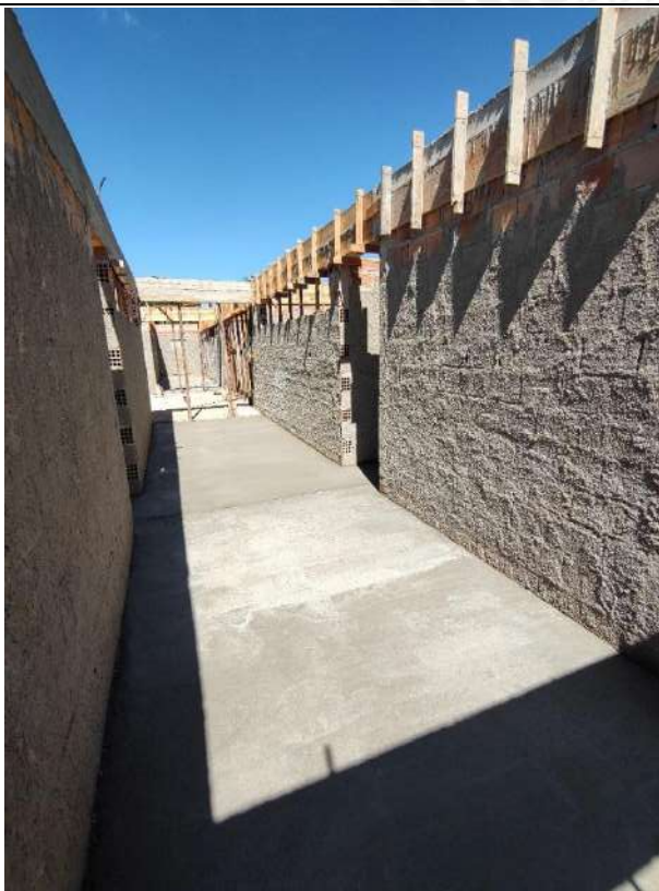
Foto 177 – Concretagem de piso
