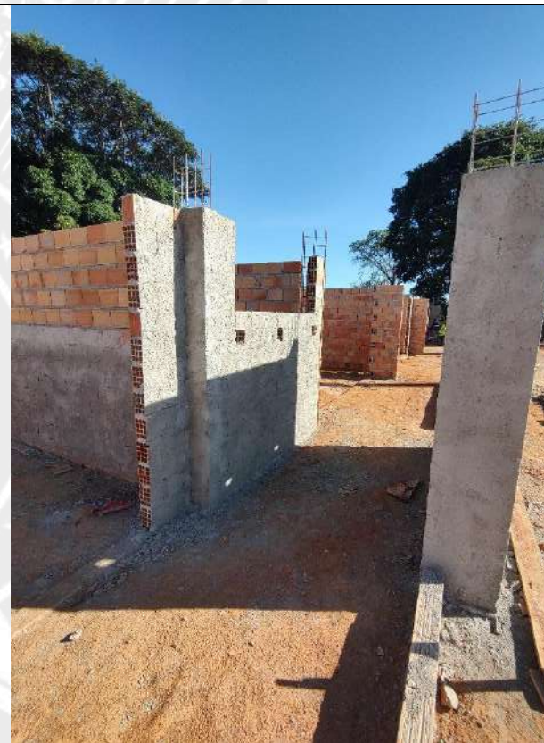
Foto 4 - Armação, forma e concretagem de pilares
