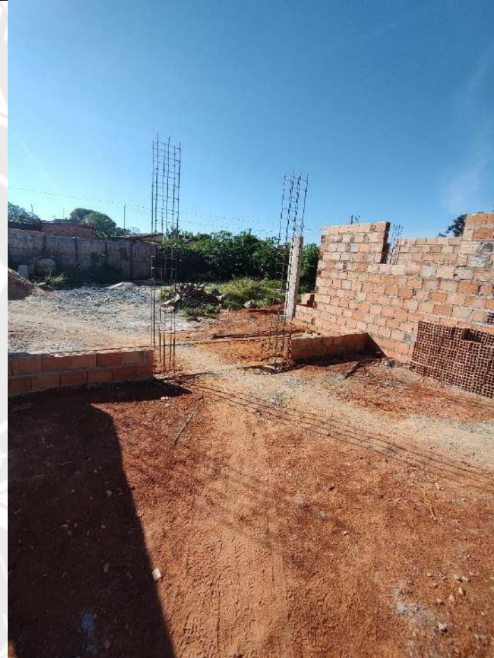
Foto 16 – Armação, forma e concretagem de pilares
