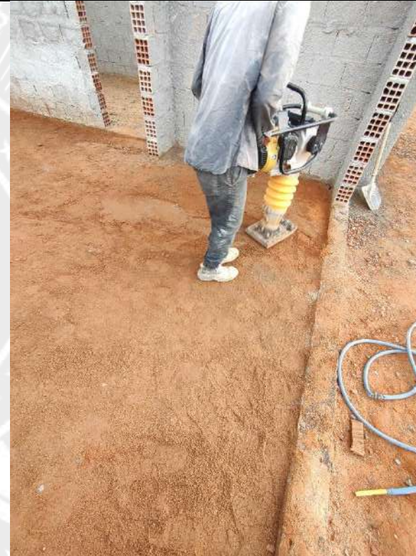
Foto 110 – Acerto compactado de piso
