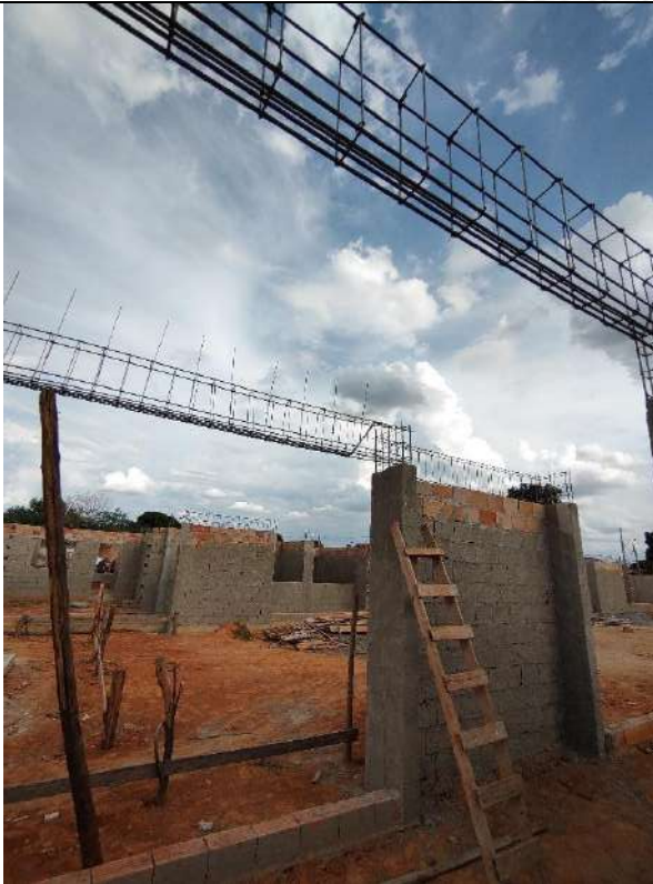
Foto 91 – Armação, forma e concretagem de vigas e cintas
