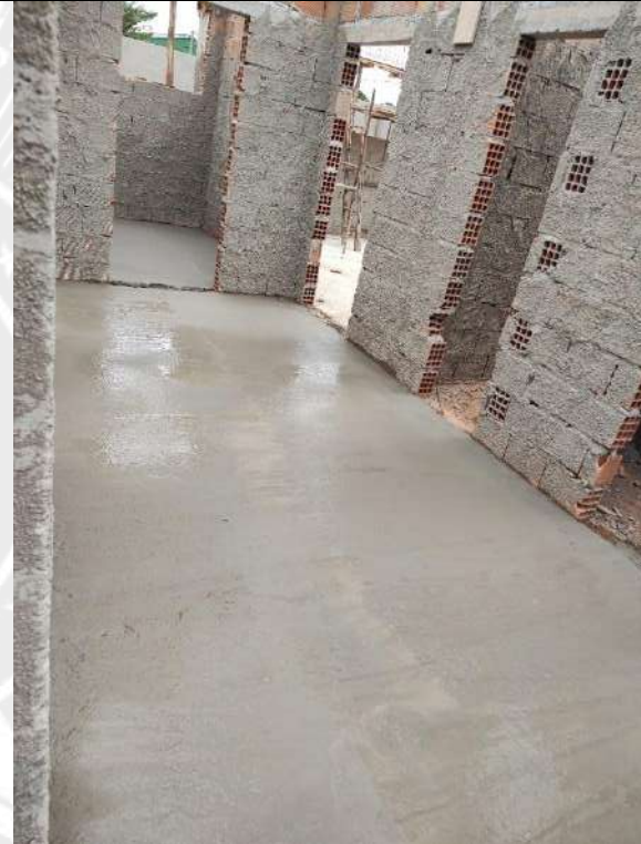
Foto 164 – Concretagem de piso
