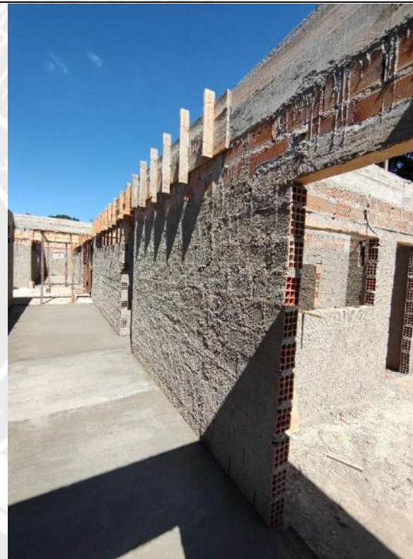
Foto 176 – Concretagem de piso
