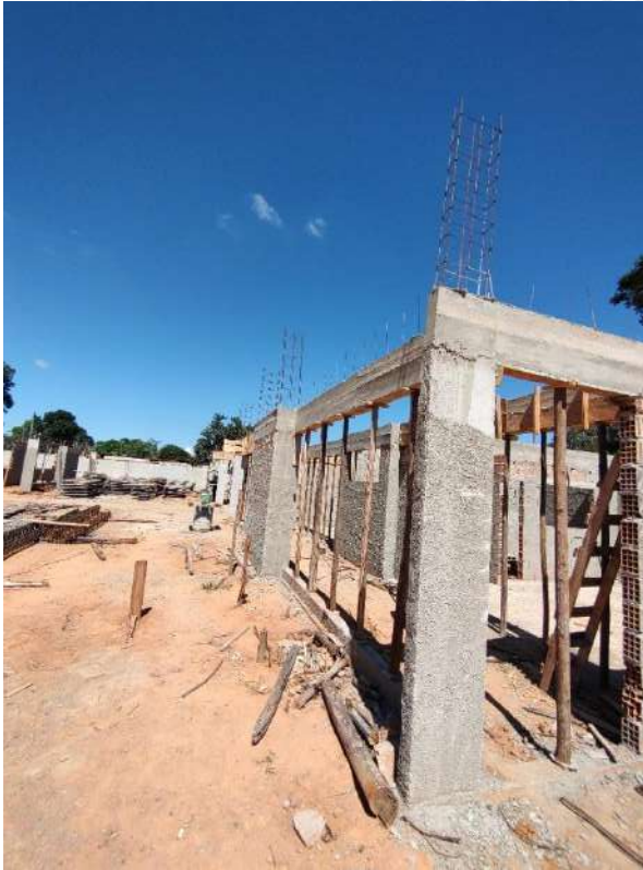
Foto 173 – Armação, forma e concretagem de vigas e cintas
