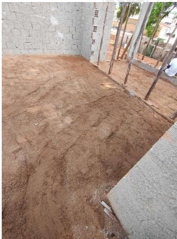
Foto 133 – Acerto compactado de piso
