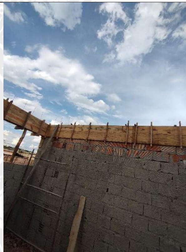
Foto 80 – Armação, forma e concretagem de vigas e cintas
