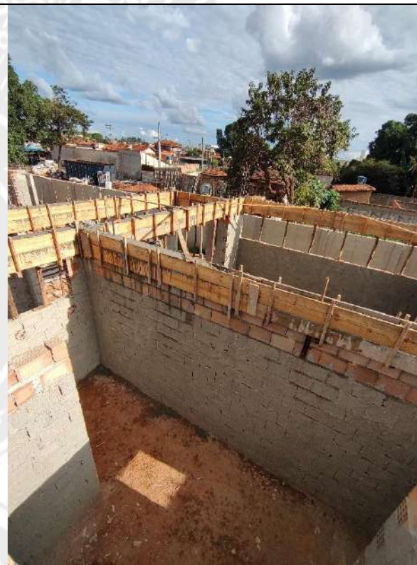
Foto 186 – Concretagem de vigas e cintas
