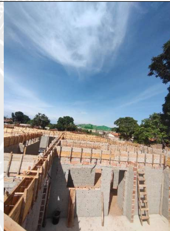
Foto 158 – Armadura, forma e concretagem de vigas e cintas
