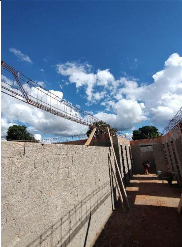
Foto 137 – Armação, forma e concretagem de vigas e cintas
