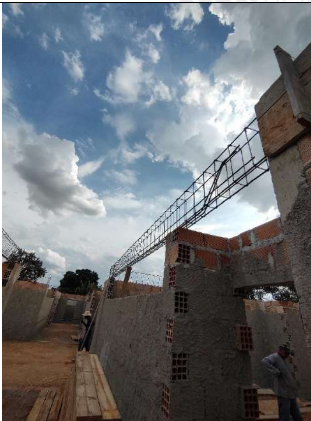
Foto 85 – Armação, forma e concretagem de vigas e cintas
