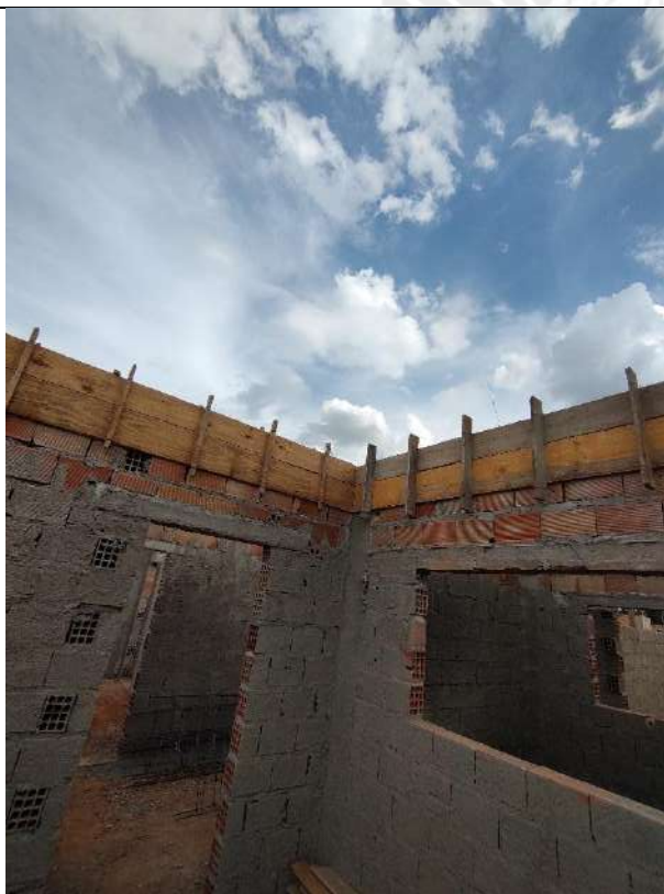
Foto 79 – Armação, forma e concretagem de vigas e cintas
