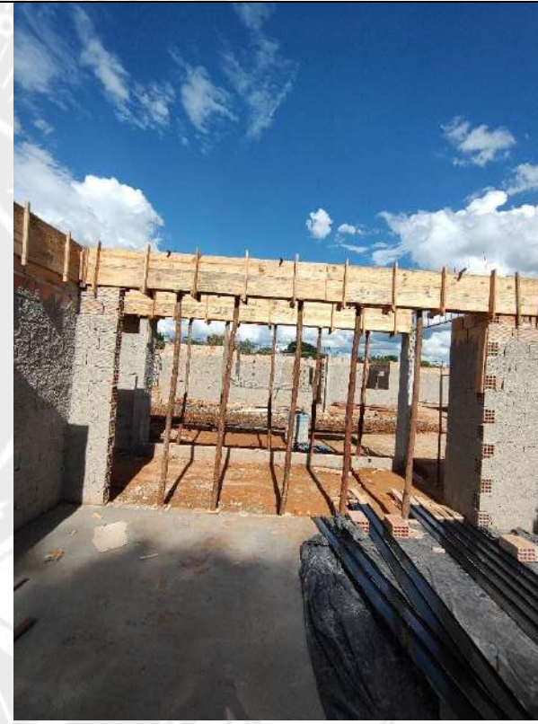
Foto 116 – Concretagem de piso e vigas
