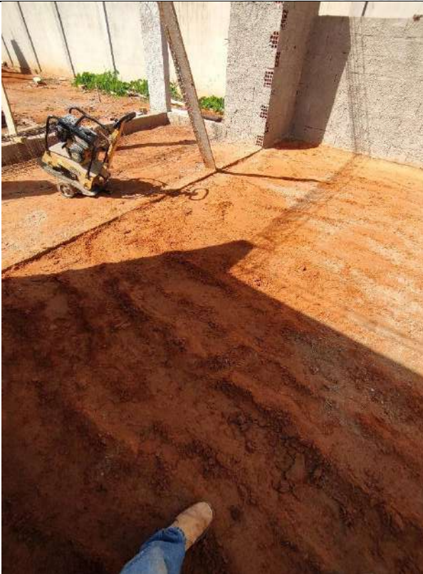
Foto 115 – Acerto compactado de piso
