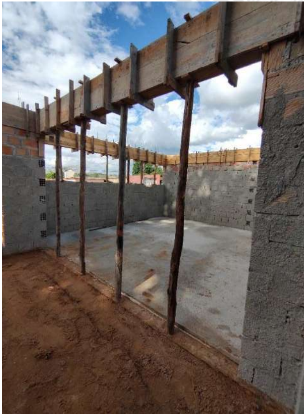
Foto 143 – Armação, forma e concretagem de vigas e cintas
