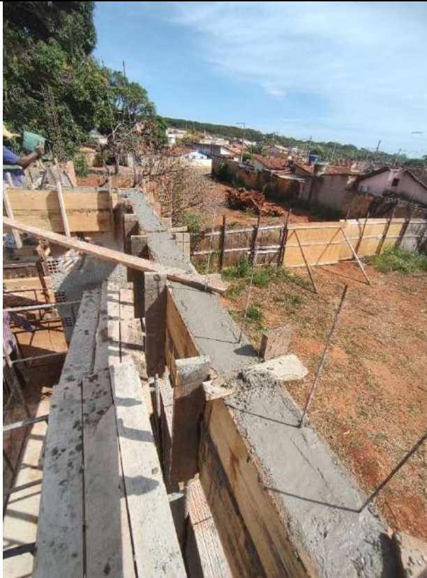
Foto 155 – Armação, forma e concretagem de vigas e cintas
