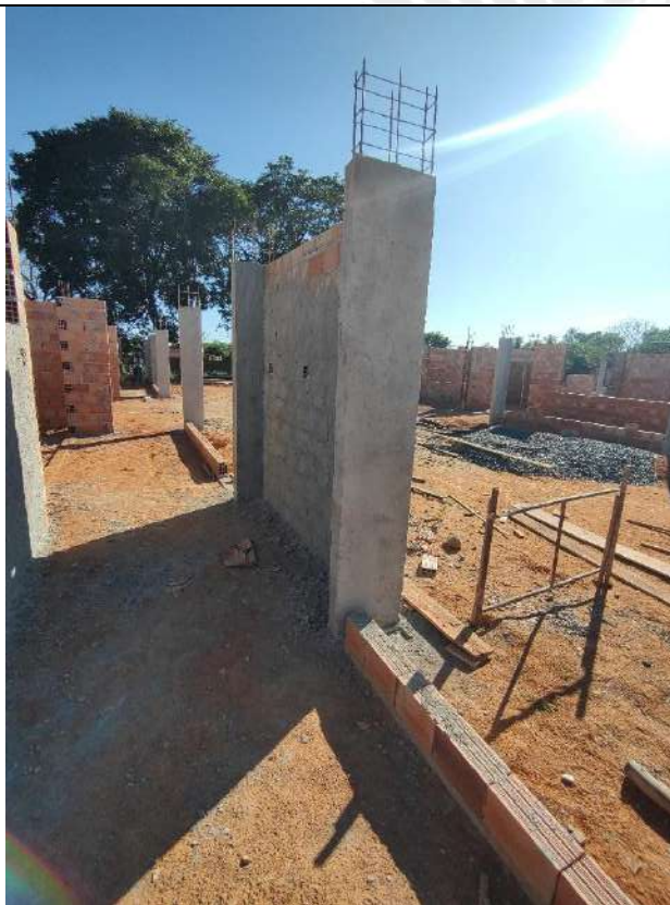
Foto 3 - Armação, forma e concretagem de pilares
