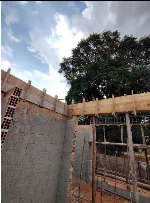
Foto 77 – Armação, forma e concretagem de vigas e cintas
