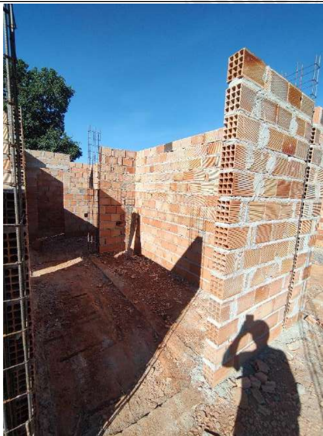
Foto 17 - Armação, forma e concretagem de pilares
