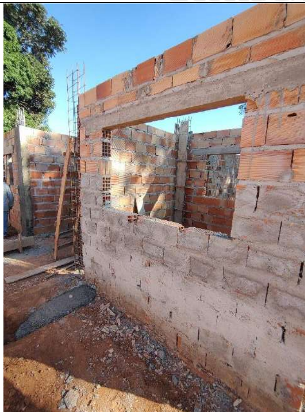
Foto 9 – Armação, forma e concretagem de pilares
