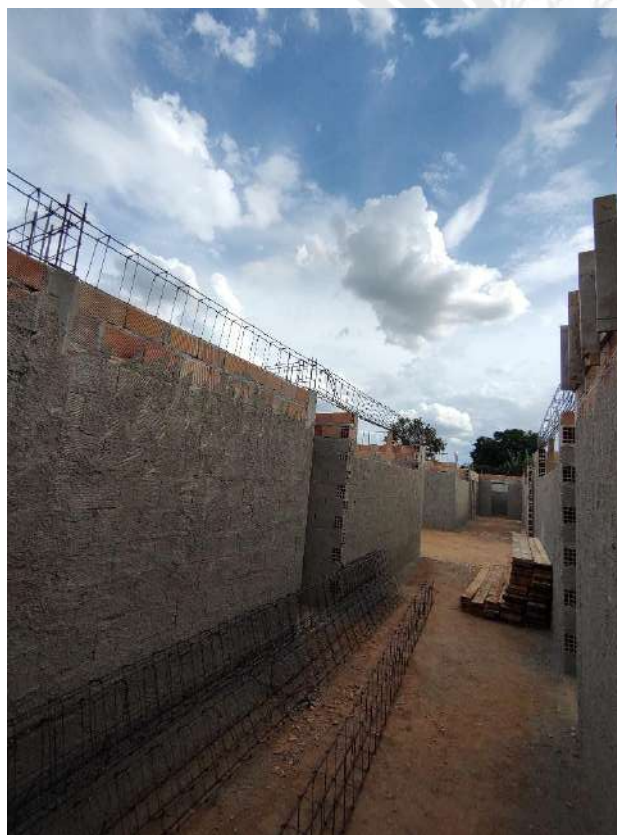
Foto 83 – Armação, forma e concretagem de vigas e cintas
