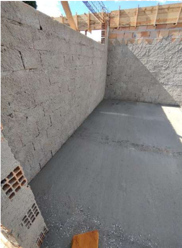
Foto 139 – Concretagem de piso
