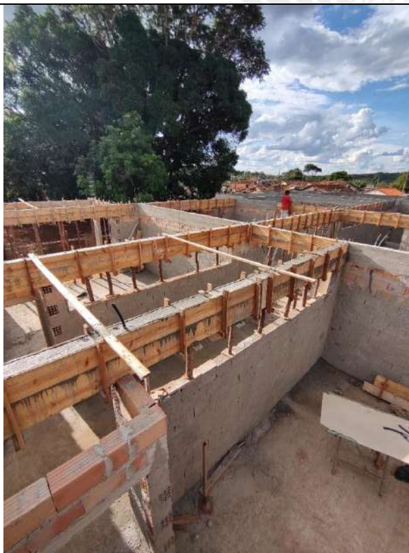
Foto 185 – Concretagem de vigas e cintas
