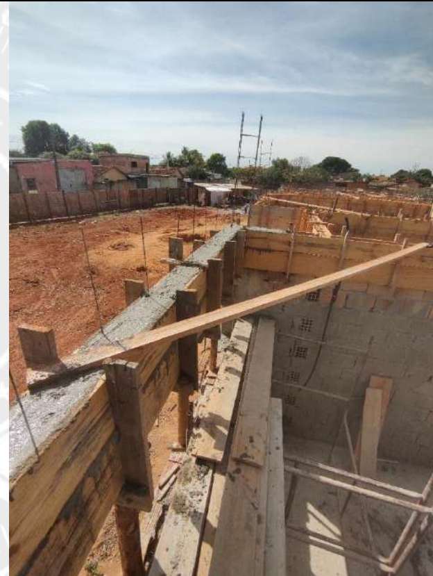
Foto 156 – Armação, forma e concretagem de vigas e cintas
