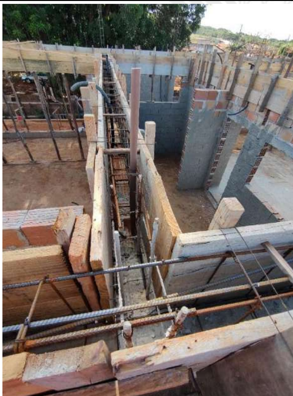
Foto 151 – Armação, forma e concretagem de vigas e cintas
