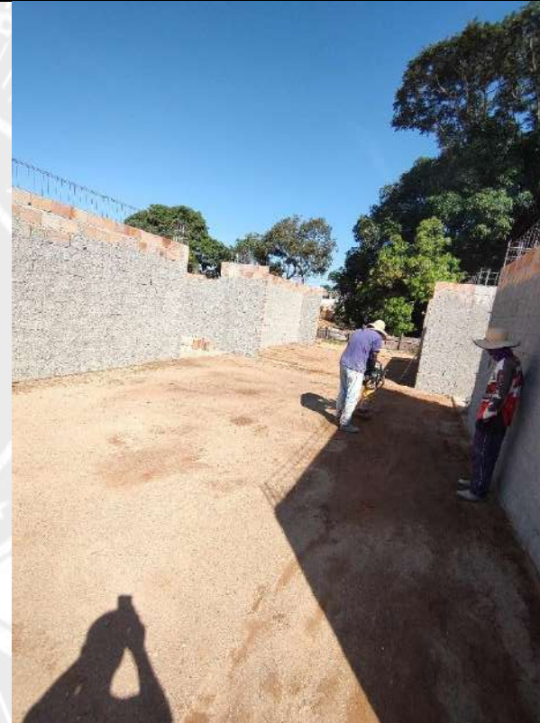
Foto 66 – Acerto compactado de piso
