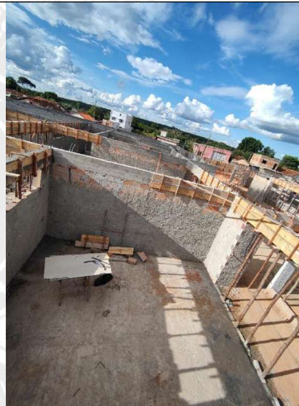
Foto 184 – Concretagem de vigas e cintas
