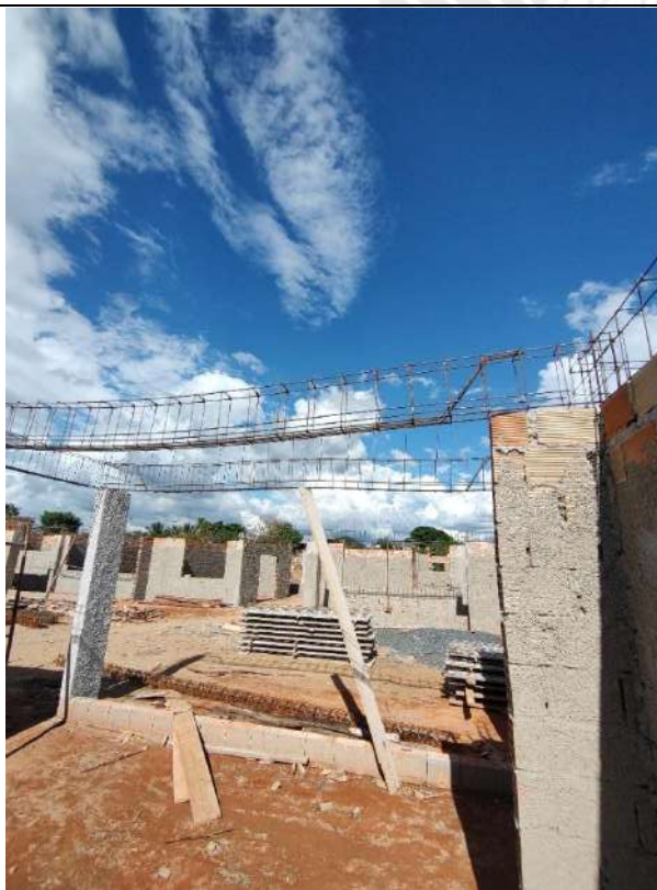
Foto 141 – Armação, forma e concretagem de vigas e cintas
