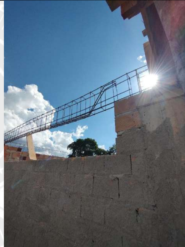
Foto 138 – Armação, forma e concretagem de vigas e cintas
