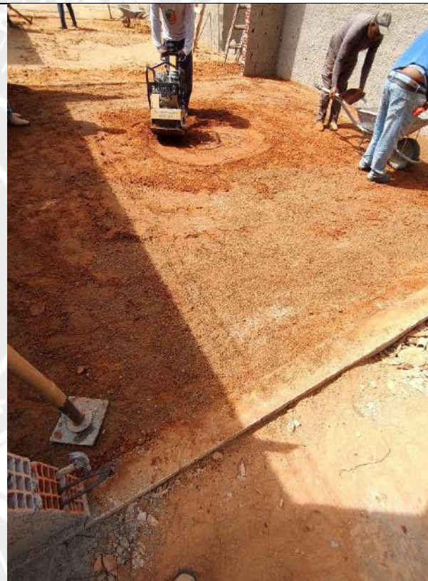
Foto 104 – Acerto compactado de piso
