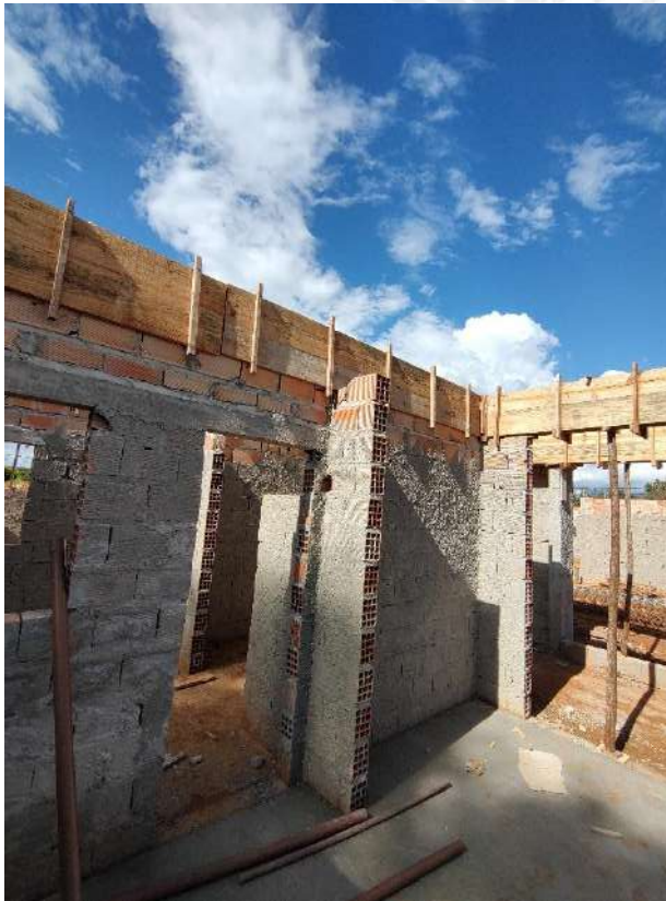
Foto 117 – Concretagem de piso e vigas
