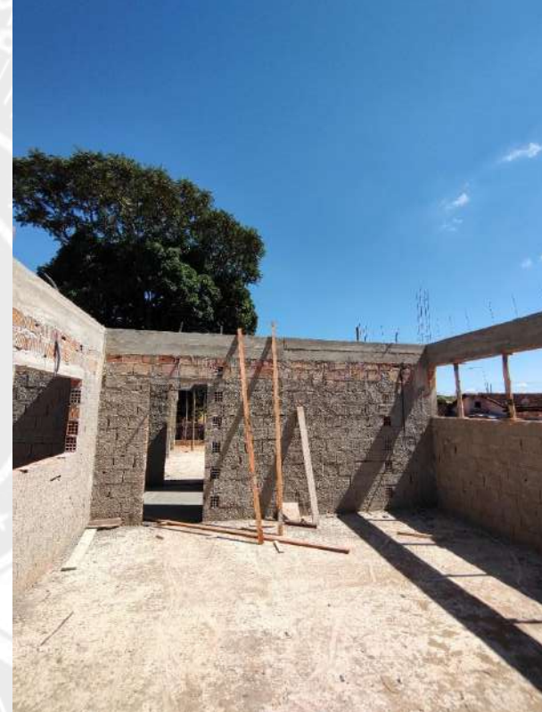
Foto 174 – Concretagem de piso
