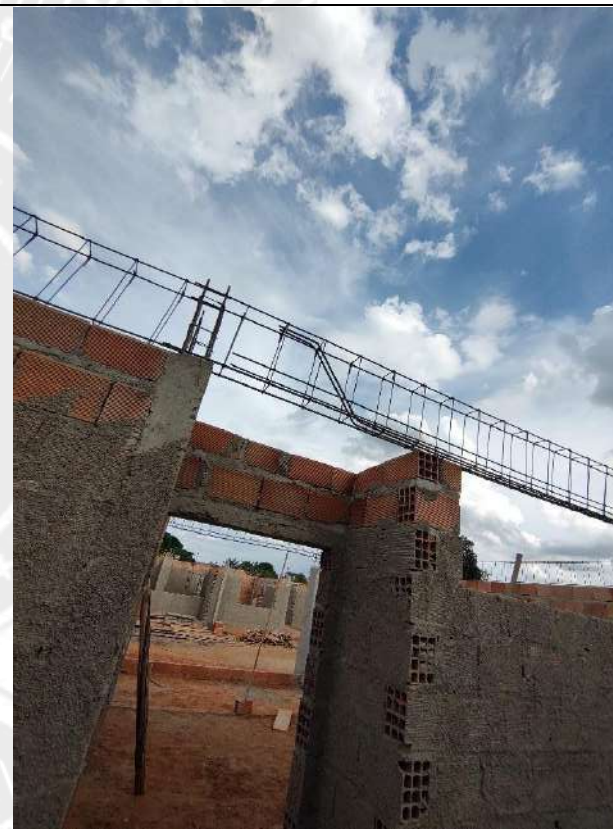
Foto 86 – Armação, forma e concretagem de vigas e cintas
