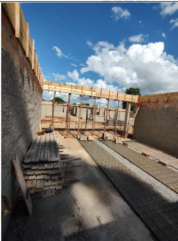
Foto 135 – Armação, forma e concretagem de vigas e cintas
