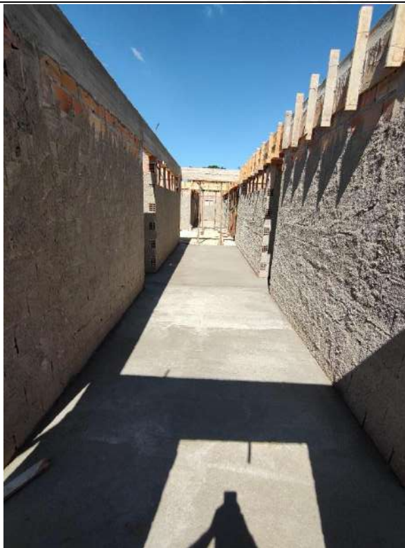
Foto 175 – Concretagem de piso
