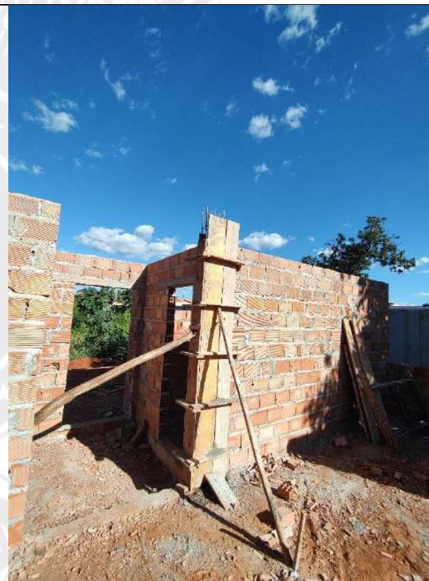
Foto 60 – Armação, forma e concretagem de pilares
