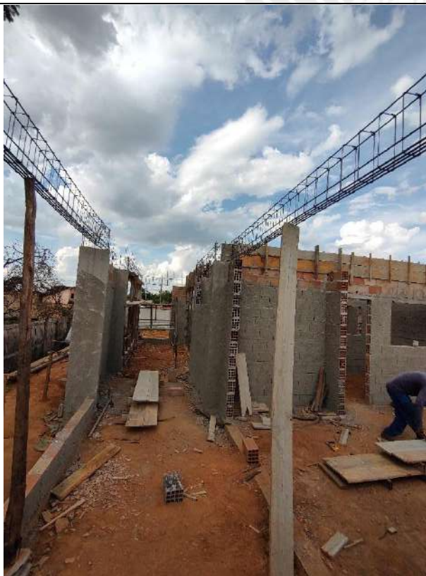
Foto 103 – Armação, forma e concretagem de vigas e cintas
