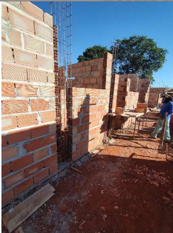
Foto 29 – Armação, forma e concretagem de pilares
