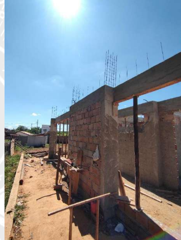
Foto 170 – Armação, forma e concretagem de vigas e cintas
