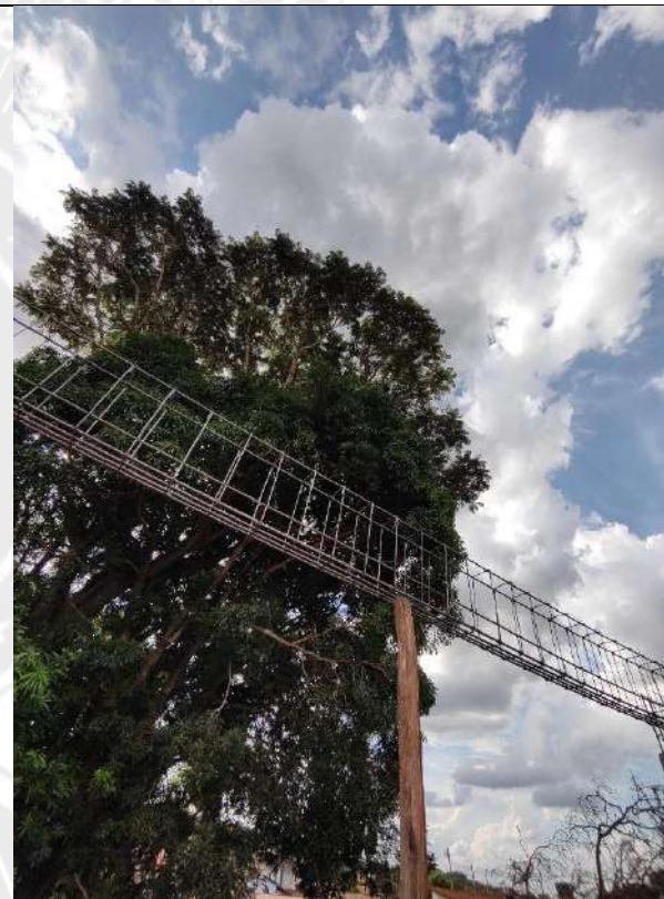
Foto 70 – Armação, forma e concretagem de vigas e cintas
