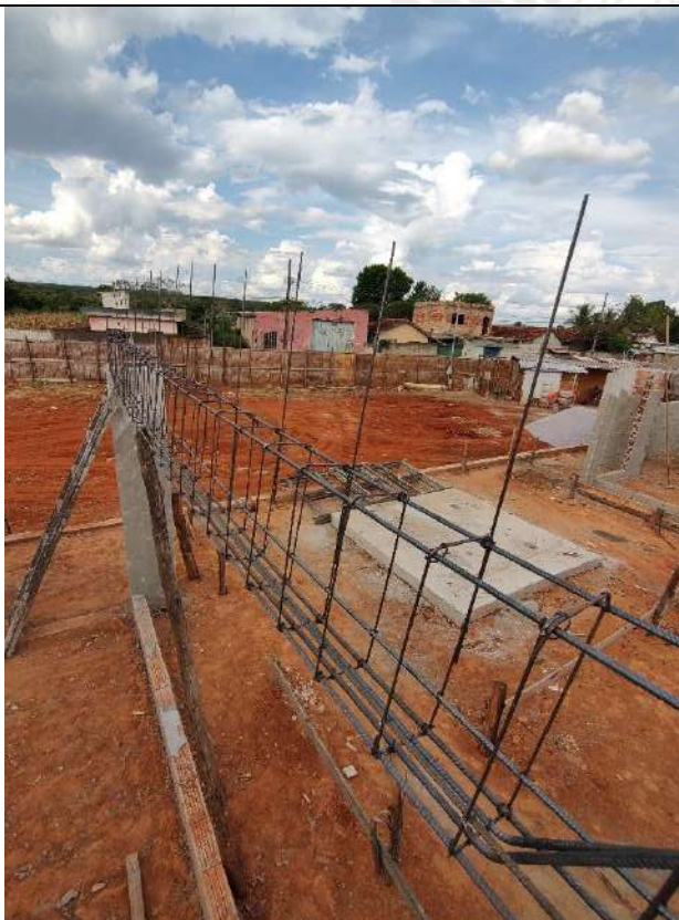
Foto 97 – Armção, forma e concretagem de vigas e cintas
