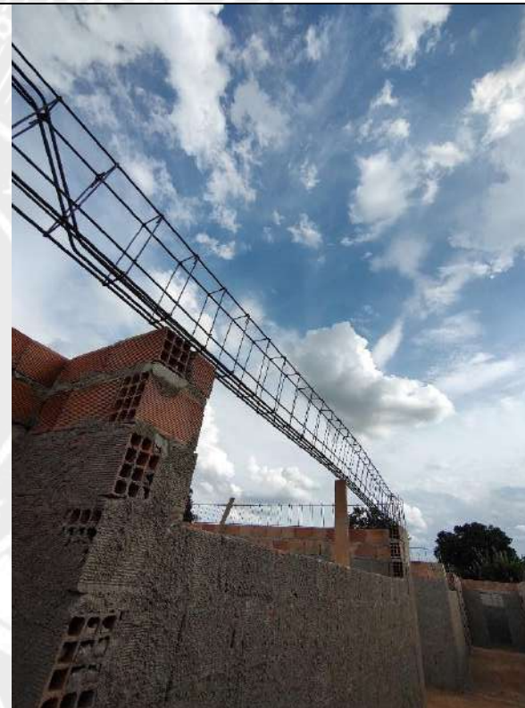
Foto 88 – Armação, forma e concretagem de vigas e cintas
