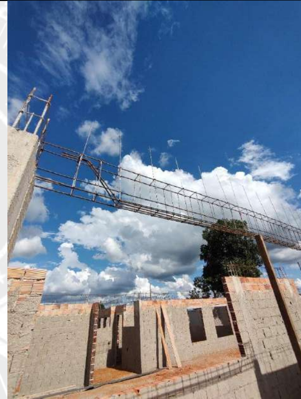
Foto 150 – Armação, forma e concretagem de vigas e cintas
