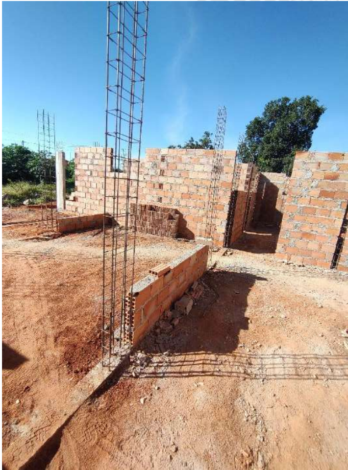
Foto 15 - Armação, forma e concretagem de pilares
