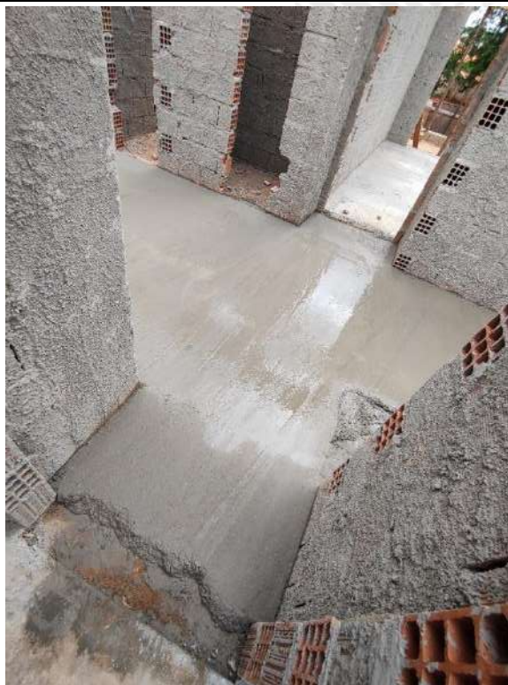
Foto 165 – Concretagem de piso
