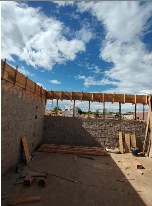
Foto 121 – Concretagem de piso e vigas
