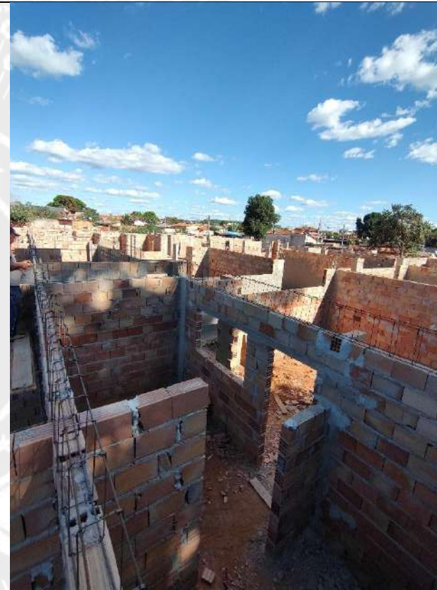
Foto 34 – Armação, forma e concretagem de cintas
