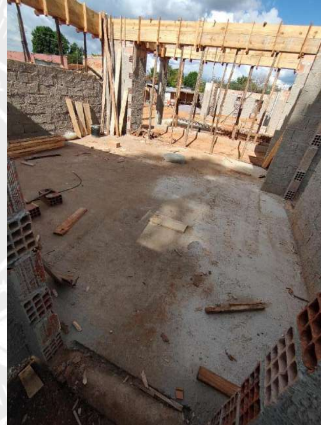
Foto 144 – Armação, forma e concretagem de vigas e cintas
