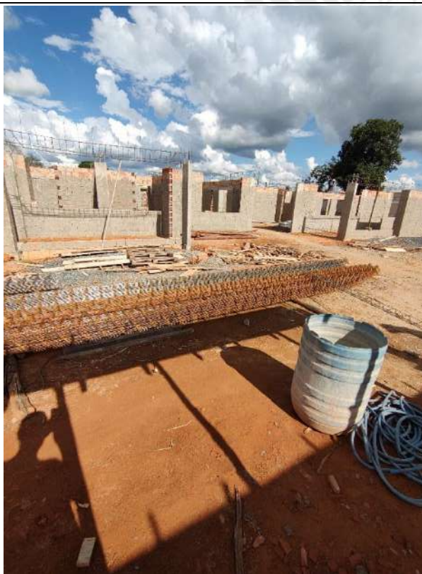
Foto 147 – Armação, forma e concretagem de vigas e cintas
