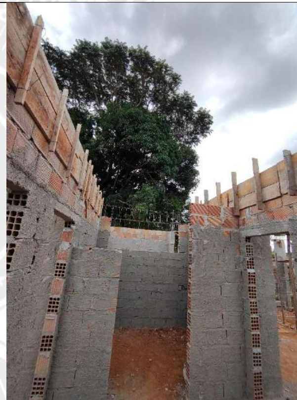
Foto 82 – Armação, forma e concretagem de vigas e cintas
