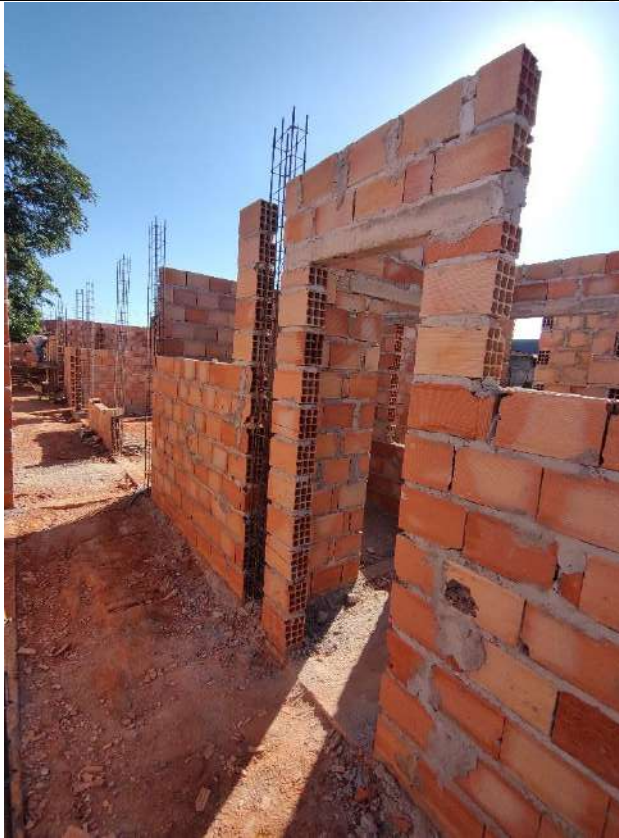
Foto 19 – Armação, forma e concretagem de pilares
