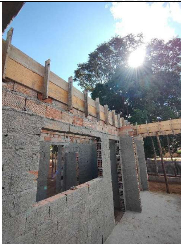
Foto 125 – Armação, forma e concretagem de vigas e cintas
