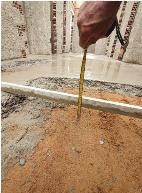
Foto 163 – Concretagem de piso
