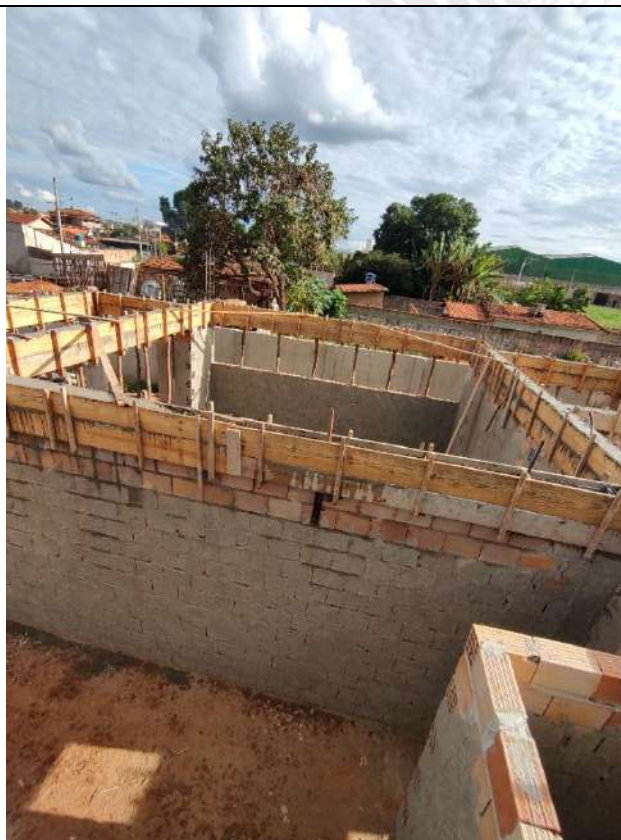
Foto 181 – Concretagem de vigas e cintas
