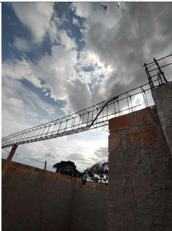
Foto 101 – Armação, forma e concretagem de vigas e cintas
