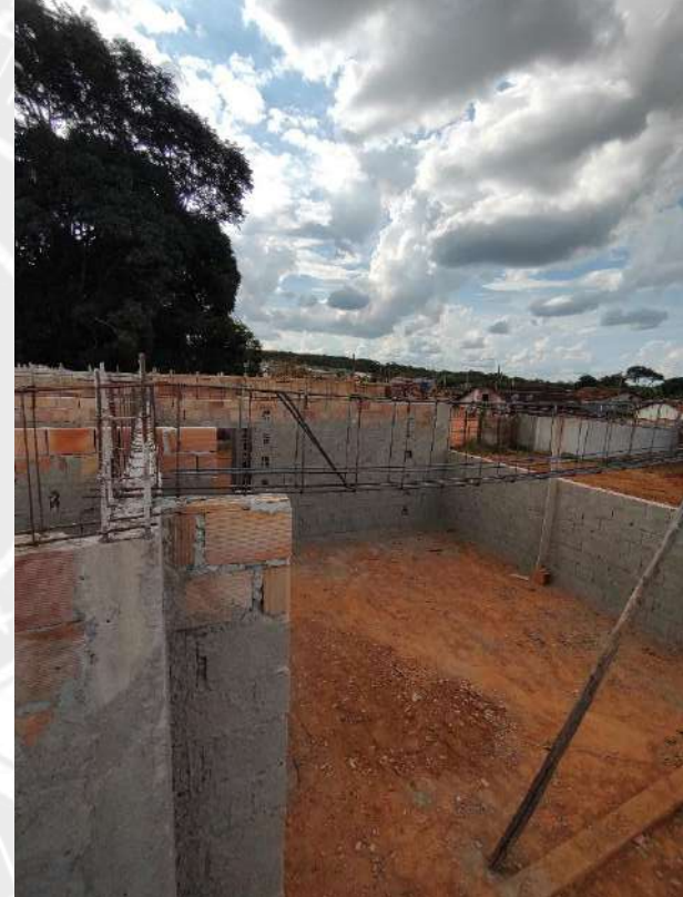
Foto 100 – Armação, forma e concretagem de vigas e cintas
