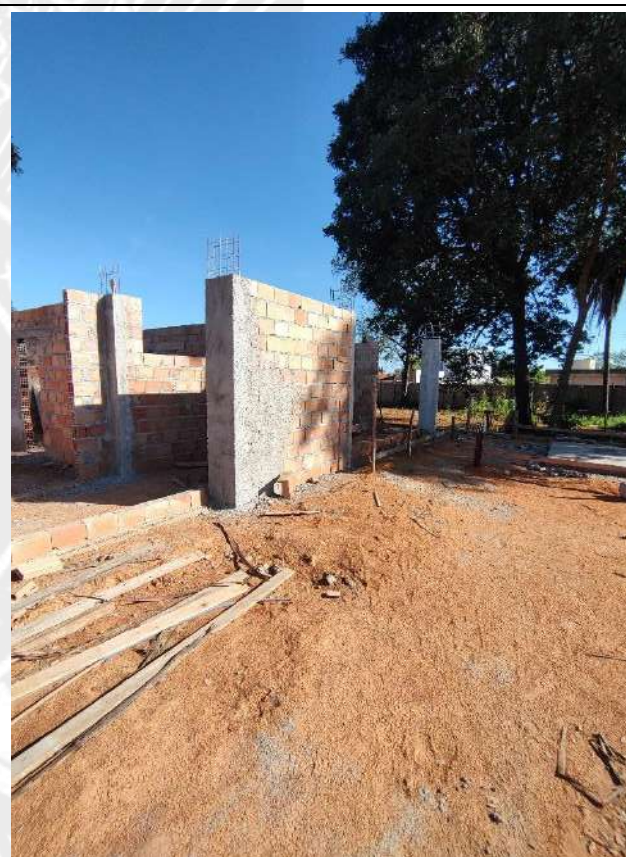
Foto 6 - Armação, forma e concretagem de pilares
