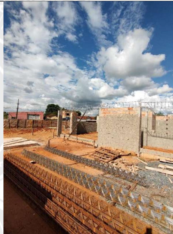
Foto 148 – Armação, forma e concretagem de vigas e cintas
