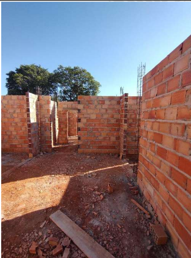
Foto 25 – Armação, forma e concretagem de pilares
