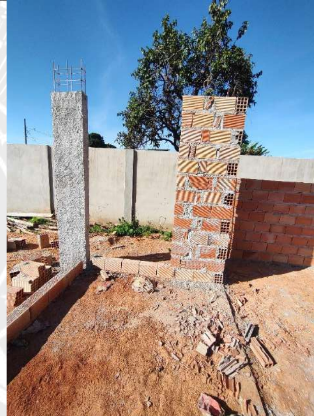
Foto 2 – Armação, forma e concretagem de pilares
