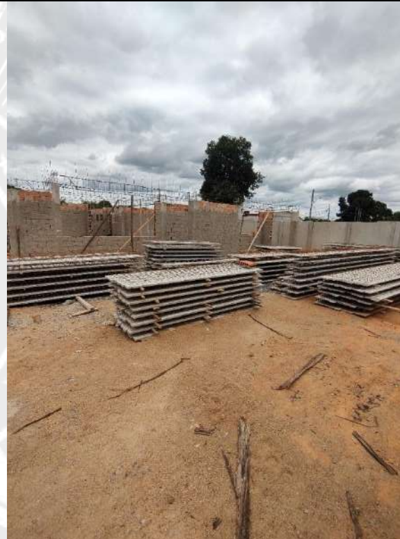
Foto 166 – Execução de vigotas de laje
