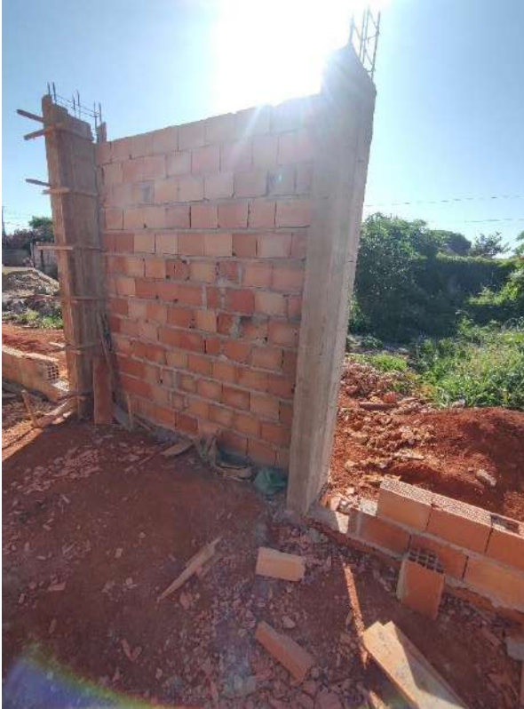
Foto 27 – Armação, forma e concretagem de pilares
