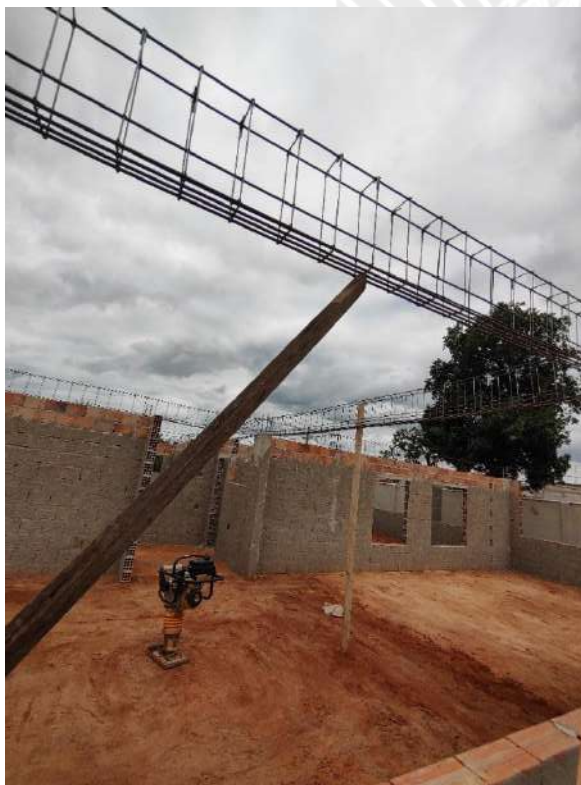
Foto 167 – Acerto compactado de piso
