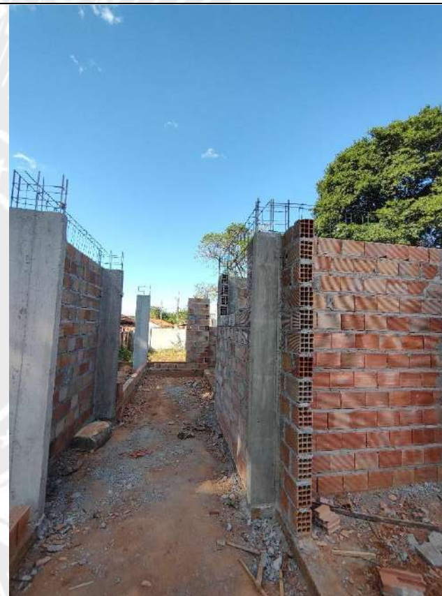
Foto 38 - Armação, forma e concretagem de pilares
