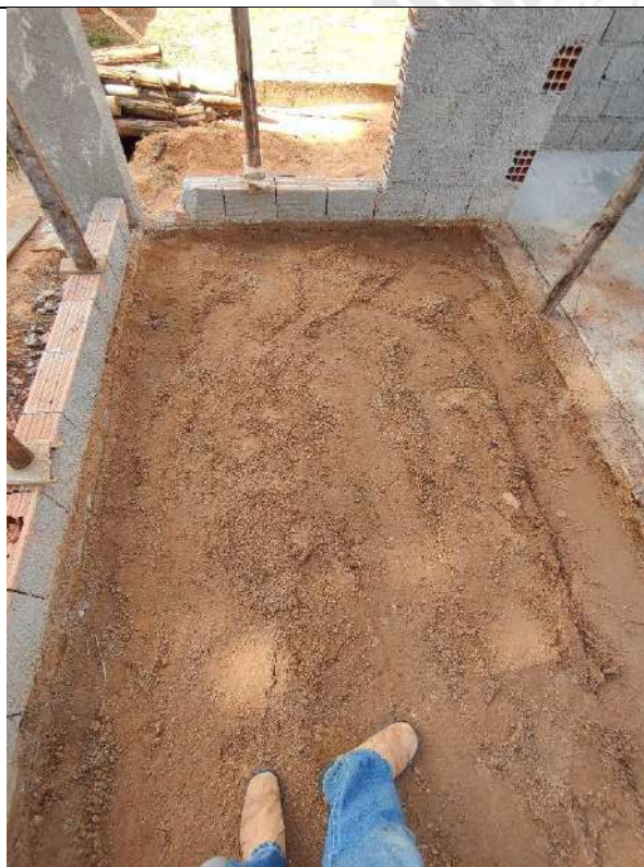
Foto 131 – Acerto compactado de piso
