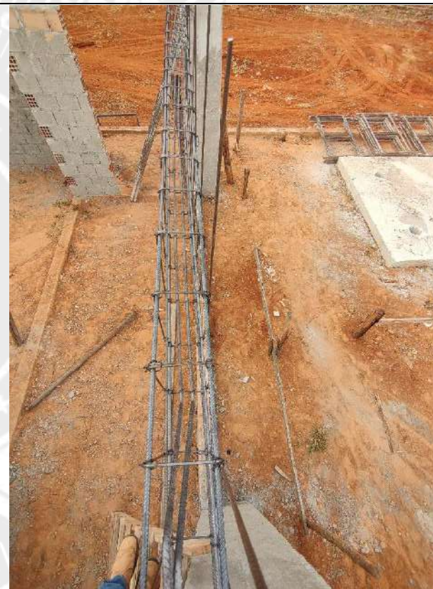
Foto 98 – Armção, forma e concretagem de vigas e cintas
