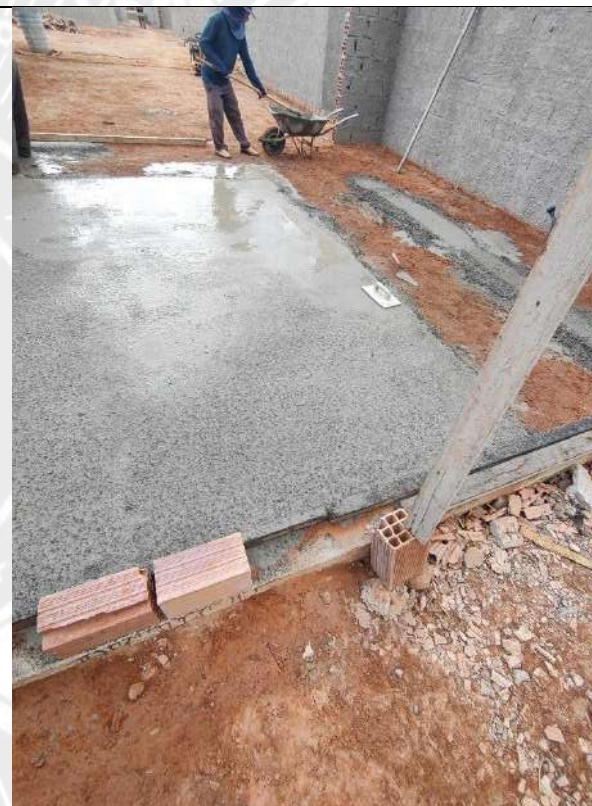
Foto 108 – Concretagem de piso
