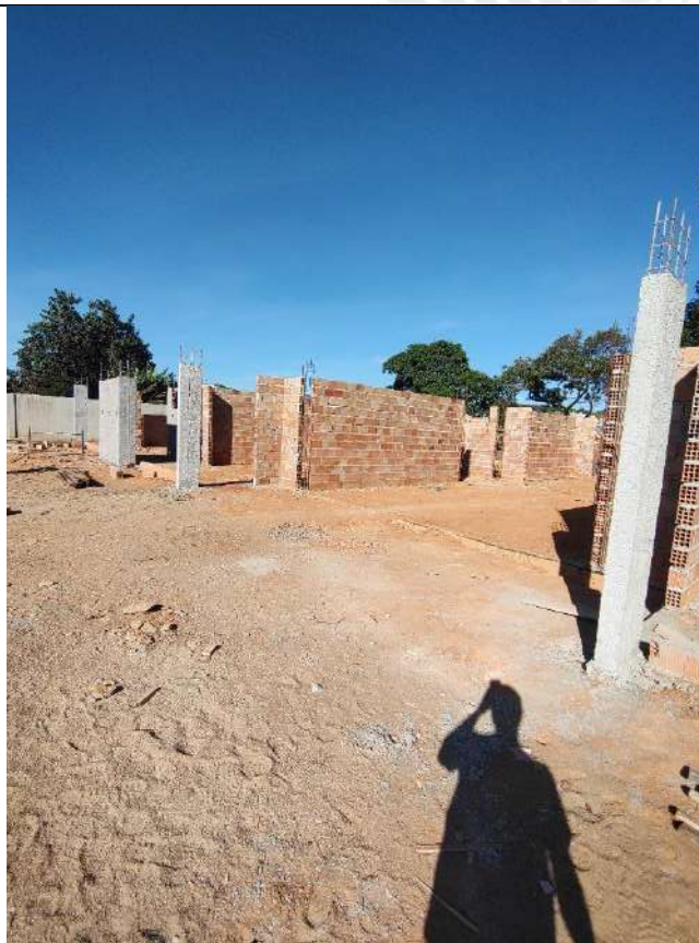
Foto 5 - Armação, forma e concretagem de pilares
