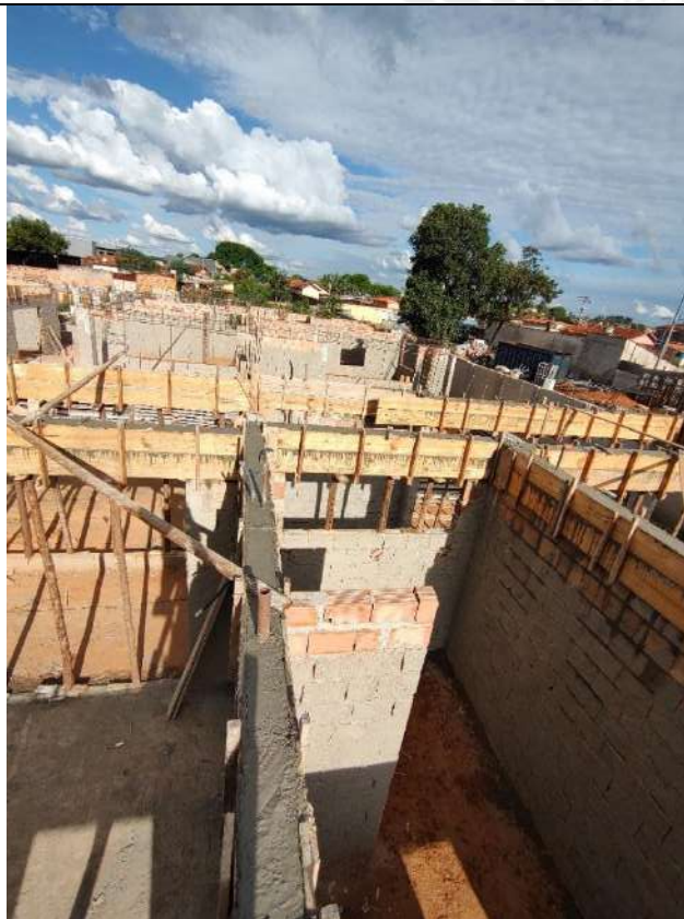
Foto 183 – Concretagem de vigas e cintas
