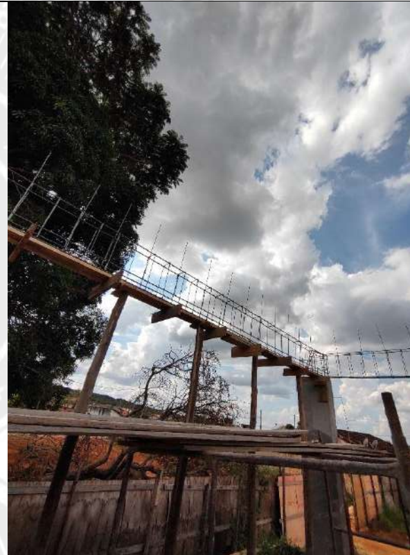
Foto 72 – Armação, forma e concretagem de vigas e cintas
