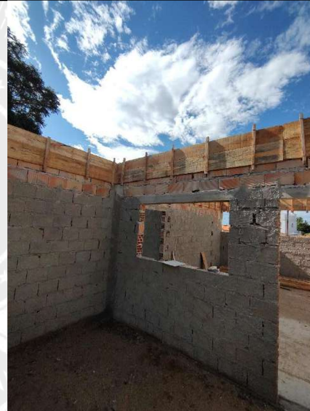
Foto 118 – Concretagem de piso e vigas
