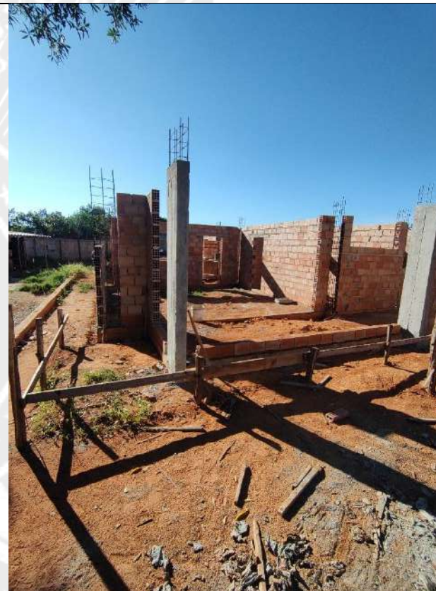
Foto 10 – Armação, forma e concretagem de pilares
