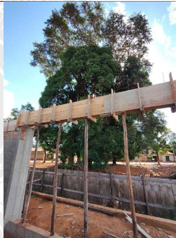
Foto 128 – Armação, forma e concretagem de vigas e cintas
