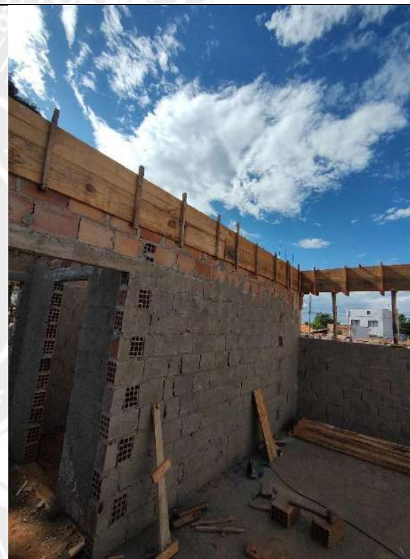
Foto 120 – Concretagem de piso e vigas
