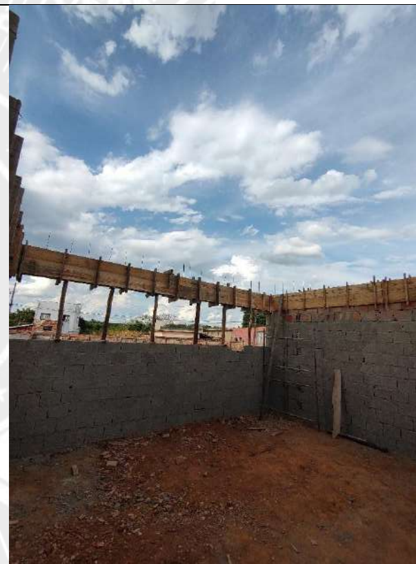
Foto 74 – Armação, forma e concretagem de vigas e cintas
