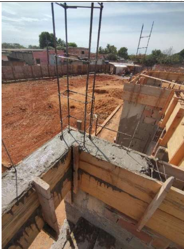
Foto 157 – Armadura, forma e concretagem de vigas e cintas
