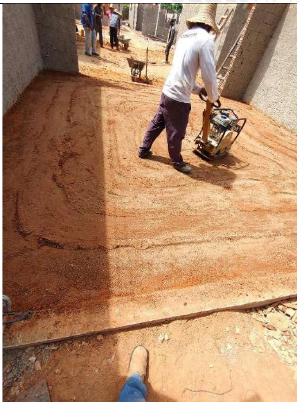
Foto 107 – Acerto compactado de piso
