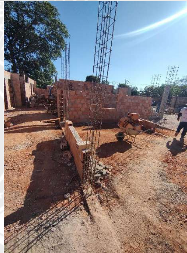
Foto 30 - Armação, forma e concretagem de pilares
