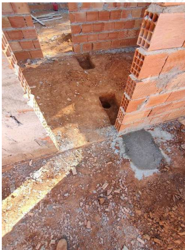
Foto 7 - Execução de cintas de paredes
