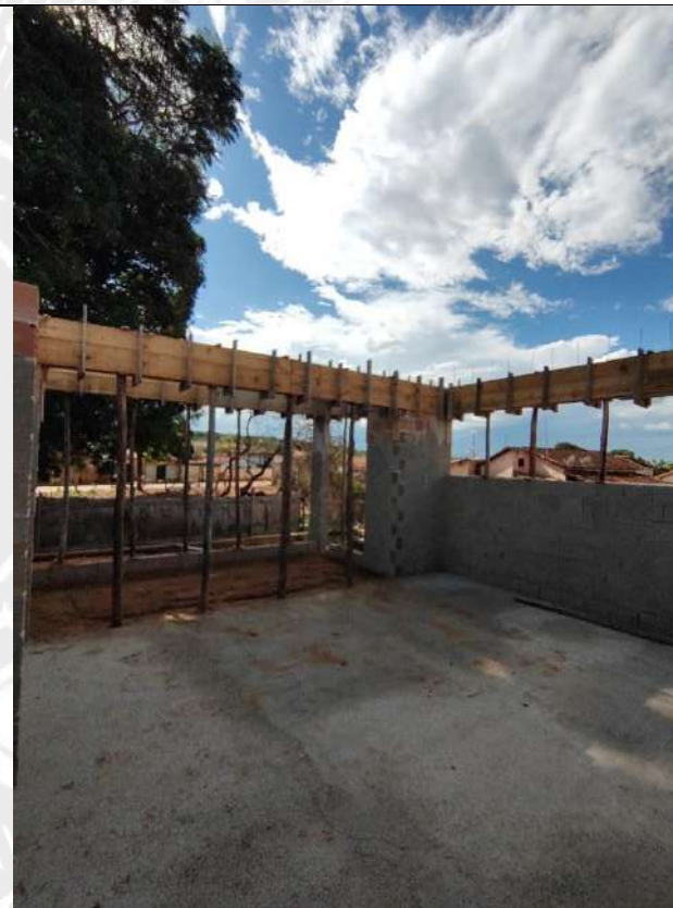
Foto 126 – Armação, forma e concretagem de vigas e cintas
