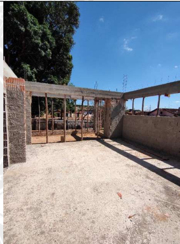
Foto 178 – Concretagem de piso
