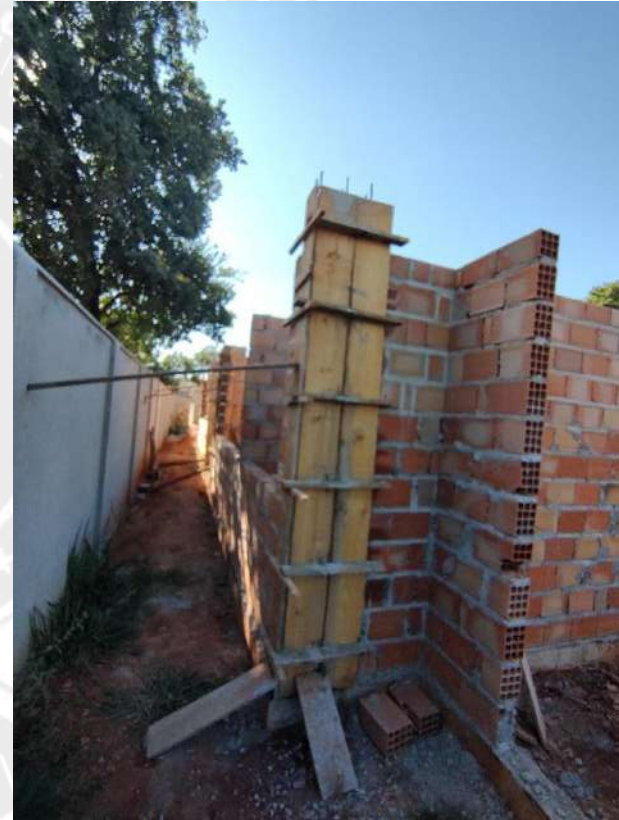
Foto 62 – Armação, forma e concretagem de pilares
