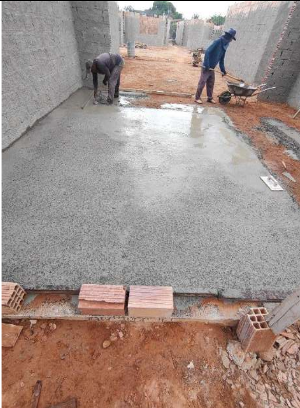
Foto 109 – Concretagem de piso
