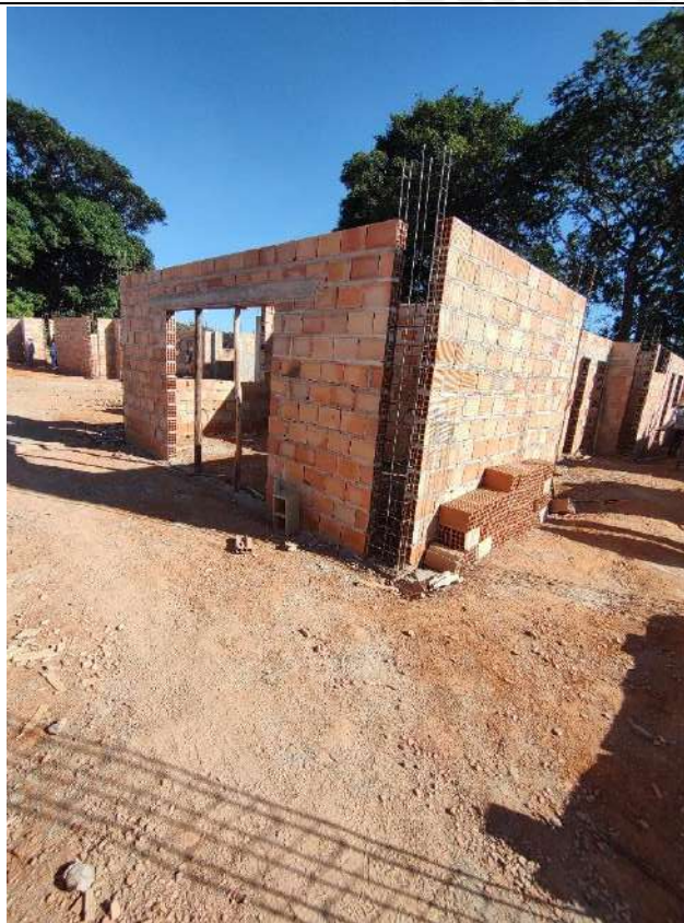
Foto 31 - Armação, forma e concretagem de pilares
