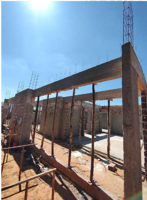
Foto 169 – Armação, forma e concretagem de vigas e cintas
