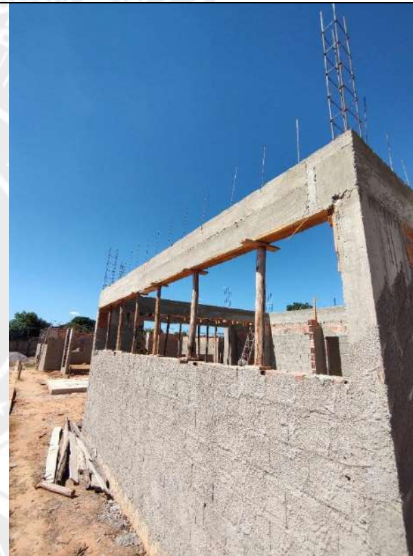
Foto 172 – Armação, forma e concretagem de vigas e cintas
