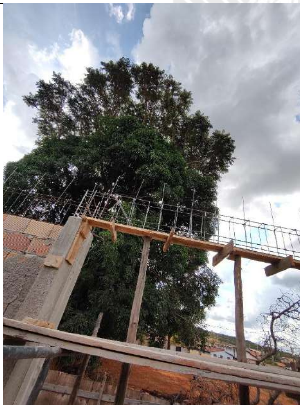
Foto 73 – Armação, forma e concretagem de vigas e cintas
