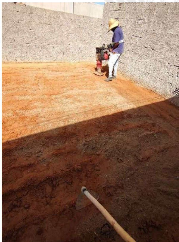
Foto 113 – Acerto compactado de piso
